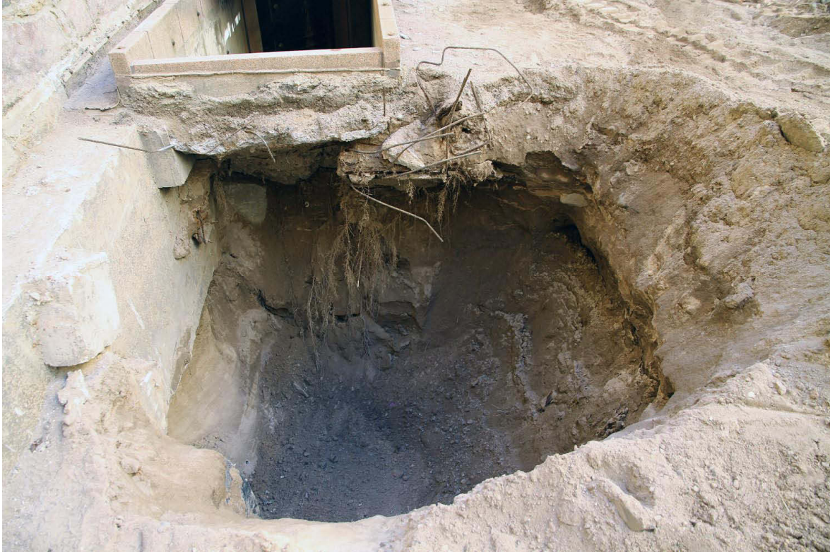
Kuva 27. Portaikon pohjoispuolelle on kaivettu syvä kaivanto sen purkamiseksi. Uusi portaikko tuli leveämmäksi. Kuvaussuunta S. 3.5.2013.
