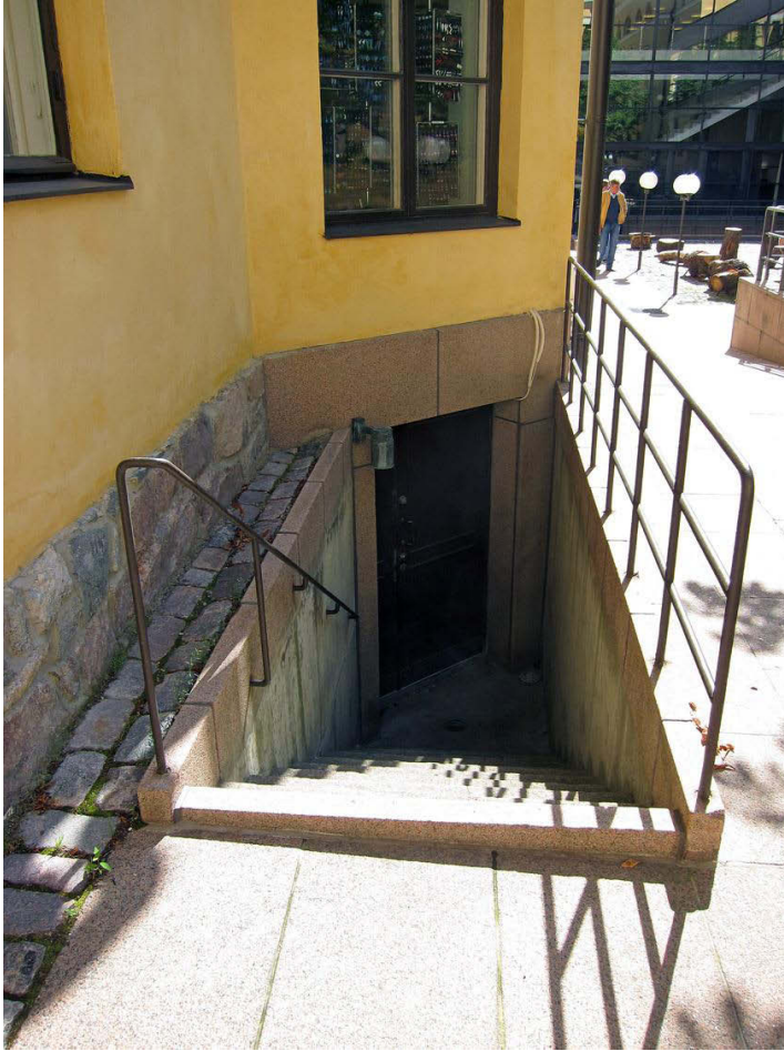
Kuva 3. Sivurakennuksen auditorioon johtava betoninen kellariportaikko, joka on rakennettu vuosina 1985-1988. Kuvaussuunta S. 20.8.2012.
