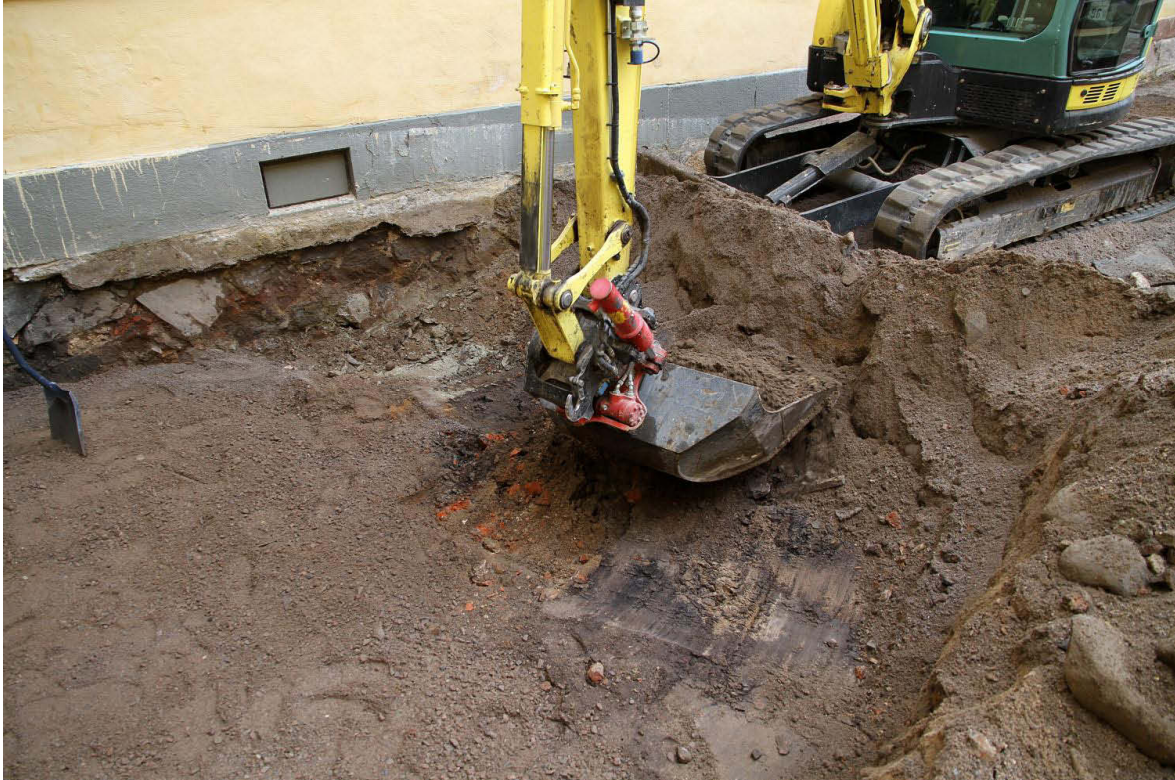
Kuva 19. Dokumentoidun profiilin eteläpään linjalta etelään päin on aloitettu konekaivaus. Kaivauksen tavoitesyvyydestä tuli esiin vanhempia kerroksia. Suurin osa oli uudempaa täytemaata. Vasemmalla on levitetty jo uutta soraa. Kuvaussuunta SE. 30.4.2013.
