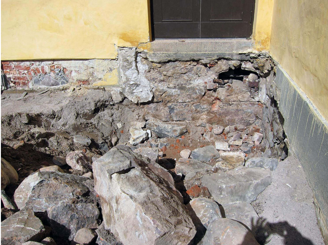
Kuva 11. Edellinen tilanne. Portaiden takaa nurkasta paljastui tiilirakenteinen kellariaukko ja sen vasemmalta puolelta toinen kivillä suljettu aukko. Kuvaussuunta N. 29.4.2013.
