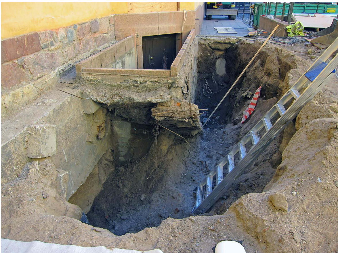
Kuva 30. Syvää kaivantoa on laajennettu portaikon länsipuolelle. Kuvaussuunta S. 6.5.2013.
