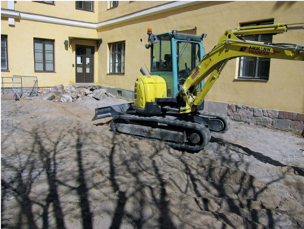
Kuva 7. Pihan kivilaatoitus ja nupulakiveys on poistettu rakennustyömaan pohjoisosasta. Kuvaussuunta NE. 29.4.2013.
