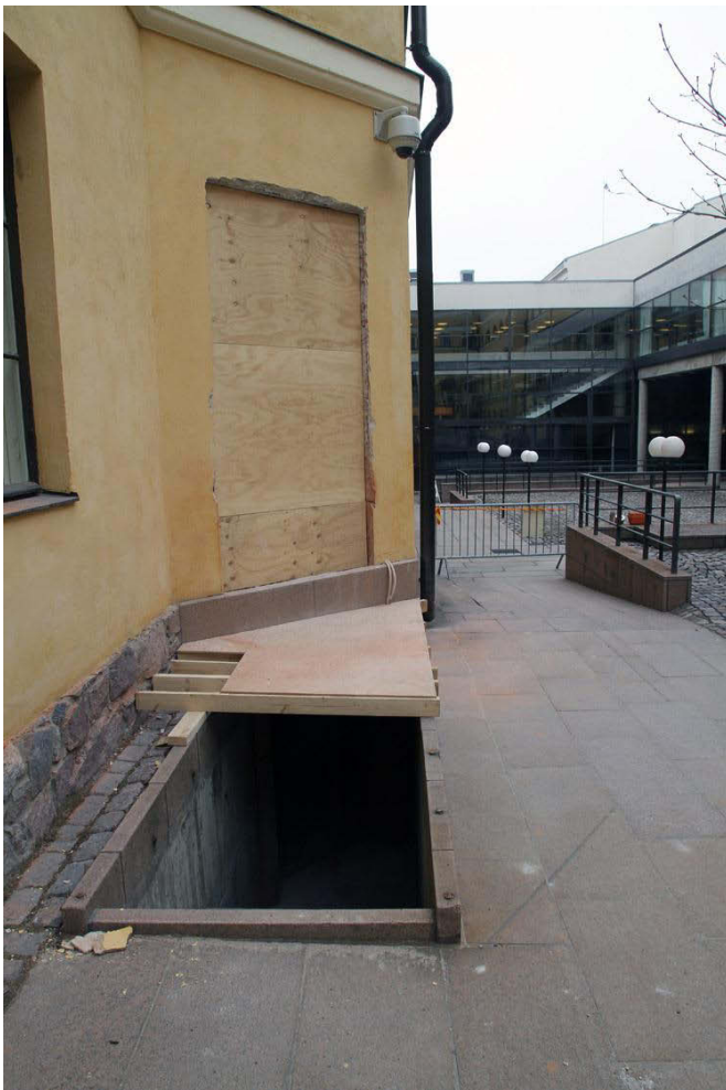
Kuva 6. Lähikuva sivurakennuksen kellariin johtavasta portaikosta ja uudesta oviaukosta sen yläpuolella. Kuvaussuunta S. 26.4.2013.
