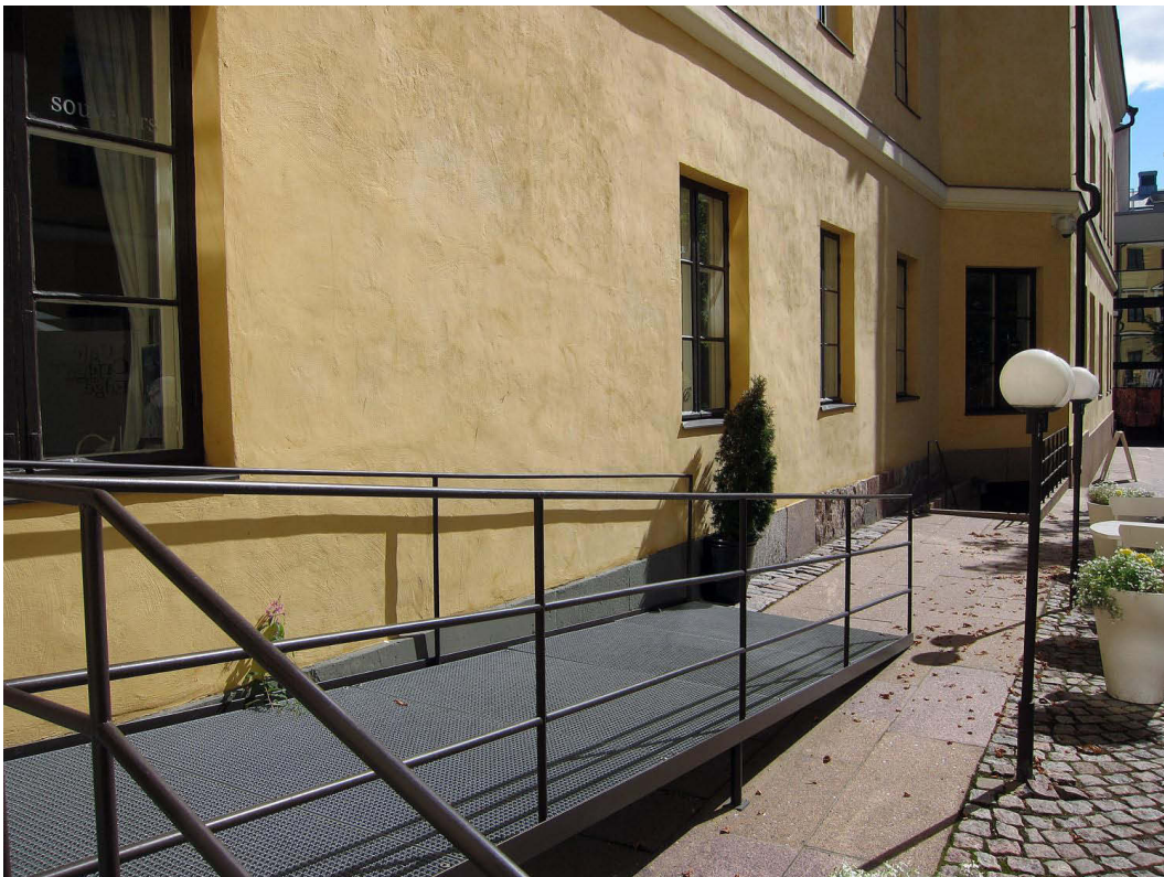
Kuva 2. Kuvan etualalla on päärakennukseen johtava metallinen luiska ja portaat. Taaempana on sivurakennuksen auditorioon johtava kellariportaikko. Sivurakennuksen levennysosa on tehty vuonna 1905. Kuvaussuunta SE. 20.8.2012.
