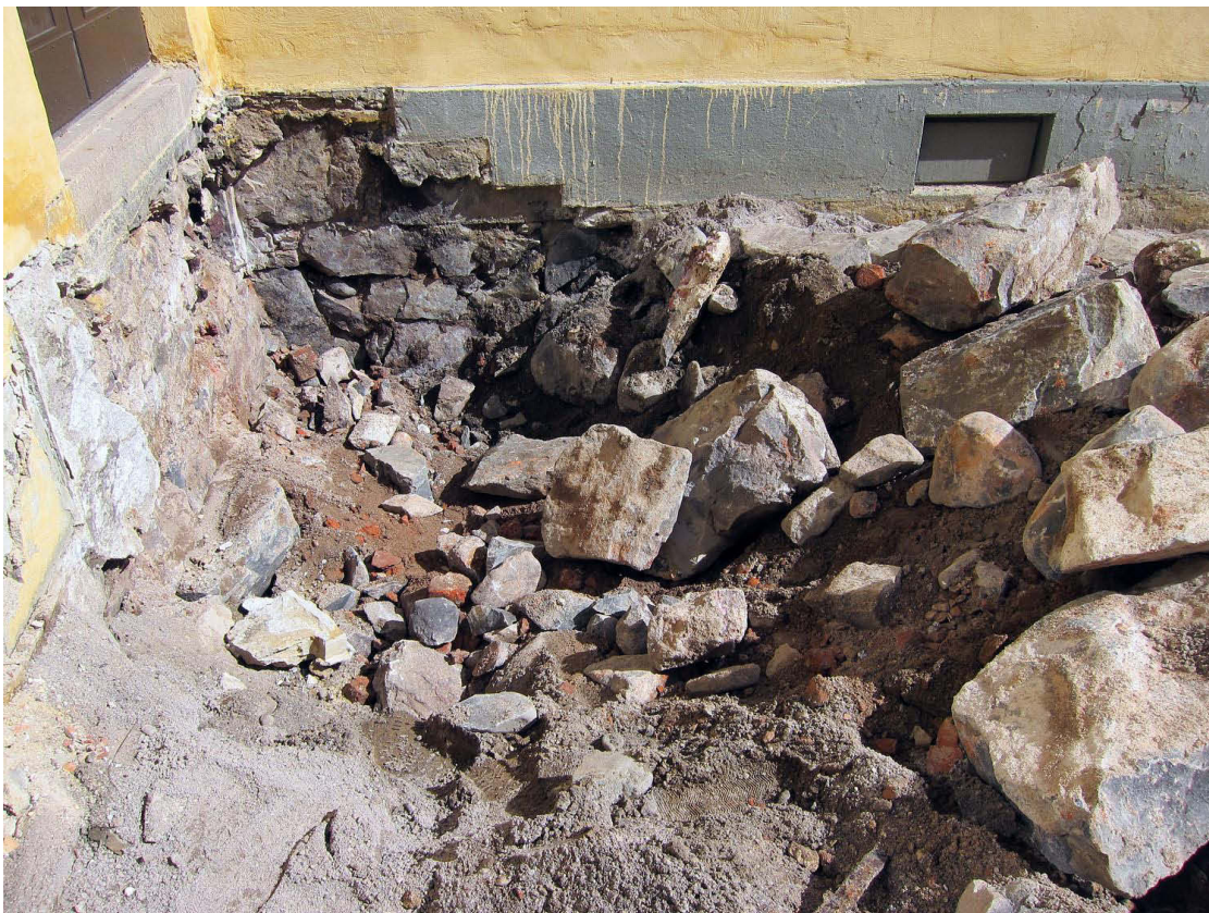
Kuva 10. Lähikuva edellisestä. Kuvaussuunta E. 29.4.2013.
