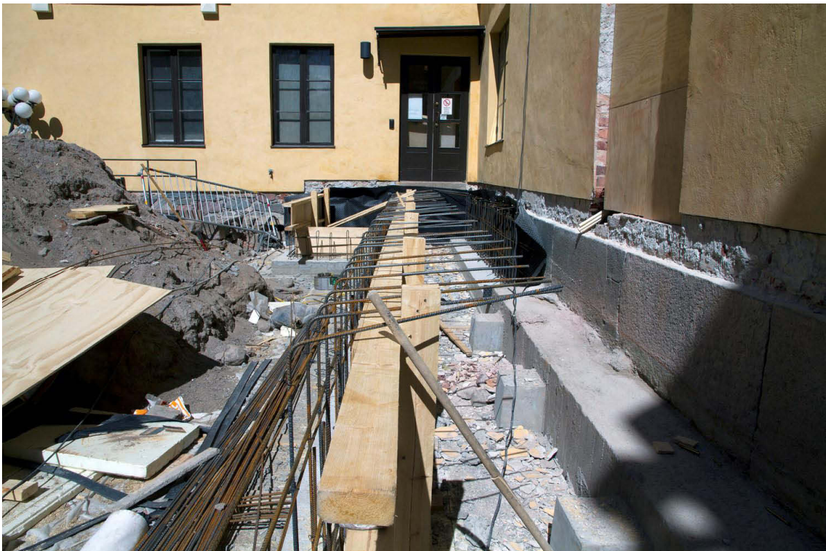
Kuva 40. Kuvassa näkyy pihan pohjoisosan uusia ja vanhoja valuja ja valutöiden raudoituksia. Oikealla edessä on vuosien 1985-88 perustusvaluja. Kuvaussuunta N. 16.5.2013.
