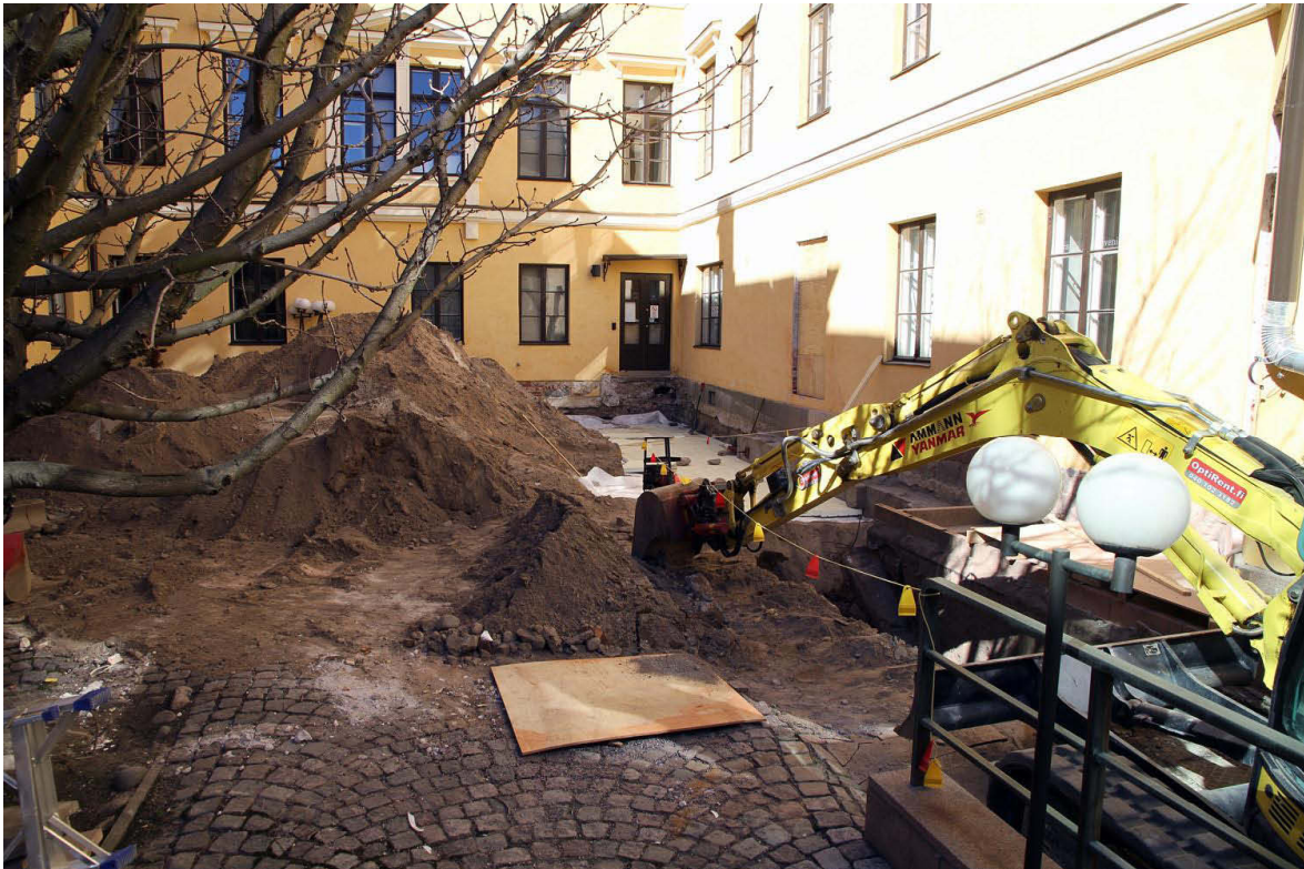
Kuva 29. Piha työmaan aikana. Kuvaussuunta NNE. 3.5.2013.
