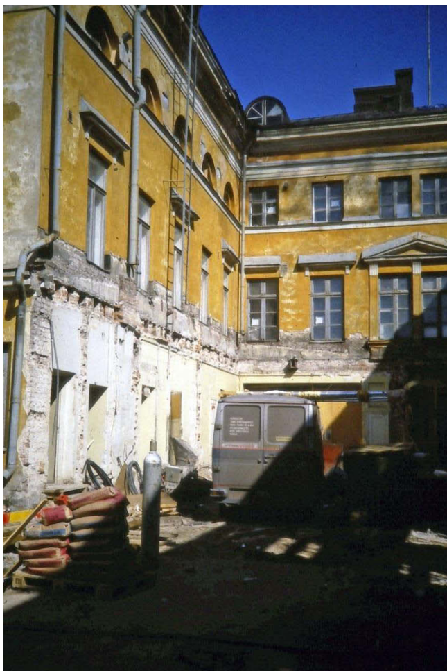
Matala piharakennus on purettu pois remontin alussa. HKM.
