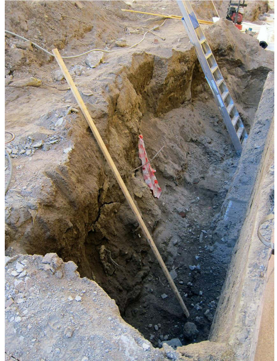
Kuva 38. Portaikon länsipuolinen kaivanto. Kuvaussuunta NNW. 6.5.2013.
