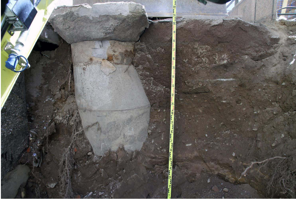
Kuva 43. Kaivannon eteläprofilissa ollut viemärikaivo ja täytemaat. Kuvaussuunta S. 16.5.2013.
