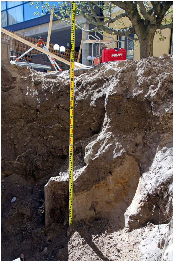
Kuva 44. Syvemmän kaivannon länsisivu. Latan vieressä vasemmalla näkyy metallinen H-pystypalkki ja oikealla luonnollinen hiekka. Kuvaussuunta SW. 16.5.2013.
