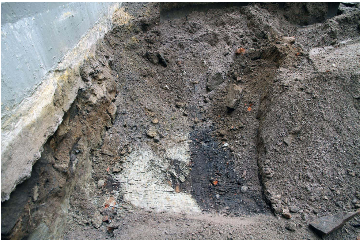
Kuva 20. Itäsiiven perustuseinän vieressä on rakennukseen liittyvää savea ja sen oikealla puolella vanhoja kerroksia. Kuvaussuunta S. 30.4.2013.
