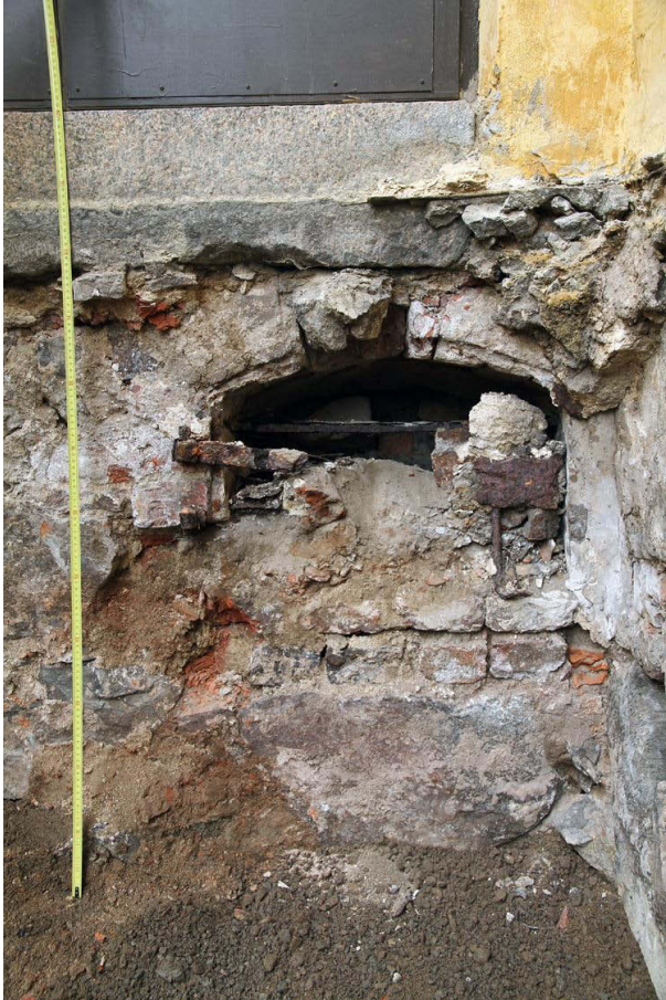
Kuva 13. Edellinen kohta, kun alue on kaivettu tavoitetasoonsa. Kuvaussuunta N. 30.4.2013.
