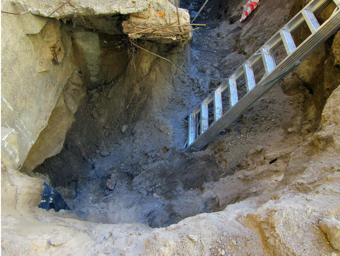
Kuva 33. Kaivanto portaikon alla. Kuvaussuunta S. 6.5.2013.
