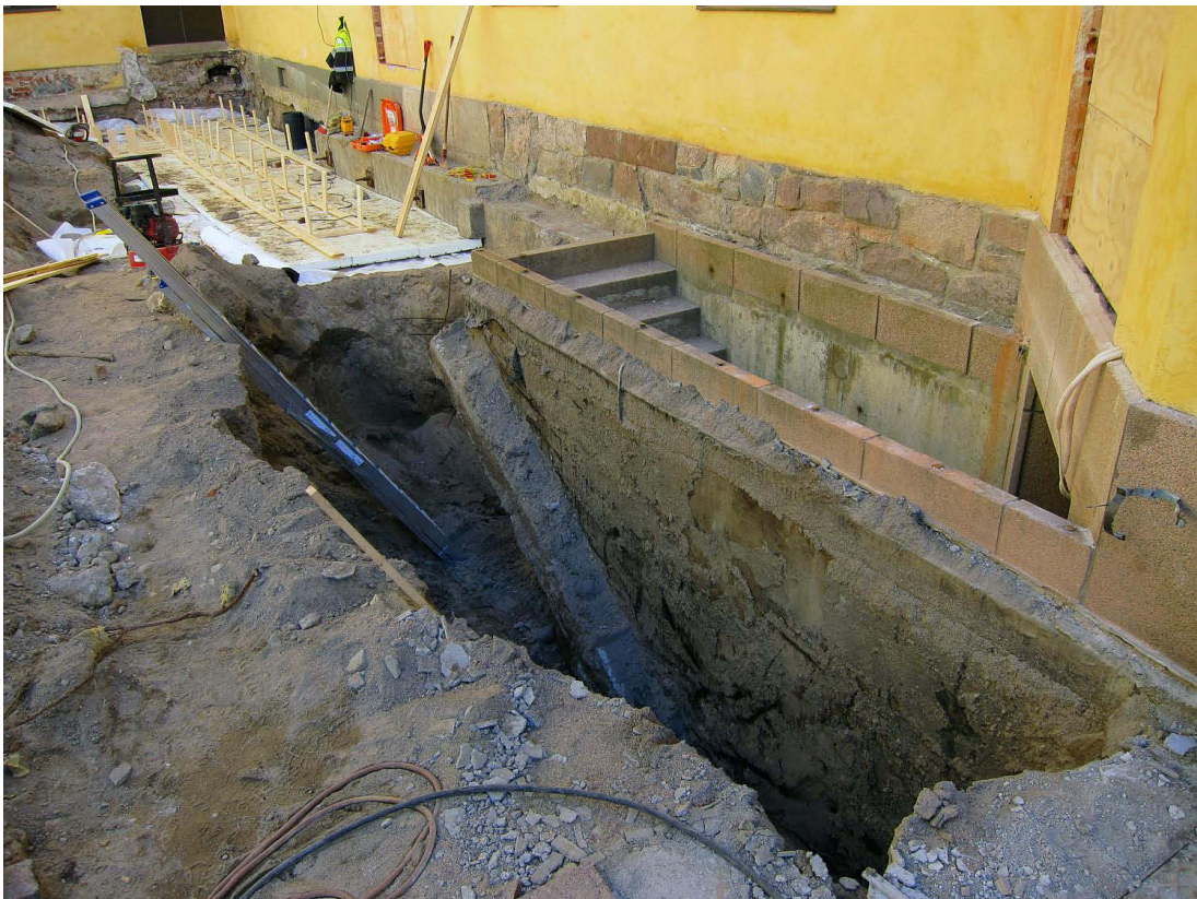
Kuva 36. Työmaa-alueen pohjoisosassa valutöitä valmistellaan. Kuvaussuunta NE. 6.5.2013.
