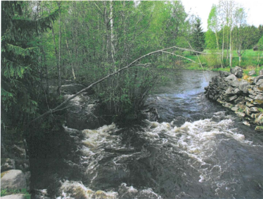
Kuva 10. Vanhan kivisillan lounaispuolella olevan pitkän kivisuisteen koillispääty. Kuvattu nykyiseltä pääuoman sillalta. MV/Päivi Kankkunen
