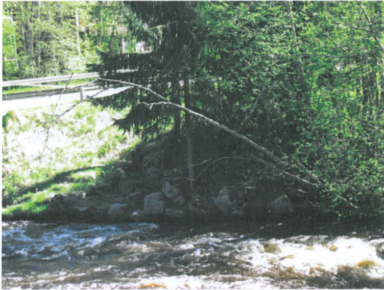
Kuva 3. Sillan eteläpuolisia rakenteita pääuoman pohjoisrannalla. Kuvattu vanhalta kivisillalta. MV/Päivi Kankkunen.
