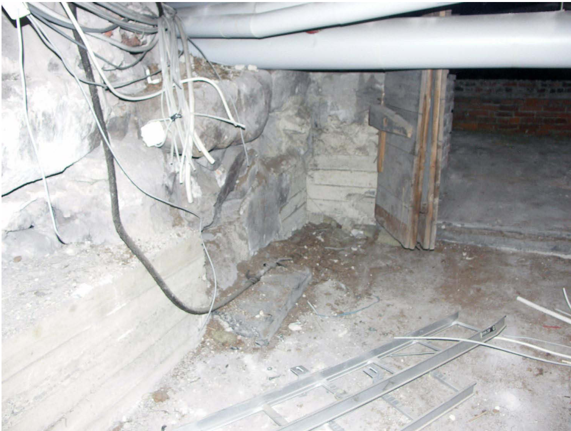
Kuva 14. Kellari II. Kellarin koillisnurkka. Seinän alaosassa näkyy megapaalutuksen betonivalut. Oikealla on oviaukko kellariin III. Kuvaussuunta NEE. 25.2.2009.
