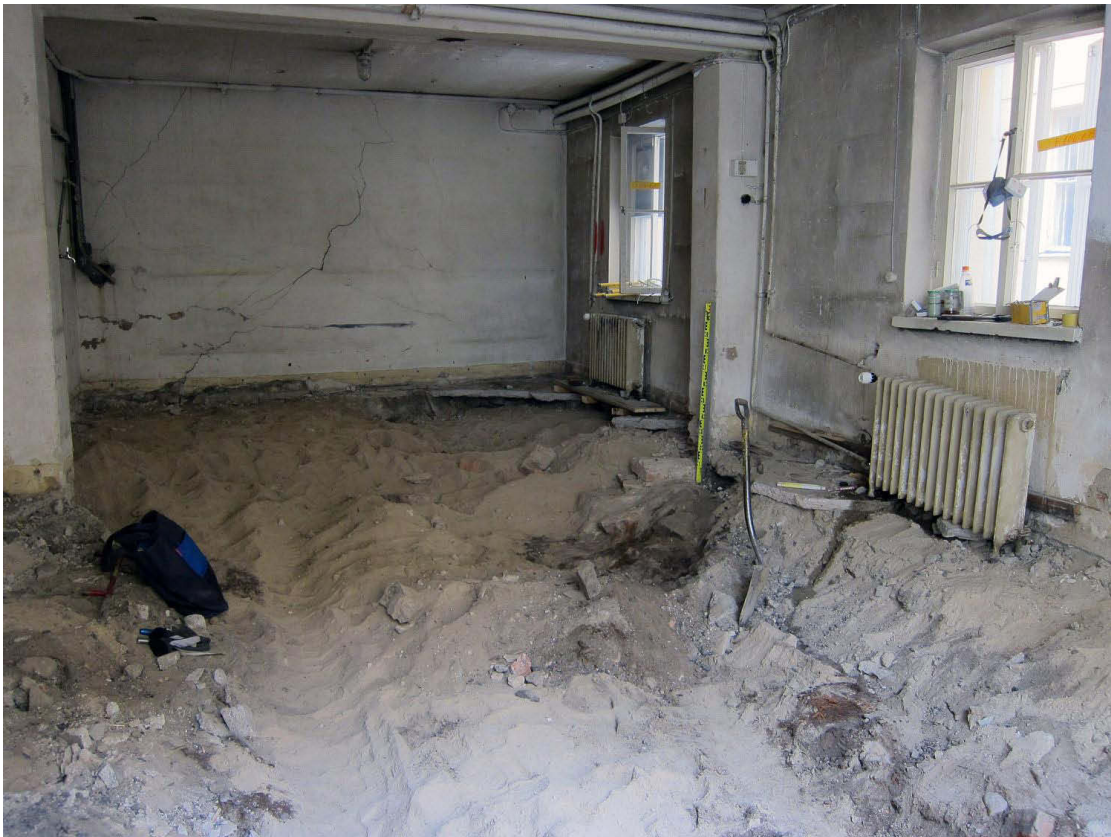
Kuva 229. Piharakennus, huone A. Tila on syvennetty tavoitekorkeuteensa. Poistettu osa käsitti vain irtonaista "uudempaa" hiekkaa. Kuvaussuunta NNE. 24.7.2012.
