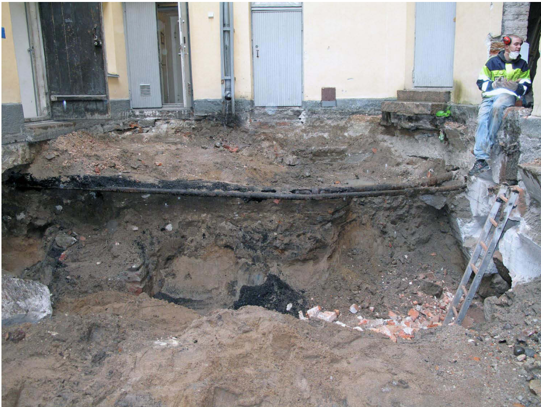
Kuva 123. Piha, pohjoisosa. Kaivannon pohjoisprofiili. Profiilin länsiosa oli tuhoutunut tiilirakenteisen kaivon takia ja itäosa megapaalutuksen takia. Kerrokset näkyvät selvästi profilissa. Keskiosan alaosassa saattoi olla vanhempia kerroksia, vaikka nekin näyttivät olevan suurimmaksi osaksi uudempia sekoittuneita kerroksia. Kuvaussuunta N. 16.9.2009.
