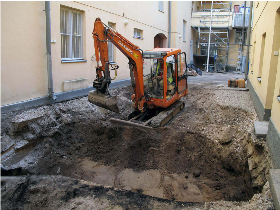
Kuva 118. Piha, pohjoisosa. Kaivanto levennetään. Kuvaussuunta SSE. 15.9.2009.
