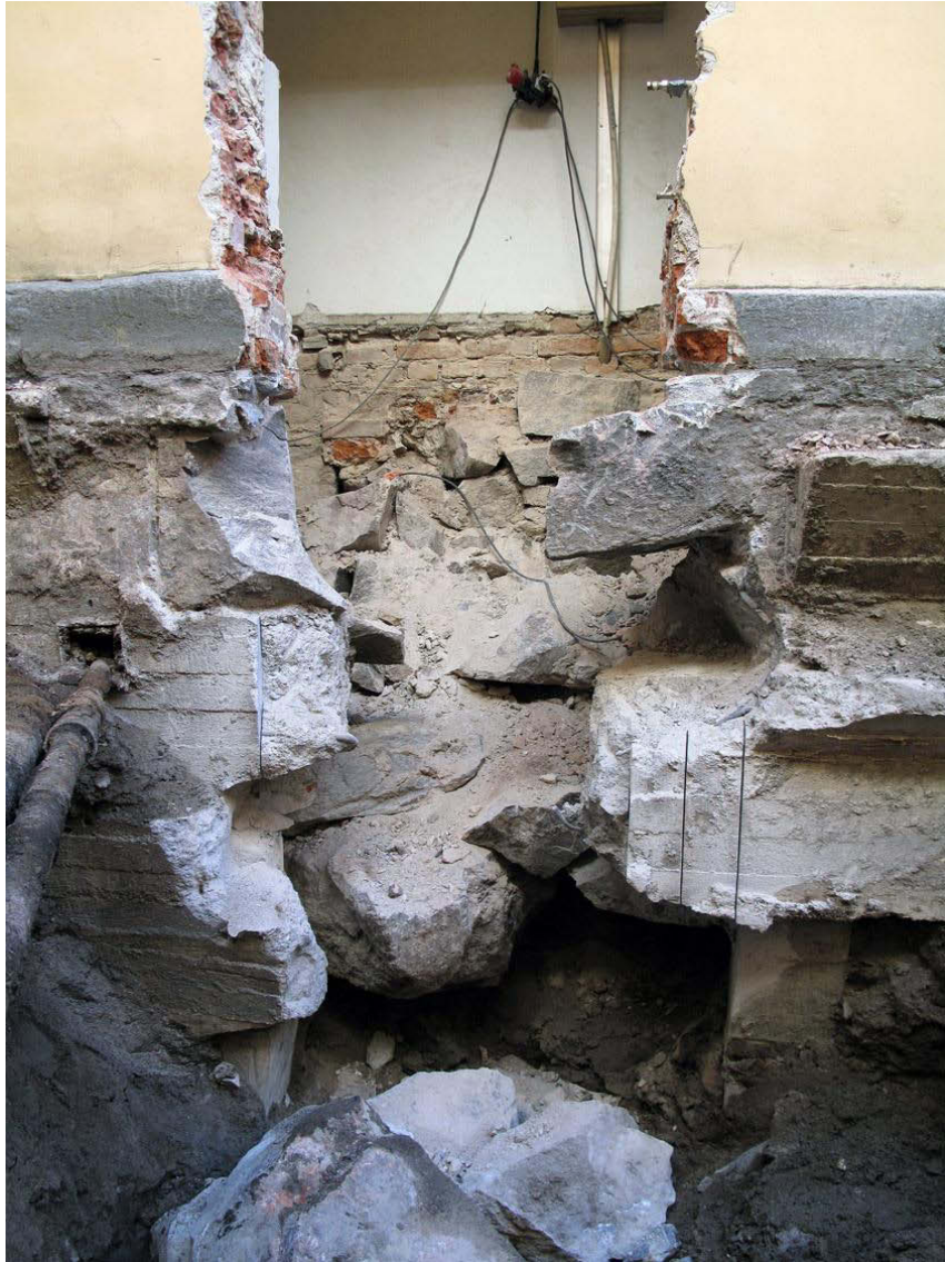
Kuva 127. Piha, pohjoisosa. Kaivannon itäpää Helenankadun siiven länsiseinän kohdalla. Aukon molemmilla puolilla näkyy megapaalut. Aukon kohdalta on sahattu pois betoniperustus. Kuvaussuunta E. 17.9.2009
