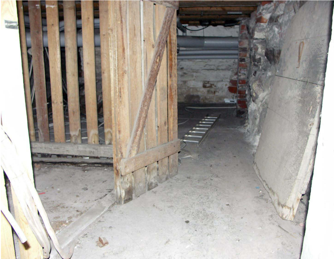
Kuva 9. Kellari II. Lampan talon kellari II Pohjoisesplanadin puoleisen päärungon pihan puoleisessa osassa. Kuvassa näkyy tilan länsiosa kuvattuna kellarin pihalle johtavan portaikon oven kohdalta. Kuvaussuunta S. 25.2.2009.
