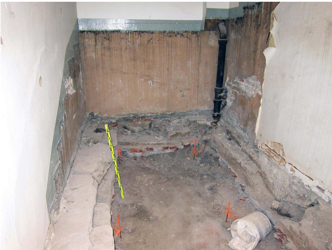
Kuva 248. Pih arakennus, huone B. Tilan kova pohja on poistettu ja tila on kaivettu tavoitetasoonsa rakennuksen perustusten vahvistamisen takia. Kuvaussuunta W. 15.8.2012.
