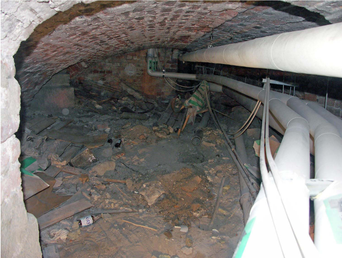
Kuva 96. Kellari IX. Yleiskuva tilasta, jossa oli vähemmän hiekkaa ym. johtuen megapaalutuksesta. Kuvaussuunta W. 1.7.2009.
