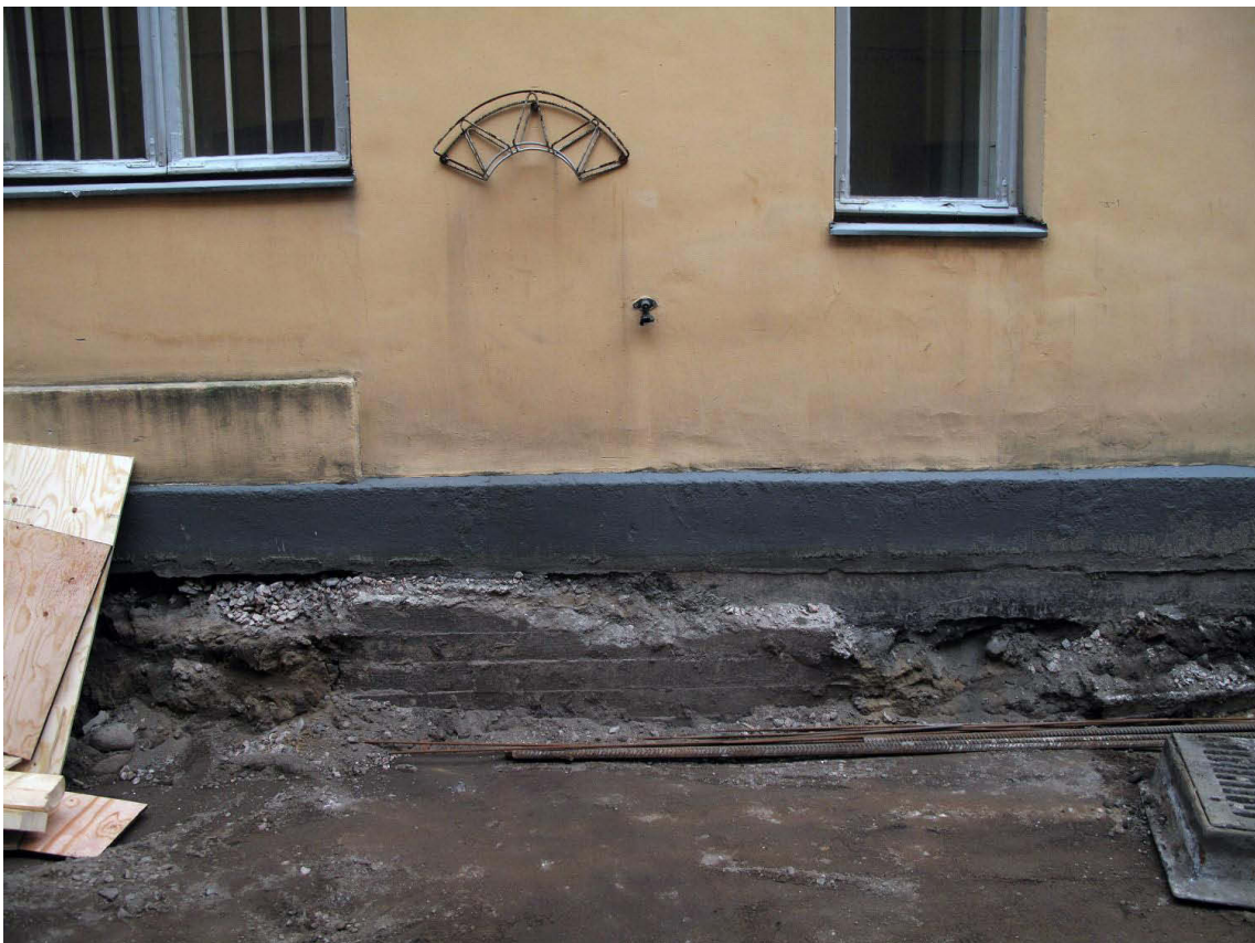
Kuva 144. Piha, keskiosa. Mariankadun siiven länsiseinää, jossa näkyy megapaalutuksen betonivaluosa. Kuvaussuunta E. 15.10.2009.
