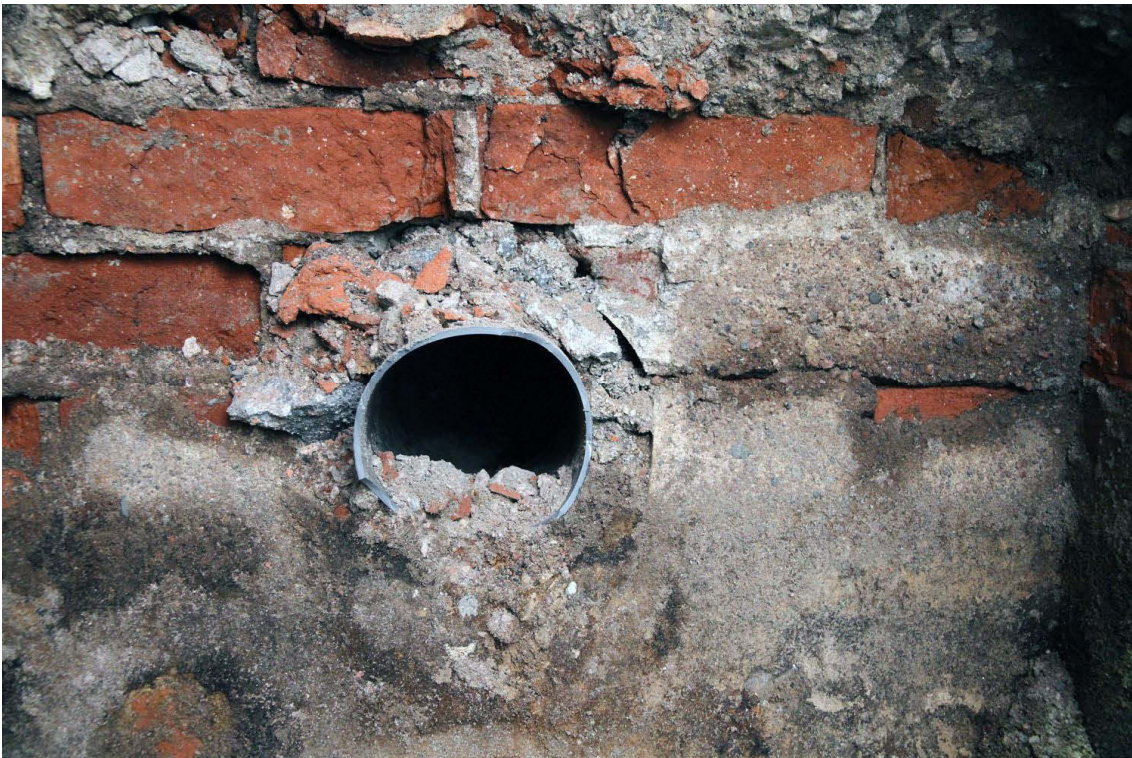
Kuva 261. Porttikonki. Lähikuva länsiseinästä, jossa on vanhan putken sisään laitettu muoviputki. Kuvaussuunta W. 5.4.2013.
