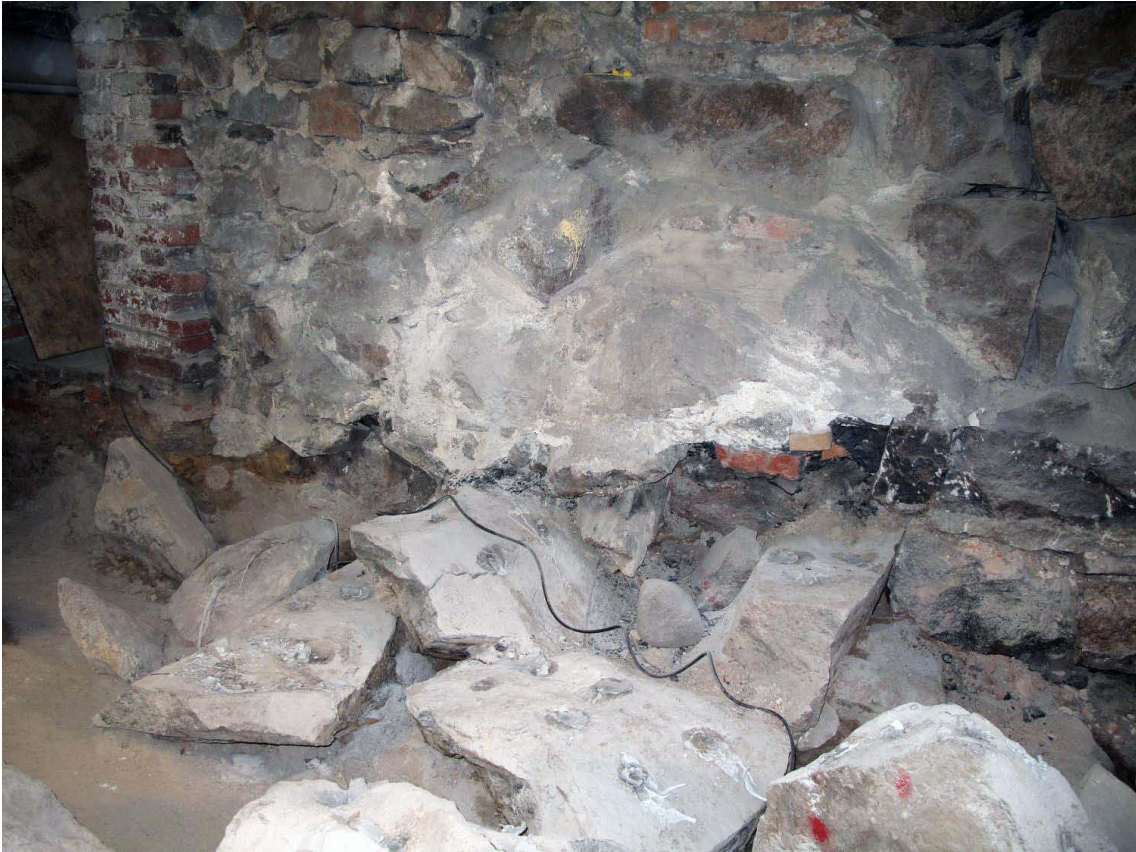
Kuva 23. Kellari II. Irtokiviä ja seinän perustuskiviä on porattu kiven halkomisen takia tilan länsiosassa. Kuvaussuunta SW. 8.10.2009.
