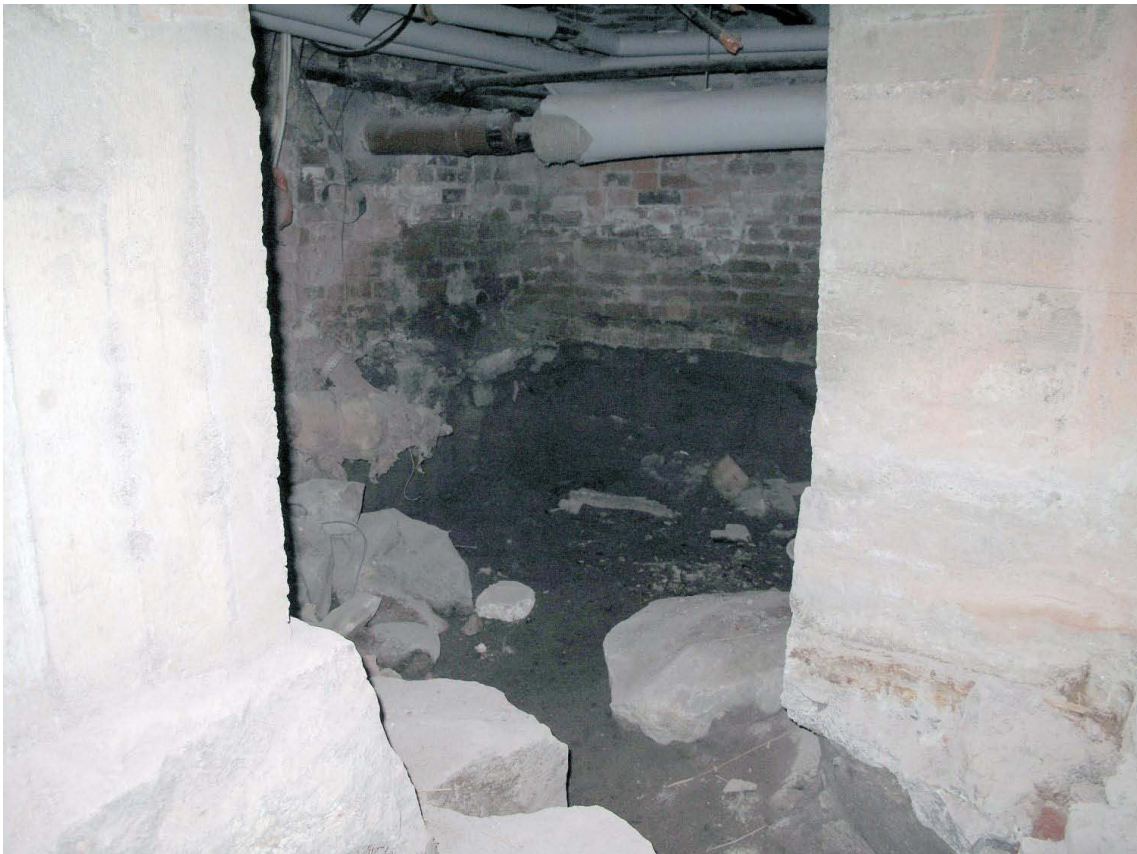
Kuva 58. Kellari V. Tilan pääosa lattiatason alentamisen jälkeen. Kuvaussuunta NE. 14.9.2009.
