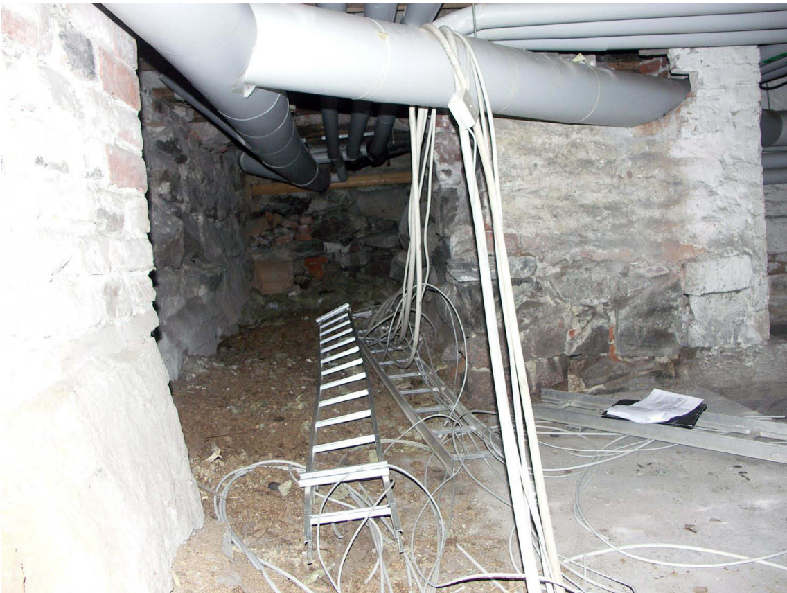
Kuva 12. Kellari II. Kellaritilan itäosa. Kuvaussuunta S. 25.2.2009.
