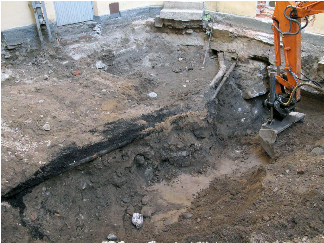
Kuva 108. Piha, pohjoisosa. Kaivanto kaivettiin kahden putken eteläpuolelle. Kuvaussuunta NE. 15.9.2009.
