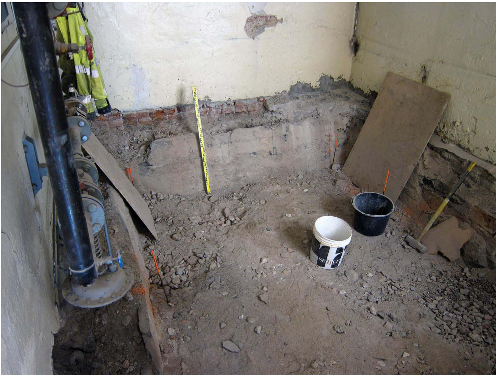
Kuva 252. Pi harakennus, huone C. Lattia ja sen alapuoliset kerrokset on poistettu tavoitetasoon. Kuvaussuunta NWW. 15.8.2012.
