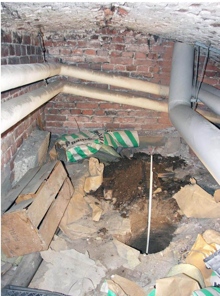
Kuva 93. Kellari VIII. Koekuoppa 7 sijaitsi tilan keskiosassa. Kuvaussuunta N. 1.7.2009.
