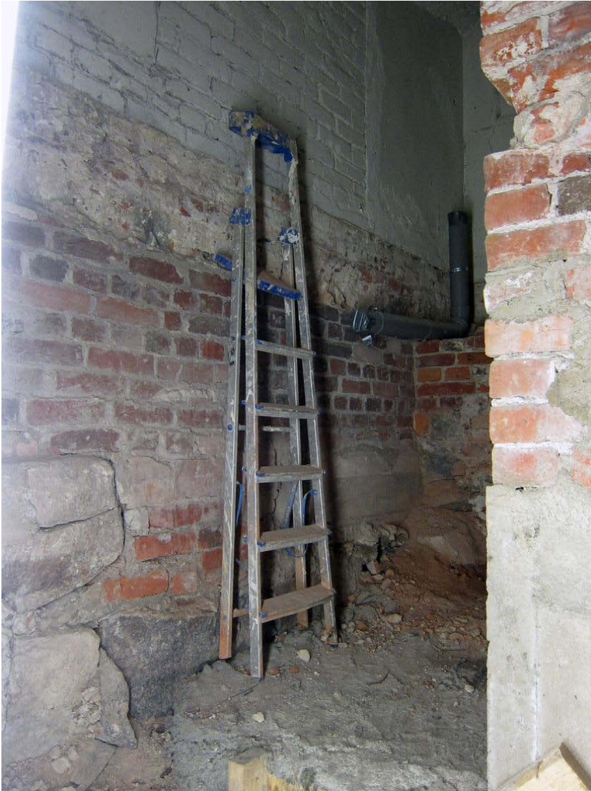
Kuva 60. Kellari V. Tilan länsiseinän perustuksen tiilikoroke on purettu ja perustuskiviä on lohkottu. Kellarin tiiliholvi on myös purettu. Vrt kuvat 51 ja 57. Kuvaussuunta NW. 15.8.2012.
