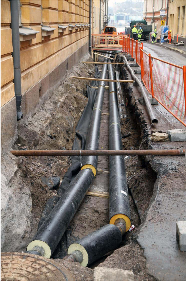
Kuva 275. Helen ankatu. Kaukojäähdytysputket on asennettu kaivantoon. Kuvaussuunta S. 17.4.2013.
