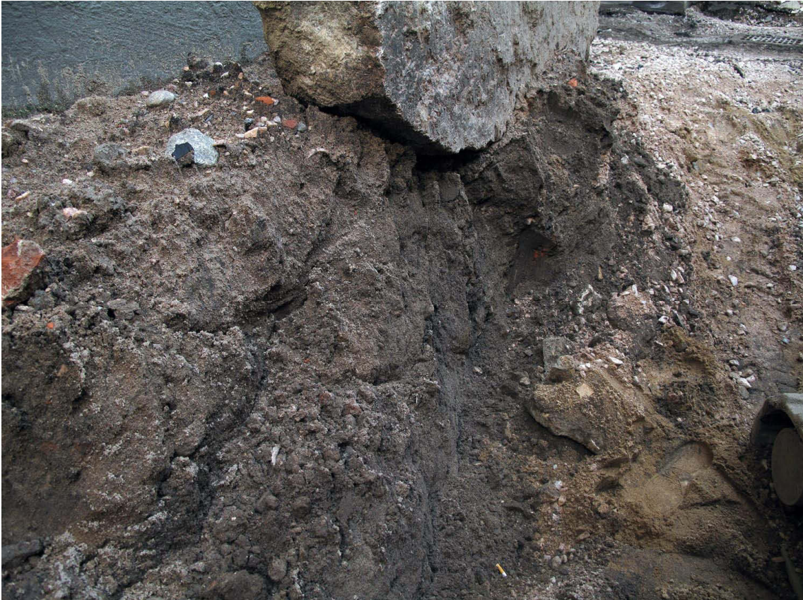
Kuva 149. Piha, keskiosa. Pihan kapeamman osan Mariankadun siiven luona näkyi kaivussyvyydellä vain täyttömaata siiven megapaalutuksen takia. Kuva on heti porttikongin pohjoispuolelta. Kuvaussuunta SE. 8.10.2009.
