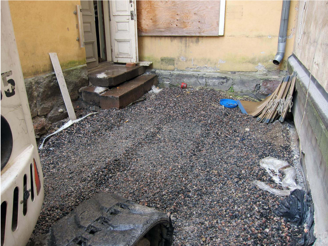
Kuva 169. Piha, lounaisosa. Hissin perustuskuopan, havaintopisteen 8, alue. Kuvaussuunta S. 23.7.2012.
