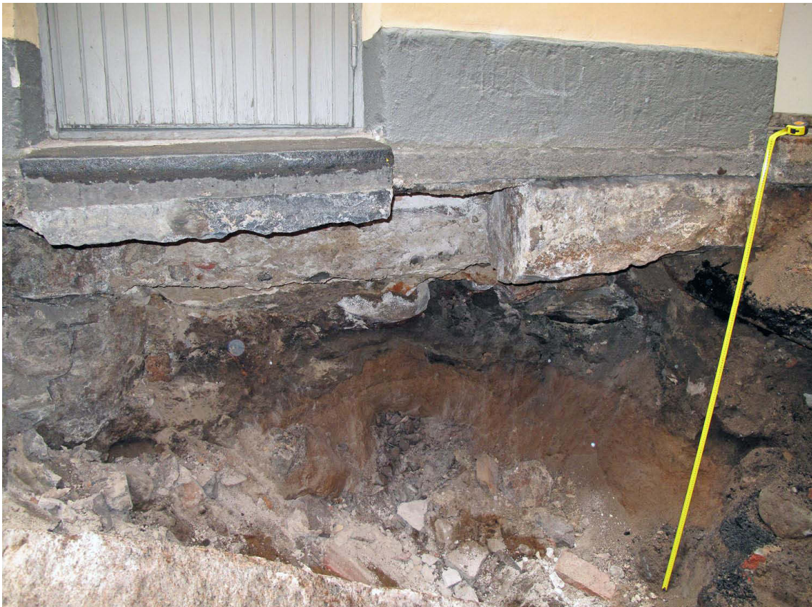
Kuva 119. Piha, pohjoisosa. Kaivantoa on kaivettu piharakennuksen itäseinän alle. Kuvaussuunta NW. 16.9.2009.
