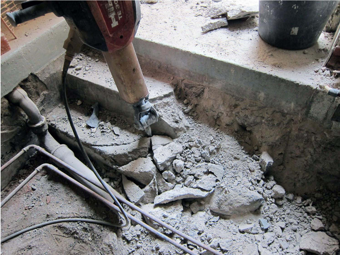
Kuva 257. Piharakennus, huone D. Portaita hakataan rikki. Kuvaussuunta SE. 30.7.2012.
