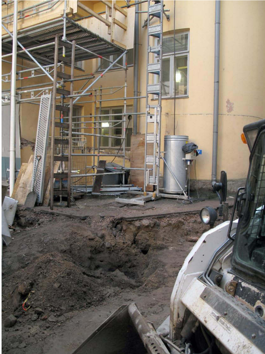
Kuva 163. Piha, eteläosa. Havaintopisteen 7 pohjoispuolelle kaivettiin maaleikkauksen kulmaan syvämpi kuoppa maakerrosten paksuuksien dokumentoimiseksi. Kuvaussuunta SE. 19.10.2009.
