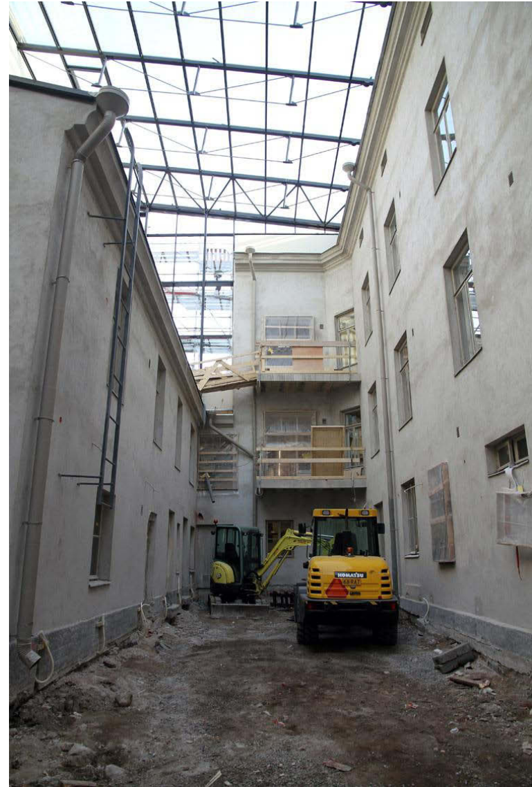
Kuva 279. Piha. Pihan pohjoisosa uusine lasikatteineen. Kuvaussuunta N. 5.4.2013.
