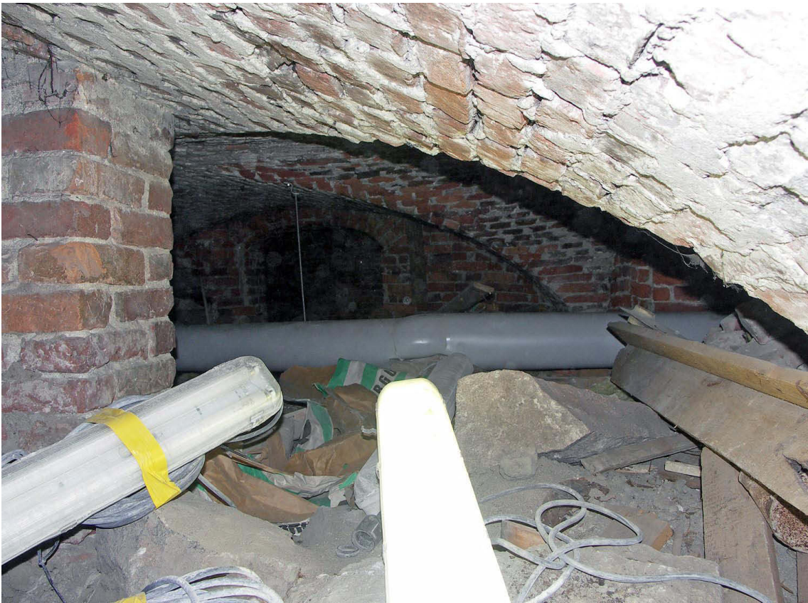
Kuva 87. Kellari VIII. Yleiskuva tilan länsipuoliskosta, joka oli täynnä hiekkaa ja tiili- ja laastimurskaa ilmeisesti megapaalutuksesta johtuen. Kuvaussuunta S. 1.7.2009.
