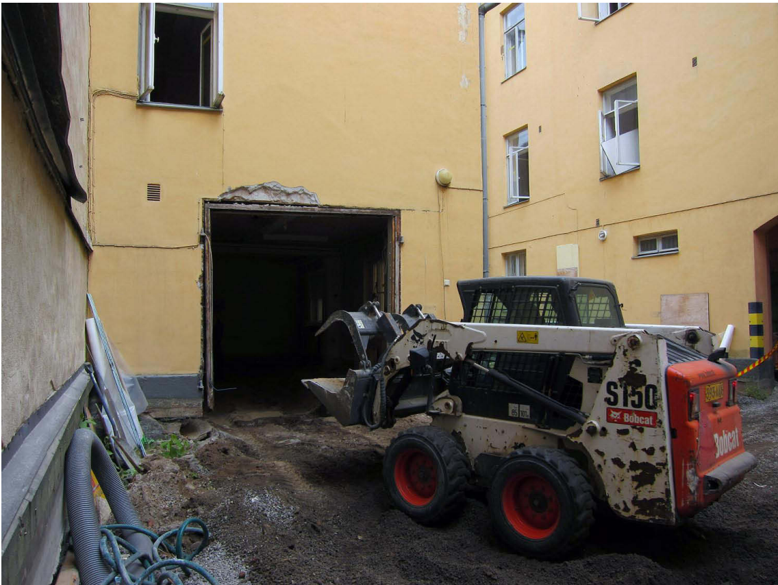
Kuva 226. Piharakennus, huone A. Purkamiseen käytetty bobcat "pihteinen". Kuvaussuunta N. 24.7.2012.
