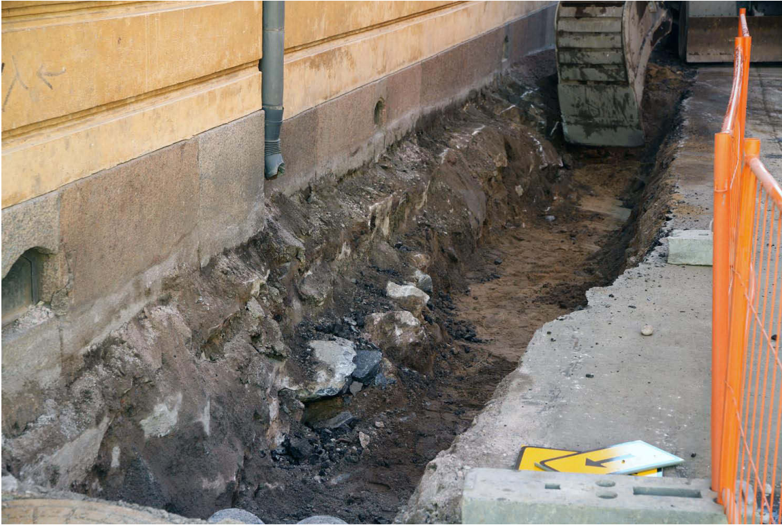
Kuva 264. Helen ankatu. Kaivanto Helankadun pohjoispäässä työ- ja elinkeinoministeriön kohdalla. Kuvaussuunta SE. 3.4.2013.
