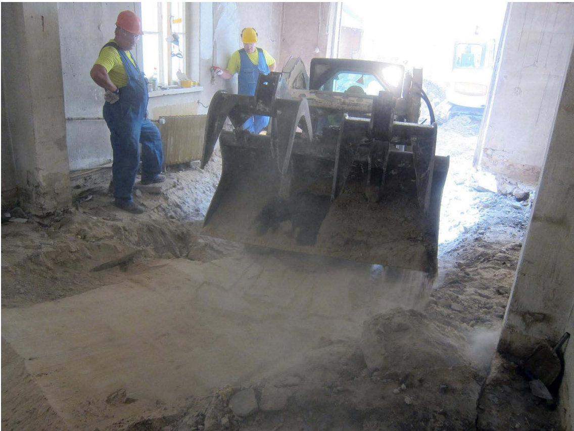
Kuva 228. Piharakennus, huone A. Bobcat työssään. Kuvaussuunta SE. 24.7.2012.
