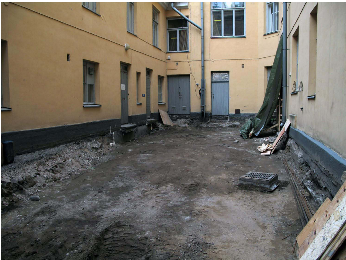
Kuva 142. Piha, keskiosa. Pihan pohjatyöt on tehty. Kuvaussuunta N. 15.10.2009.
