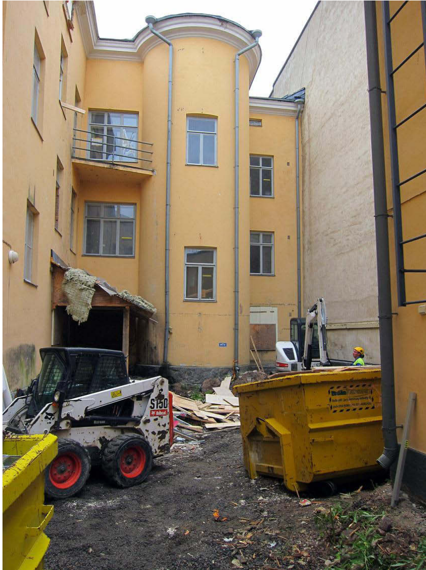
Kuva 167. Piha, lounaisosa. Pihan eteläosa hissien perustusköppän kaivamisvaiheessa. Kuvaussuunta S. 23.7.2012.
