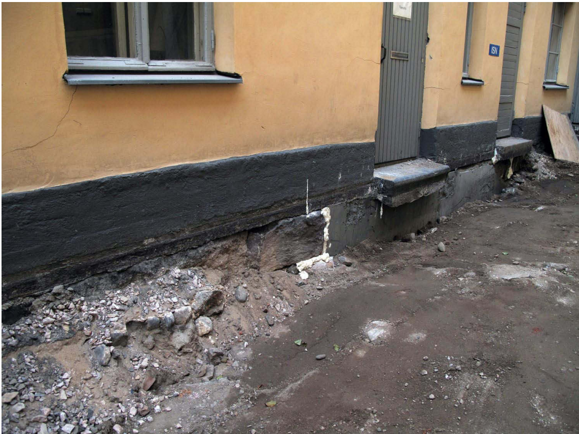
Kuva 143. Piha, keskiosa. Piharakennus kivijalkaa. Askelkivien alla näkyy uusi betoniperustus. Kuvaussuunta NW. 15.10.2009.
