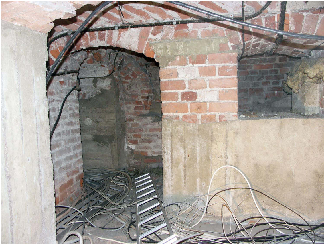
Kuva 54. Kellari V. Kuva edellisestä tilasta. Taustalla vasemmalla on oviaukko kellariin IV. Pilarin takana on tilan länsiosa. Kuvaussuunta SWW. 4.3.2009.
