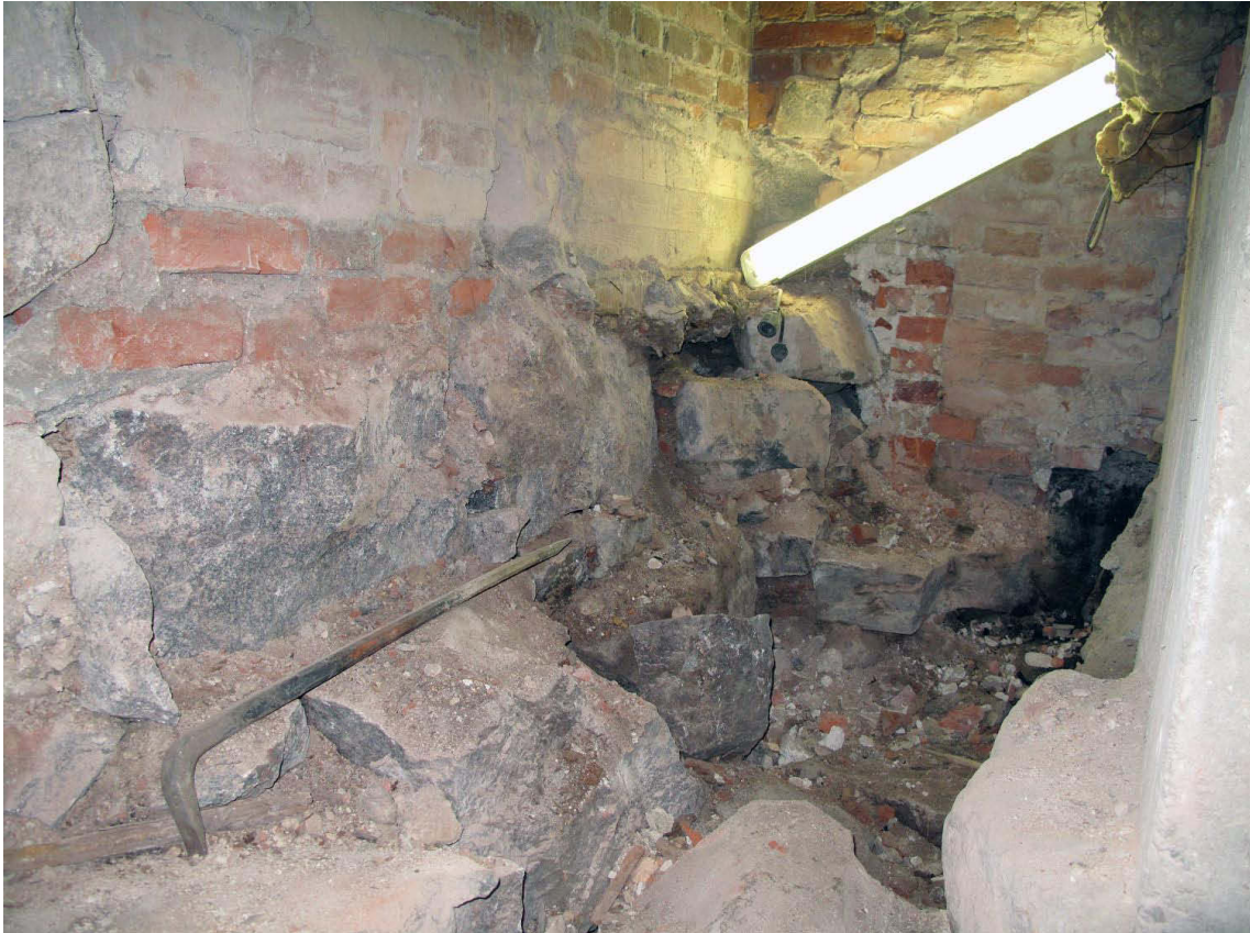
Kuva 57. Kellari V. Tilan länsiossa lattiatason alentamisen jälkeen. Länsiseinän perustuksen tiilikoroke on purettu pois. Kuvaussuunta NW. 14.9.2009.
