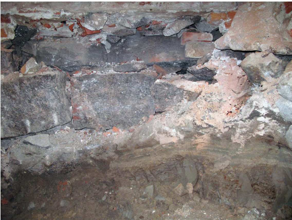
Kuva 40. Kellari III. Lähikuva tilan lounaisnurkasta, jossa näkyy pian kiviperustuksen ja sen alapuolisen sekoittuneen hiekan alla luonnollinen harmaa savi. Kuvaussuunta S. 21.9.2009.
