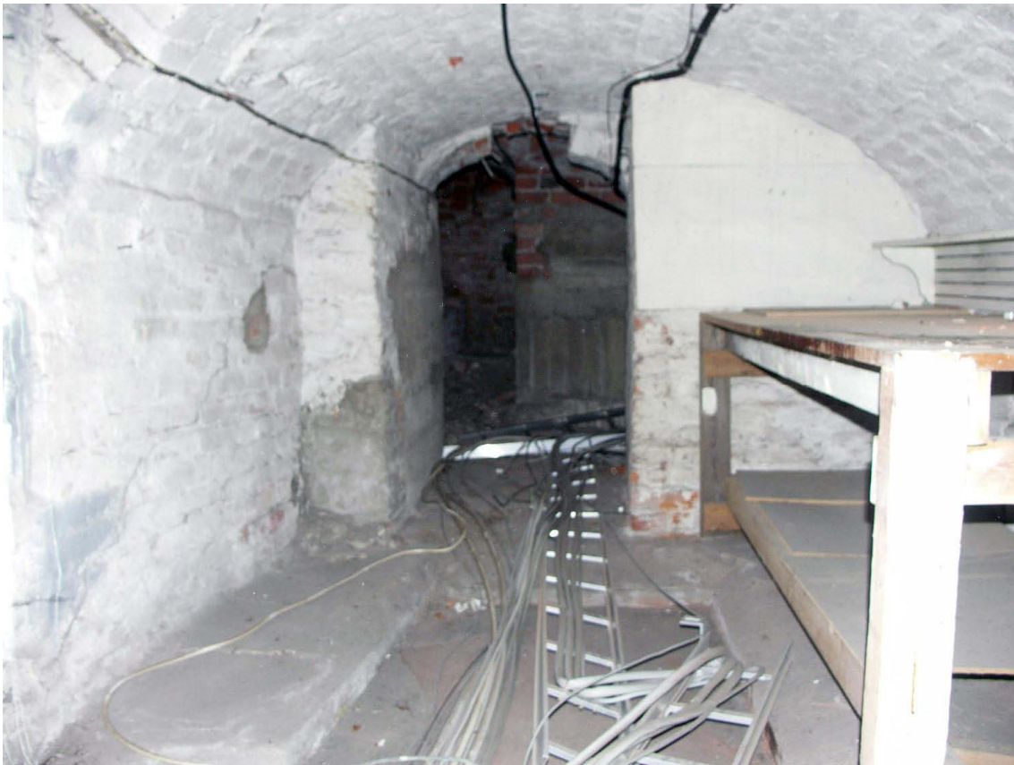
Kuva 43. Kellari IV. Yleiskuva tilasta. Kuvaussuunta N. 25.2.2009.
