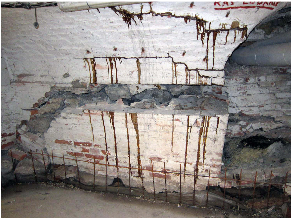
Kuva 50. Kellari IV. Tilan itäseinä on repeytynyt pahasti töiden aikana. Vrt. kuva 44. Kuvaussuunta NE. 15.8.2012.
