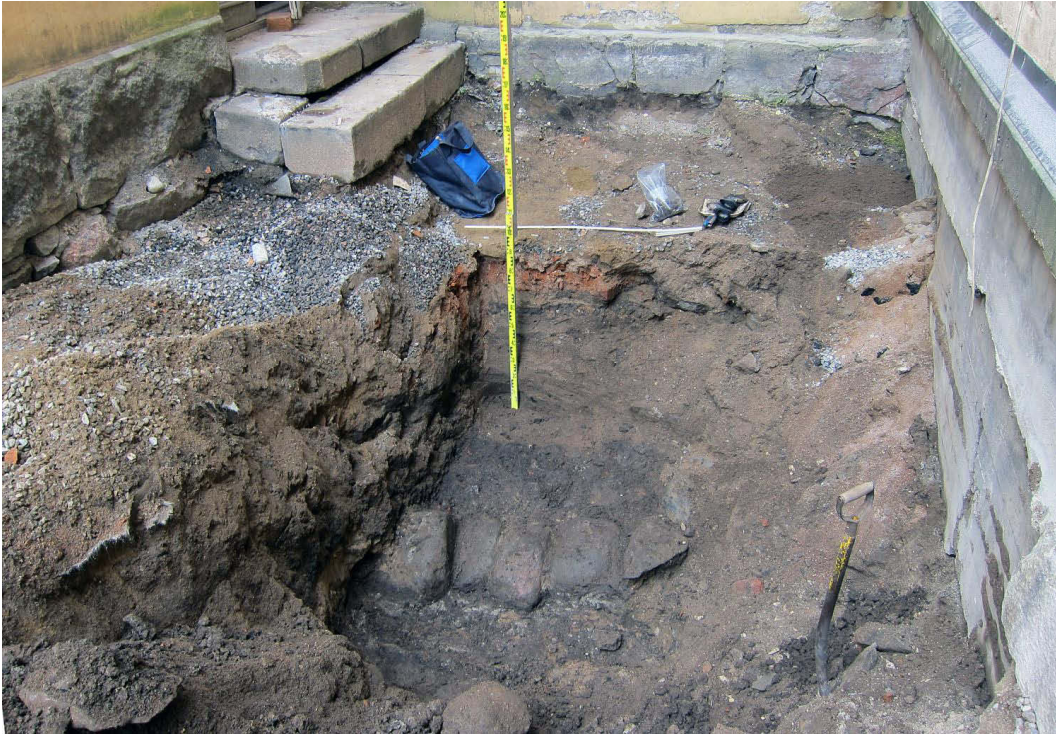
Kuva 179. Piha, lounaisosa. Havaintopisteen 8 aluskivien eteläpuolista aluetta on kaivettu vähän syvemmälle. Kuvaussuunta S. 23.7.2012.
