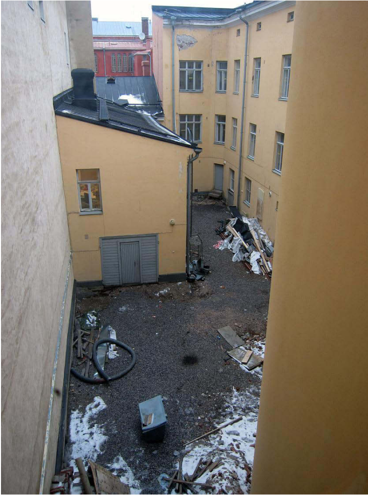
Kuva 103. Piha. Yleiskuva pihasta ennen viimeisen rakennusvaiheen alkamista kesällä 2012. Kuvaussuunta N. 13.1.2012.
