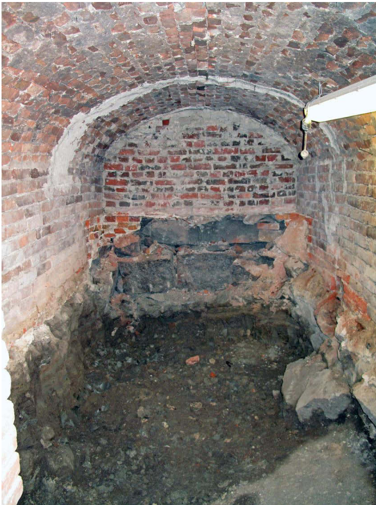
Kuva 37. Kellari III. Tilan tiililattia, tiilikoroke ja niiden alapuolisia kerroksia on poistettu tilan lattian alentamisen takia. Kuvaussuunta E. 21.9.2009.
