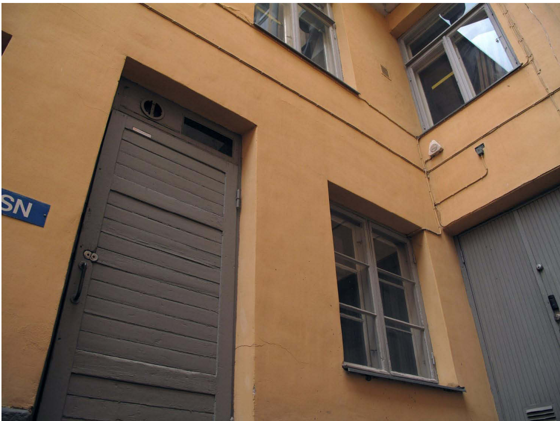
Kuva 130. Piha, pohjoisosa. Edellinen tilanne, kuvassa piharakennus. Kuvaussuunta NW. 22.9.2009.
