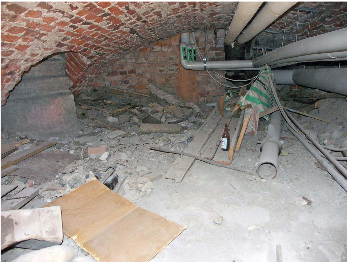
Kuva 97. Kellari IX. Edellinen tilanne. Vasemmalla on betoniportaait ylöspäin. Kuvaussuunta W. 1.7.2009.
