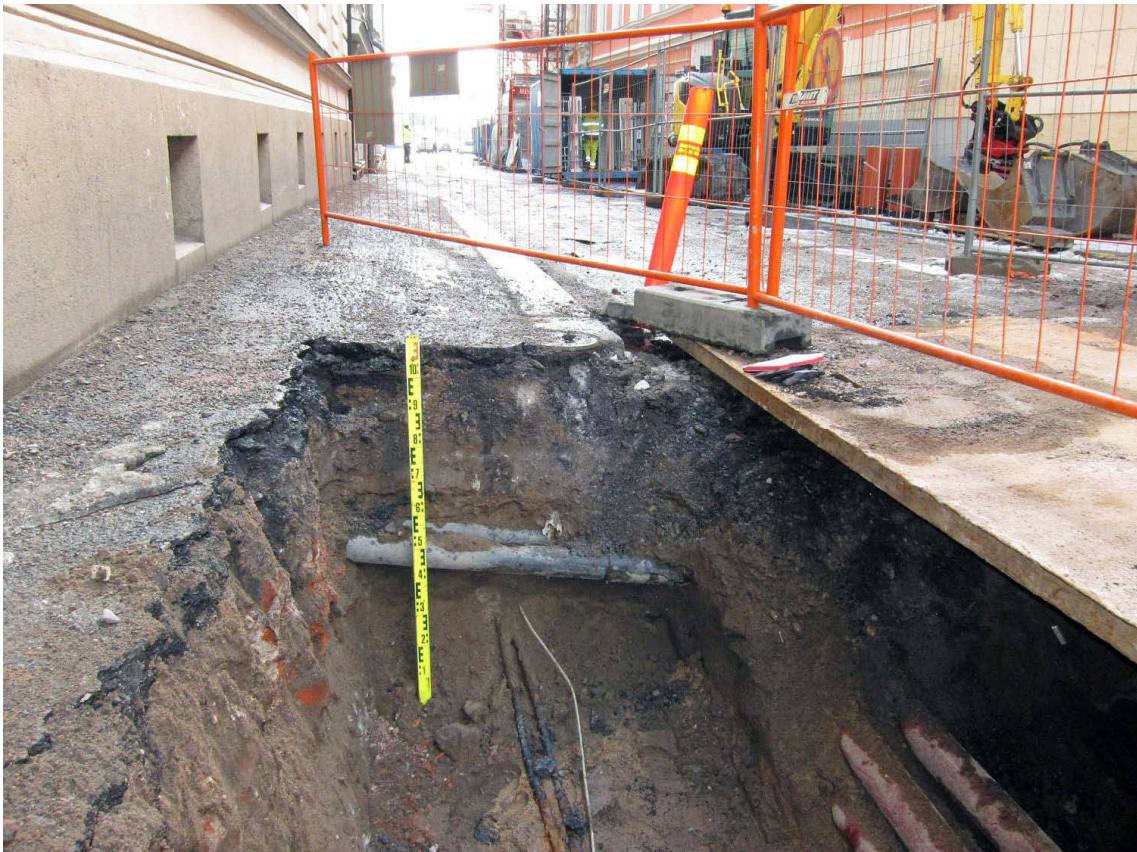
Kuva 272. Helen ankatu. Kaivannon eteläpää Lampan talon pohjoisosan linjalla. Kaivanto kääntyi kadun poikki kohti Lampaa. Kuvaussuunta S. 8.4.2013.
