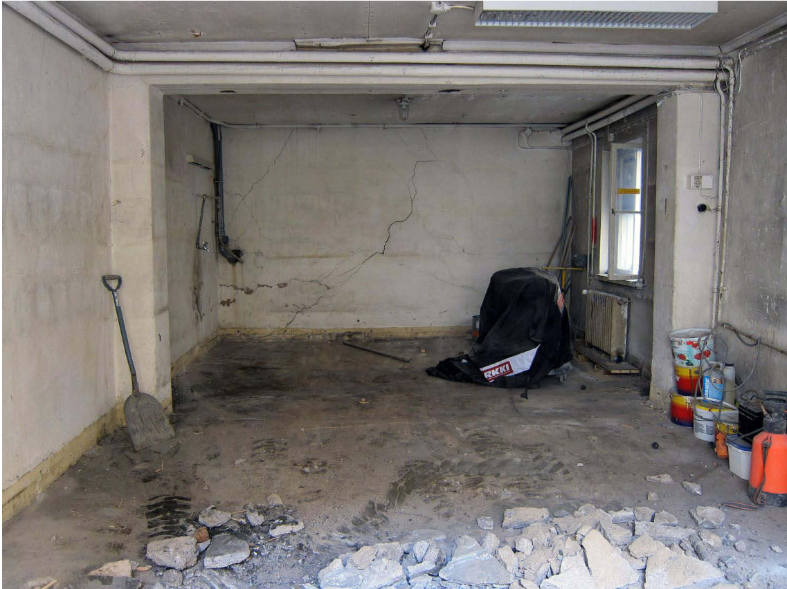
Kuva 223. Piharakennus, huone A. Piharakennuksen huonetila A rakennuksen perustusten vahvistamisen aloittamisen aikaan. Kuvaussuunta N. 23.7.2012.
