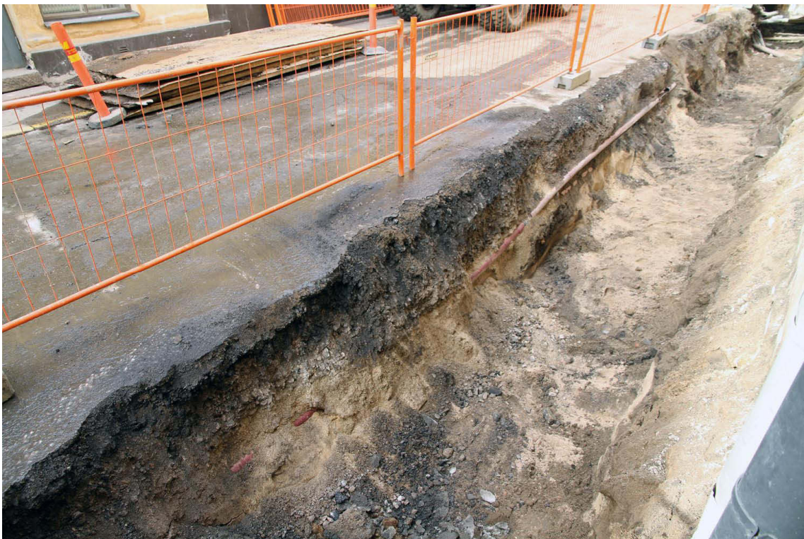
Kuva 271. Helen ankatu. Lähikuva kaivannon länsiprofiilista edellisen kuvan kaivantovaiheen eteläpäästä. Kuvaussuunta NW. 5.4.2013.
