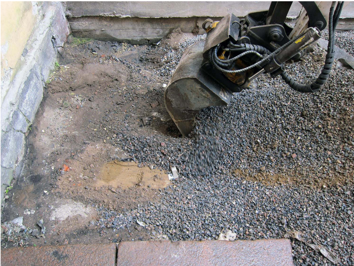
Kuva 170. Piha, lounaisosa. Kaivaminen on aloitettu. Kuvaussuunta W. 23.7.2012.
