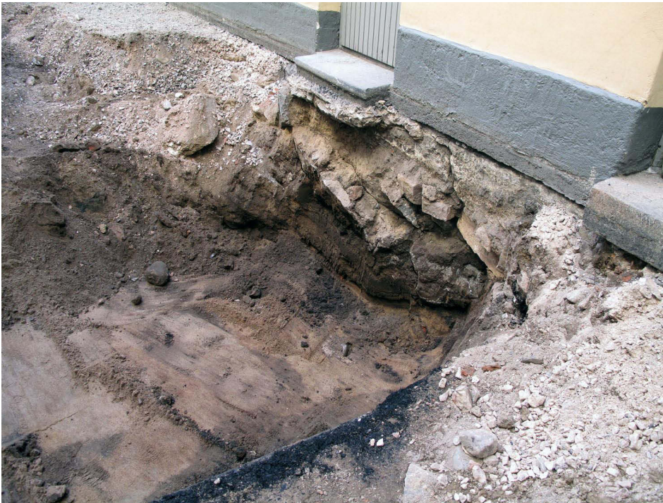
Kuva 114. Piha, pohjoisosa. Havaintopiste 2 sijaitsi vasemman askelkiven kohdalla. Kuvaushetkellä maata on jo poistettu. Kaivannon pohjalla näkyy luonnollinen kellertävä puhdas hiekka, jonka keskellä on vaaleampi poikittainen vyöhyke. Siitä paljastui putkilinja. Kuvaussuunta SW. 15.9.2009.
