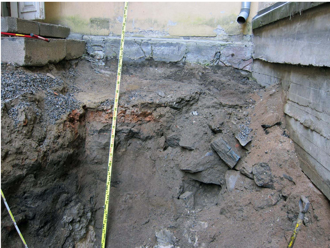
Kuva 210. Piha, Iouaisosa. Havaintopisteen 8 eteläisen maaleikkauksen yläosa loppuvaiheessa. Kuvaussuunta S. 24.7.2012.
