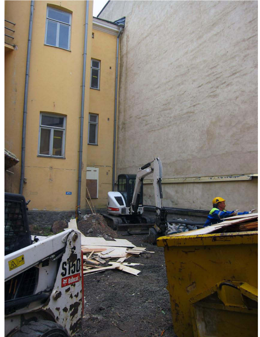
Kuva 168. Piha, lounaisosa. Hissien perustusköppä, havaintopiste 8, kaivettiin kaivinköppänen kohdalle puolikaarenmuotoisen portaan itäpuolelle. Kuvaussuunta SW. 23.7.2012.
