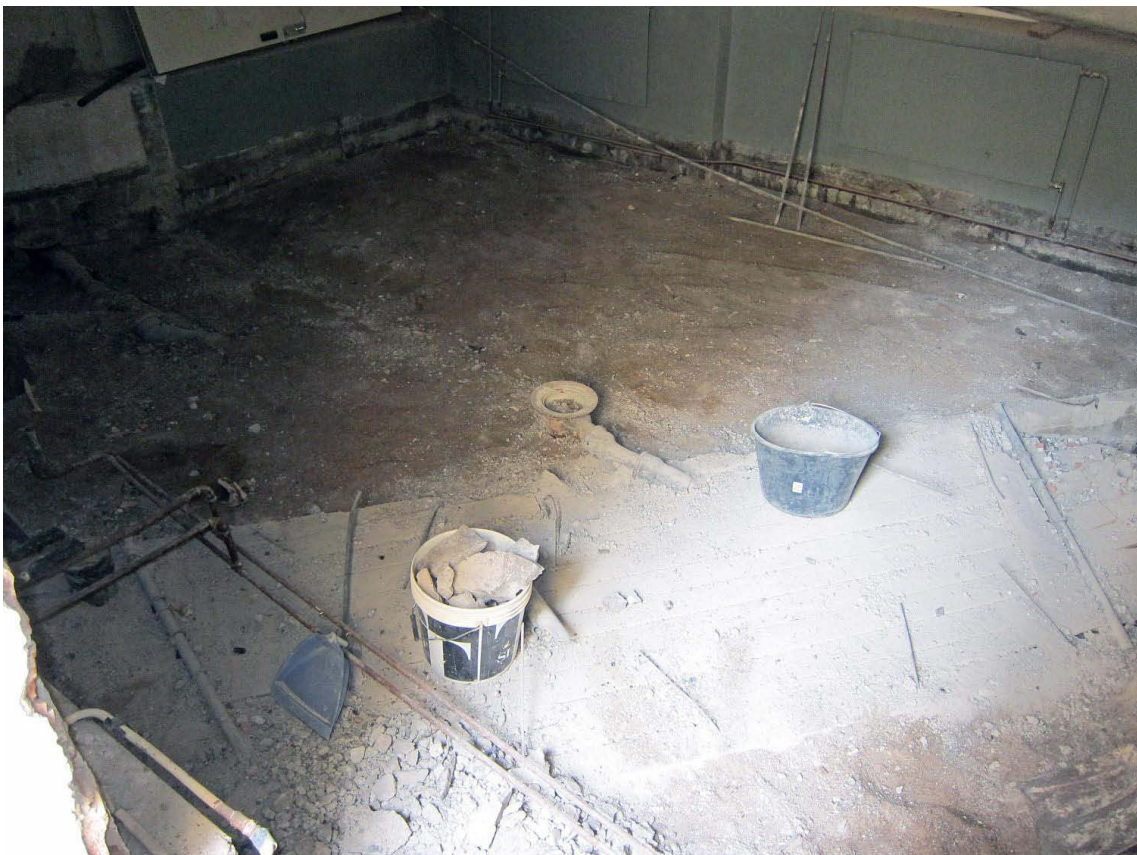
Kuva 254 P iharakennus, hu one D . Lattia ja sen alapuoliset kerrokset on poistettu tavoitetasoon. Kuvaussuunta NW. 30.7.2012.
