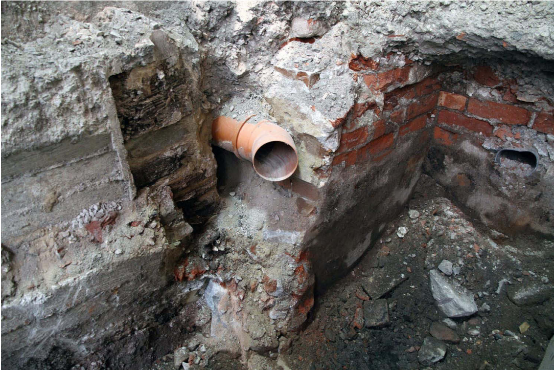
Kuva 260. Porttikonki. Lähikuva kaivon eteläseinästä, megapaalun yläosasta ja muovisesta putkesta. Kuvaussuunta SW. 5.4.2013.
