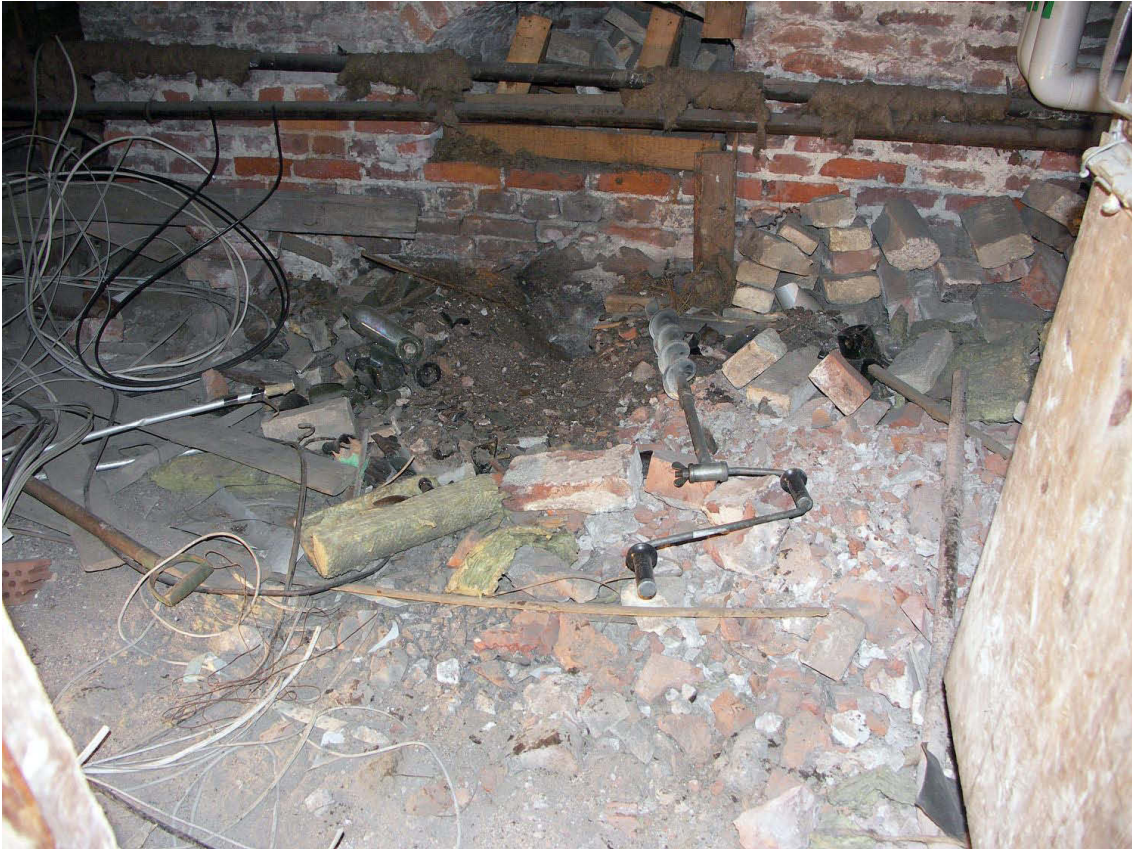
Kuva 72. Kellari VI. Pohjisseinän tiili- ja roskakasaa. Kuvaussuunta N. 5.3.2009.
