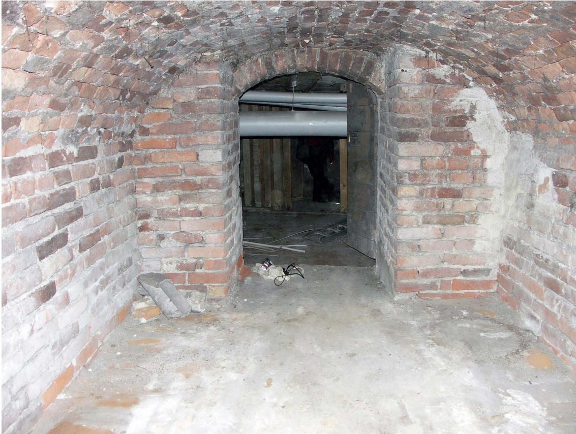
Kuva 27. Kellari III. Edellinen tilanne. Oviaukon takana on kellari II. Kuvaussuunta W. 25.2.2009.
