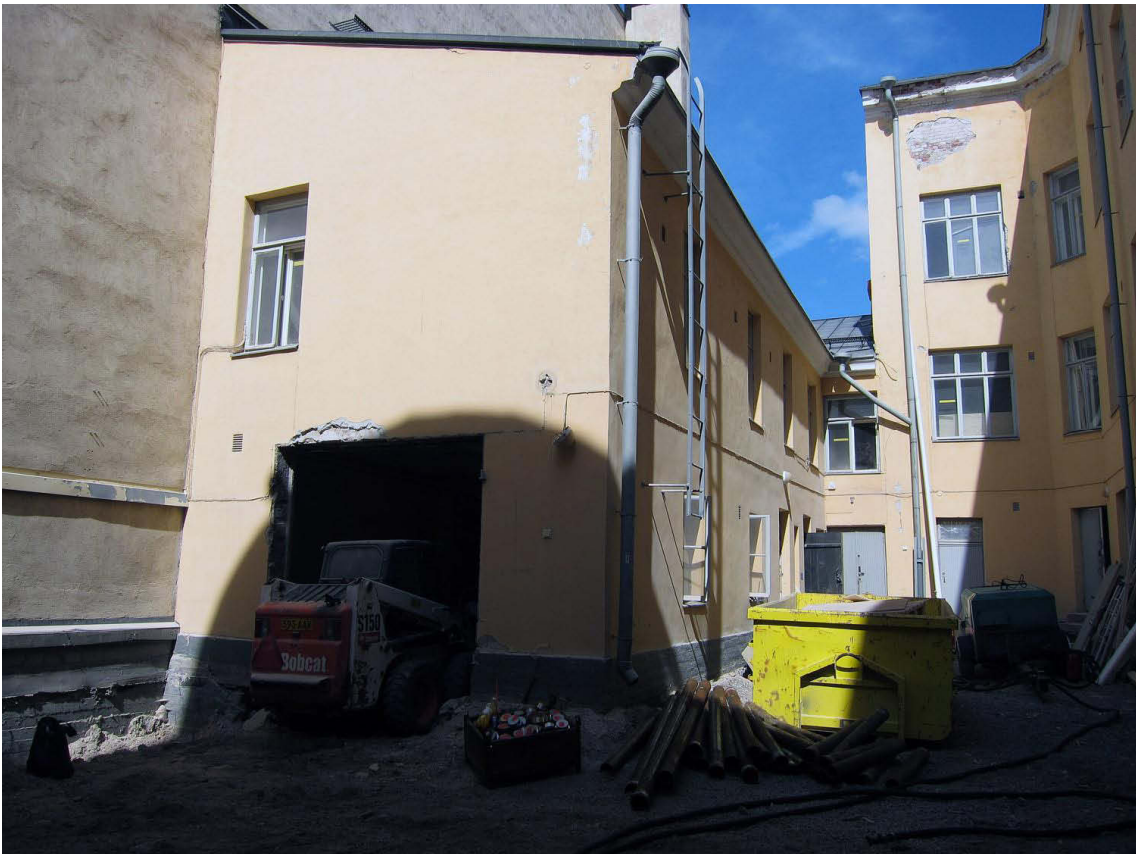
Kuva 222. Piharakennus. Kuvaussuunta NW. 15.8.2012.
