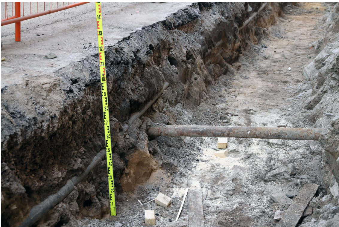
Kuva 269. Helenankatu. Lähikuva kaivannon länsiprofiilista edellisestä kohtaa. 5.4.2013.
