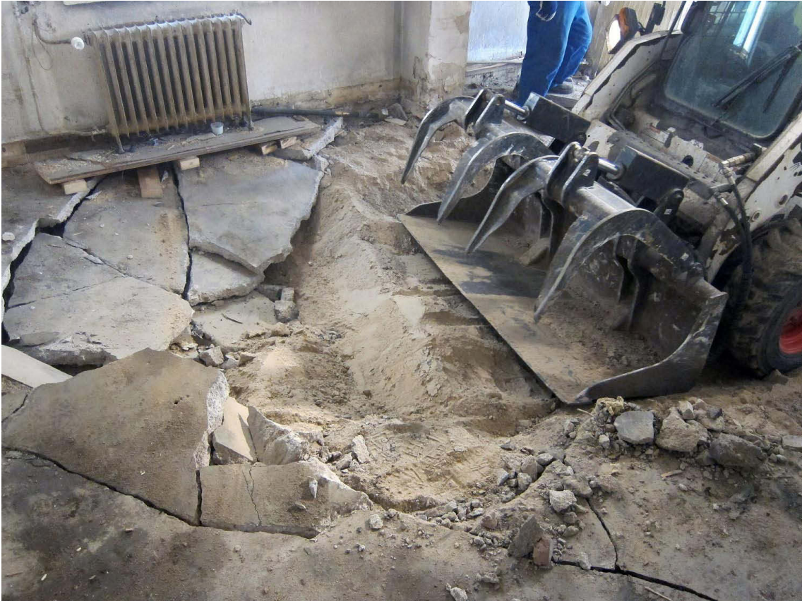
Kuva 227. Piharakennus, huone A. Bobcat ja betonilattia. Kuvaussuunta SEE. 24.7.2012.
