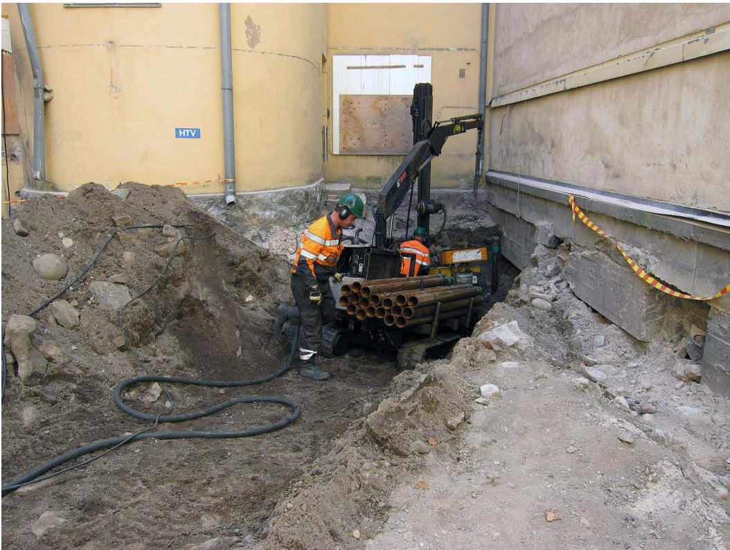
Kuva 214. Piha, lounaisosa. Havaintopiste 8. Hissin kohtaa paalutetaan. Kuvaussuunta S. 15.8.2012.
