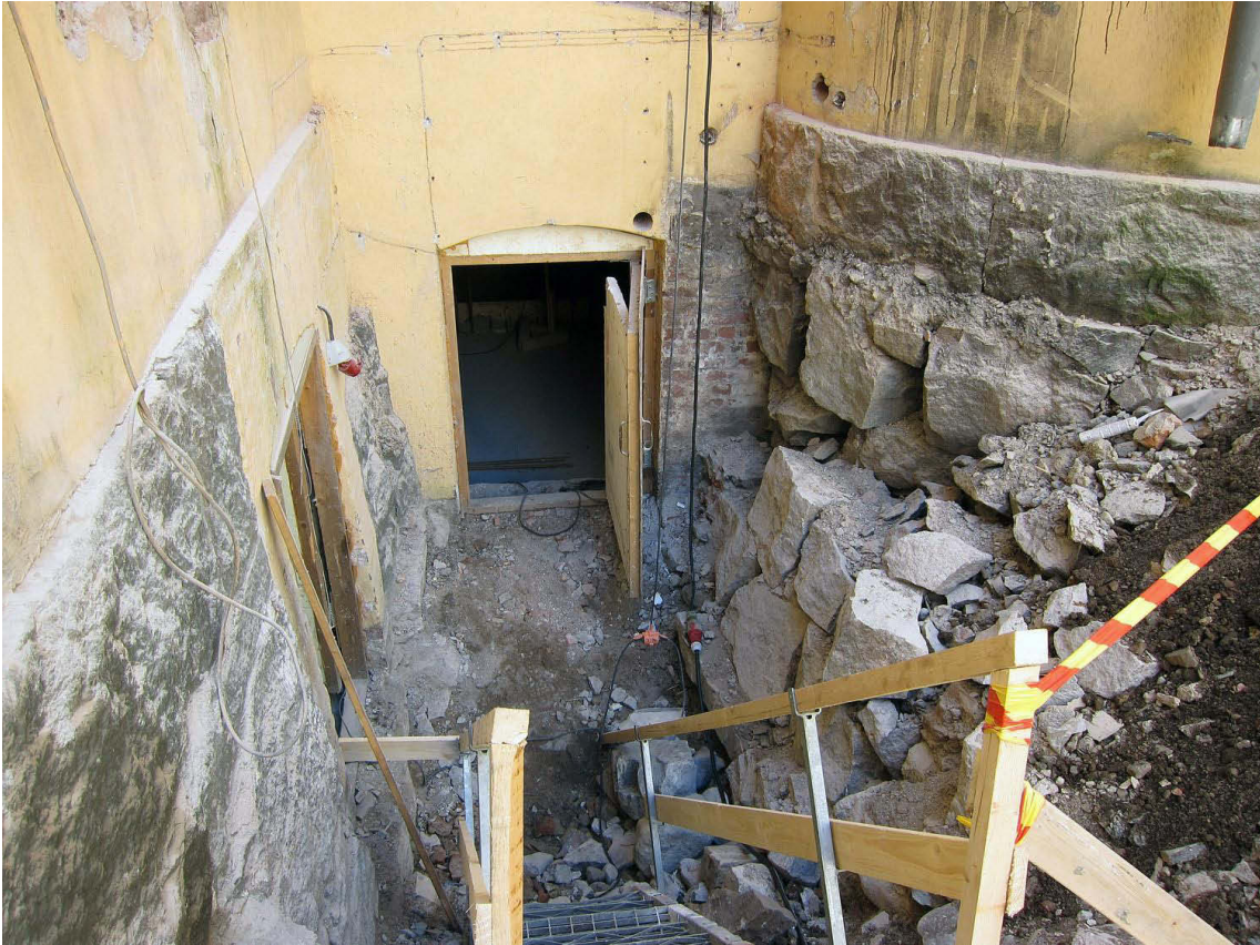
Kuva 221. Piha, kaakkoisosa. Työmaaportaati on tehty kellareihin. Kuvaussuunta S. 15.8.2012.
