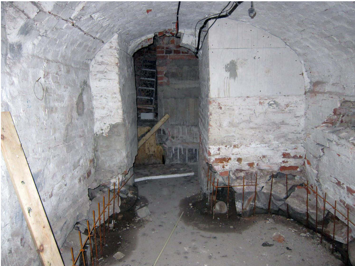
Kuva 49. Kellari IV. Tilan lattia on valettu ja reunoilla on raudoituksia. Kuvaussuunta N. 13.1.2009.
