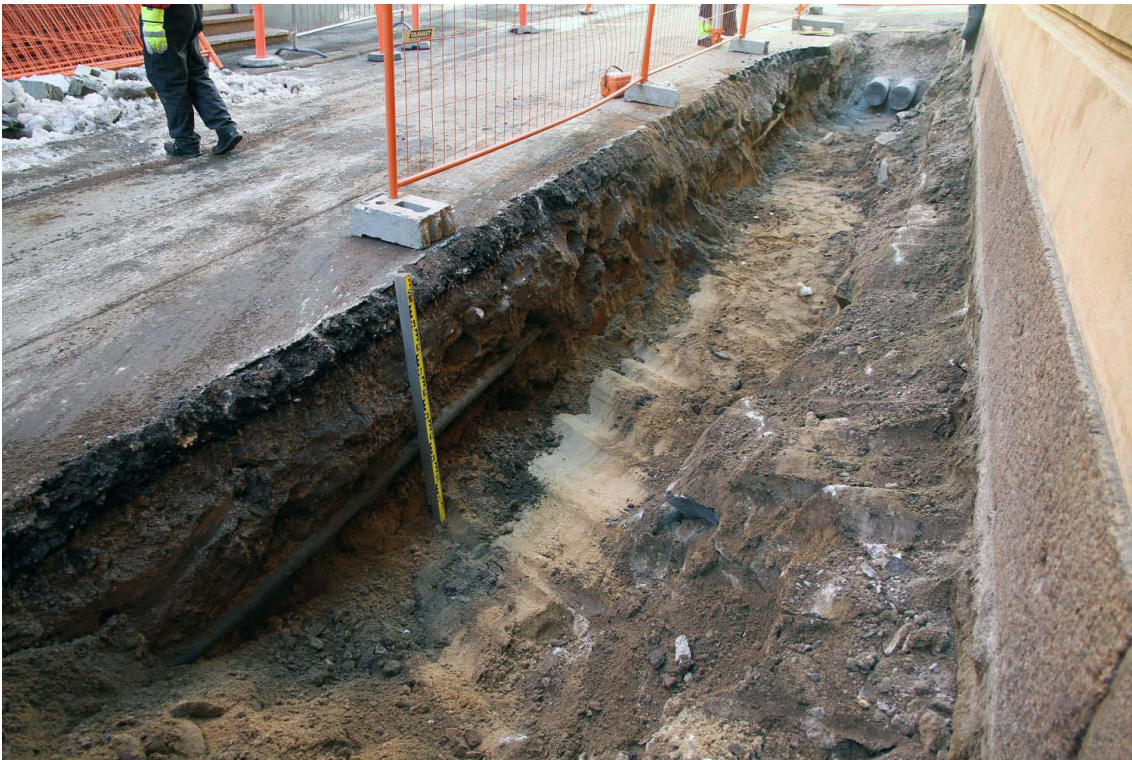
Kuva 265. Helen ankatu. Edellinen tilanne. Kaivannon pohjalla on puhdas hiekka ja länsiprofiilissa putket lähes kaivannon pohjatasolla. Kuvaussuunta NNW. 3.4.2013.
