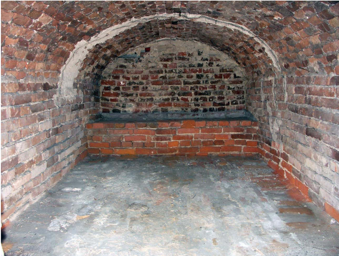
Lampan parhaiten säilynyt kellaritila III ennen rakennustöitä.
