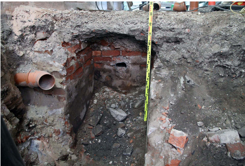
Kuva 259. Porttikonki. Lähikuva tiilirakenteesta. Kuvaussuunta SWW. 5.4.2013.
