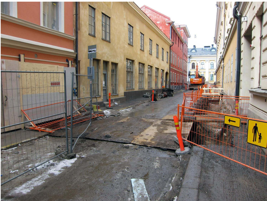
Kuva 273. Helen ankatu. Kaivanto on kaivettu Helenankadun poikki. Kuvaussuunta NNW. 8.4.2013.
