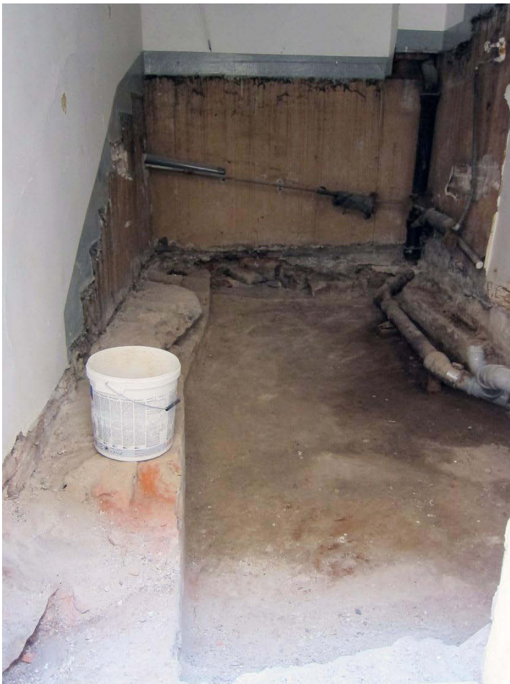
Kuva 246. Piharakennus, huone B. Lattia ja sen alapuoliset maat on poistettu kovaan pohjaan saakka. Kuvaussuunta W. 30.7.2012.
