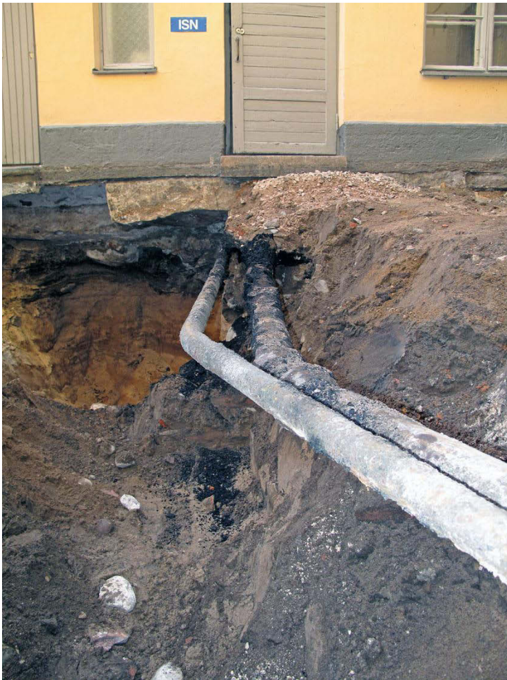
Kuva 125. Piha, pohjoisosa. Kaivanto ja putket kuvattuna piharakennusta kohden. Kuvaussuunta W. 17.9.2009.
