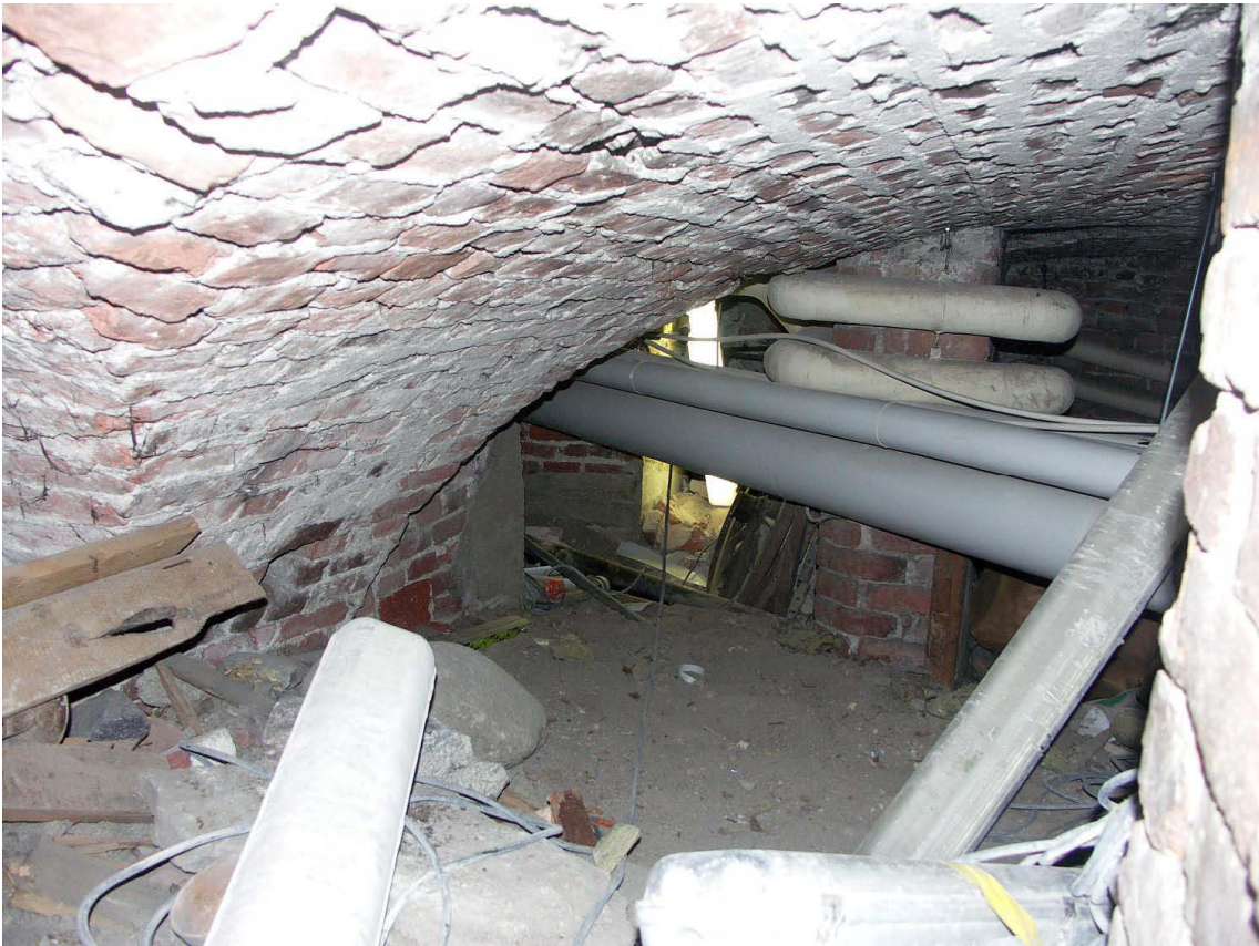
Kuva 91. Kellari VIII. Tilan luoteispuolisko. Kuvaussuunta NNW. 1.7.2009.
