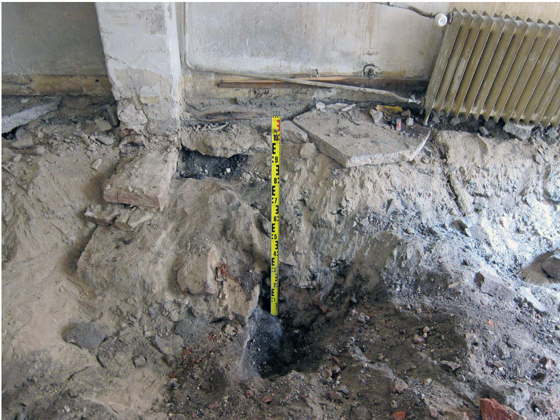
Kuva 234. Piharakennus, huone A. Havaintopisteessä 9 on kaivettu tummaa maata syvemmälle pienellä koealueella. Kuvaussuunta E. 24.7.2012.
