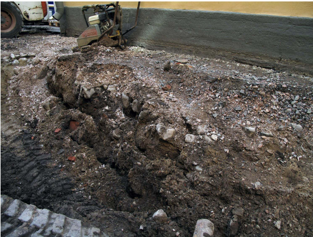
Kuva 134. Piha, pohjoisosa. Pihan keskiosassa kapeammalla pihaosuudella piharakennuksen eteläpään kohdalta dokumentoitiin maaleikkaus havaintopisteessä 3. Maaleikkauksen edessä itäpuolella, kuvan etualalla, maa oli sekoittunutta ilmeisesti kohdalla olevan putkilinjan takia. Kuvaussuunta SW. 8.10.2009.
