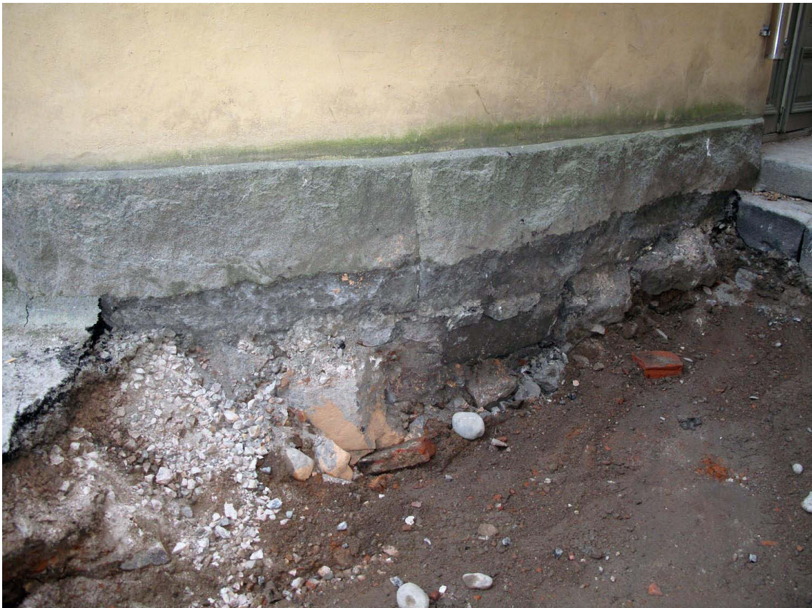
Kuva 159. Piha, eteläosa. Lähikuva puolikaarenmuotoisen portaikon länsiseinän perustuksesta. Vasemmalla on vielä asvaltti paikoillaan. Kaivetulla osuudella pihan pinta näkyy kivijalassa tummempana. Kuvaussuunta SE. 15.10.2009.
