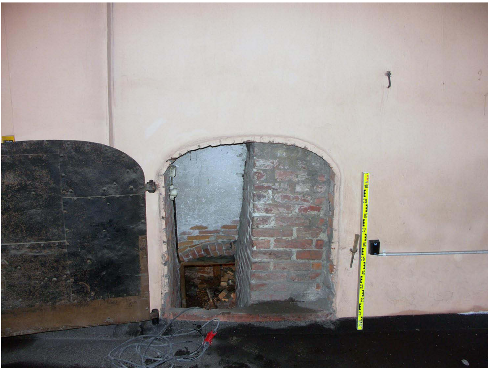
Kuva 63. Kellari VI. Porttikongin pohjoisseinässä oleva portaikon oviaukko. Kuvaussuunta N. 5.3.2009.
