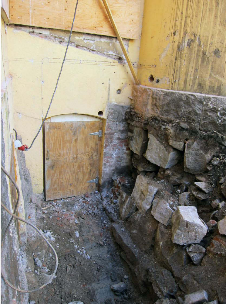
Kuva 219. Piha, kaakkoisosa. Puolikaarenmuotoisen portaikon perustukset ovat oikealla. Kuvaussuunta SSW. 27.7.2012.
