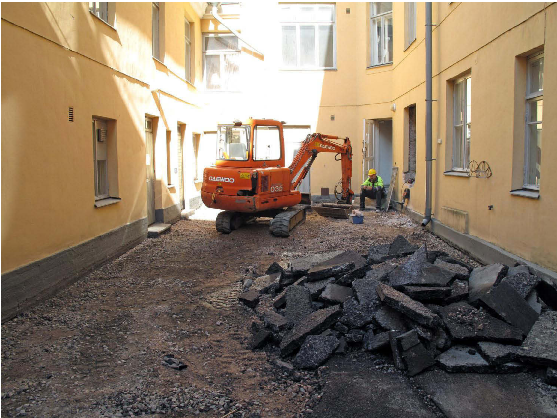
Kuva 105. Piha, pohjoisosa. Asfalttikerros on poistettu pihan kapeasta pohjoisosasta. Hätäpoistumiskäytävä kaivettiin vasemmalla näkyvän piharakennuksen ja oikealla olevan Helenankadun siiven välille kaivinkoneen kohdalle. Kuvaussuunta N. 14.9.2009.
