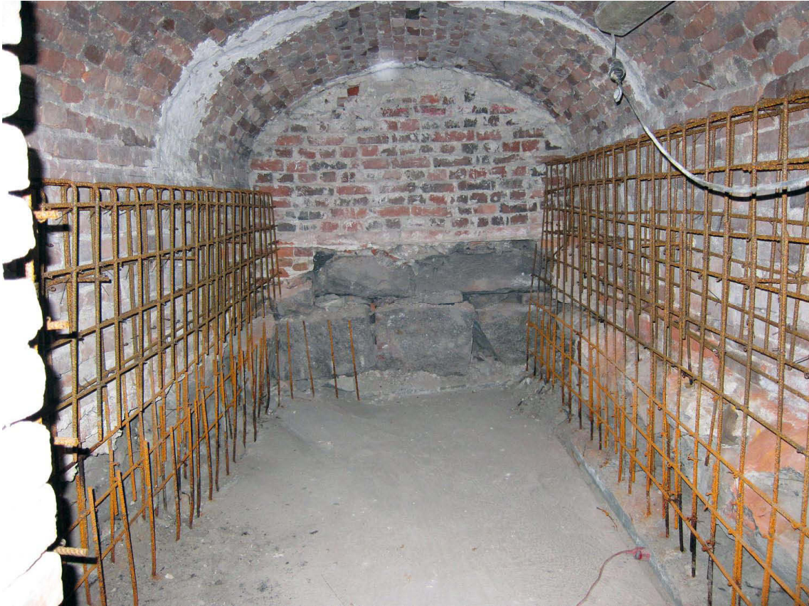
Kuva 41. Kellari III. Kellarin lattia on valettu ja seiniä varten on betoniraudat. Kuvaussuunta E. 13.1.2012.
