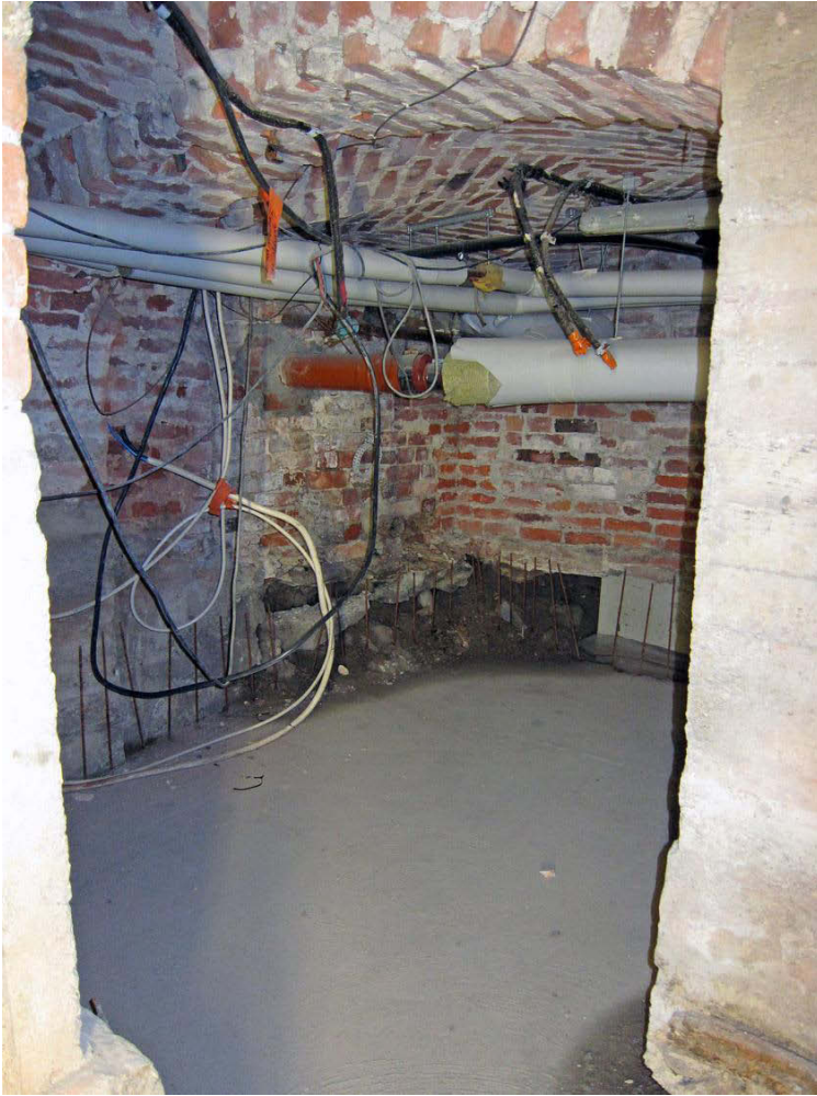
Kuva 62. Kellari V. Päätilan lattia on valettu. Kuvaussuunta NE. 15.8.2009.
