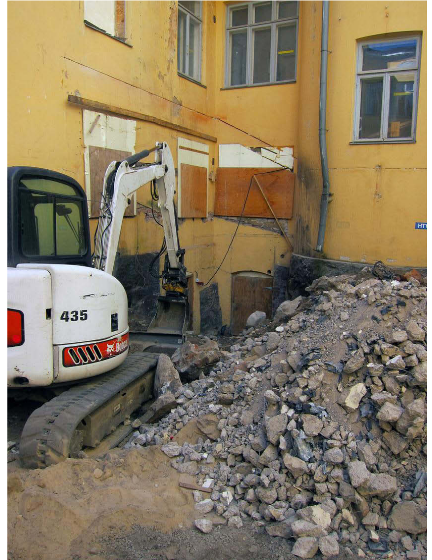
Kuva 216. Piha, kaakkoisosa. Pihan kaakkoisnurkan kellareihin johtavaa portaikkoa puretaan. Kuvaussuunta SE. 27.7.2012.
