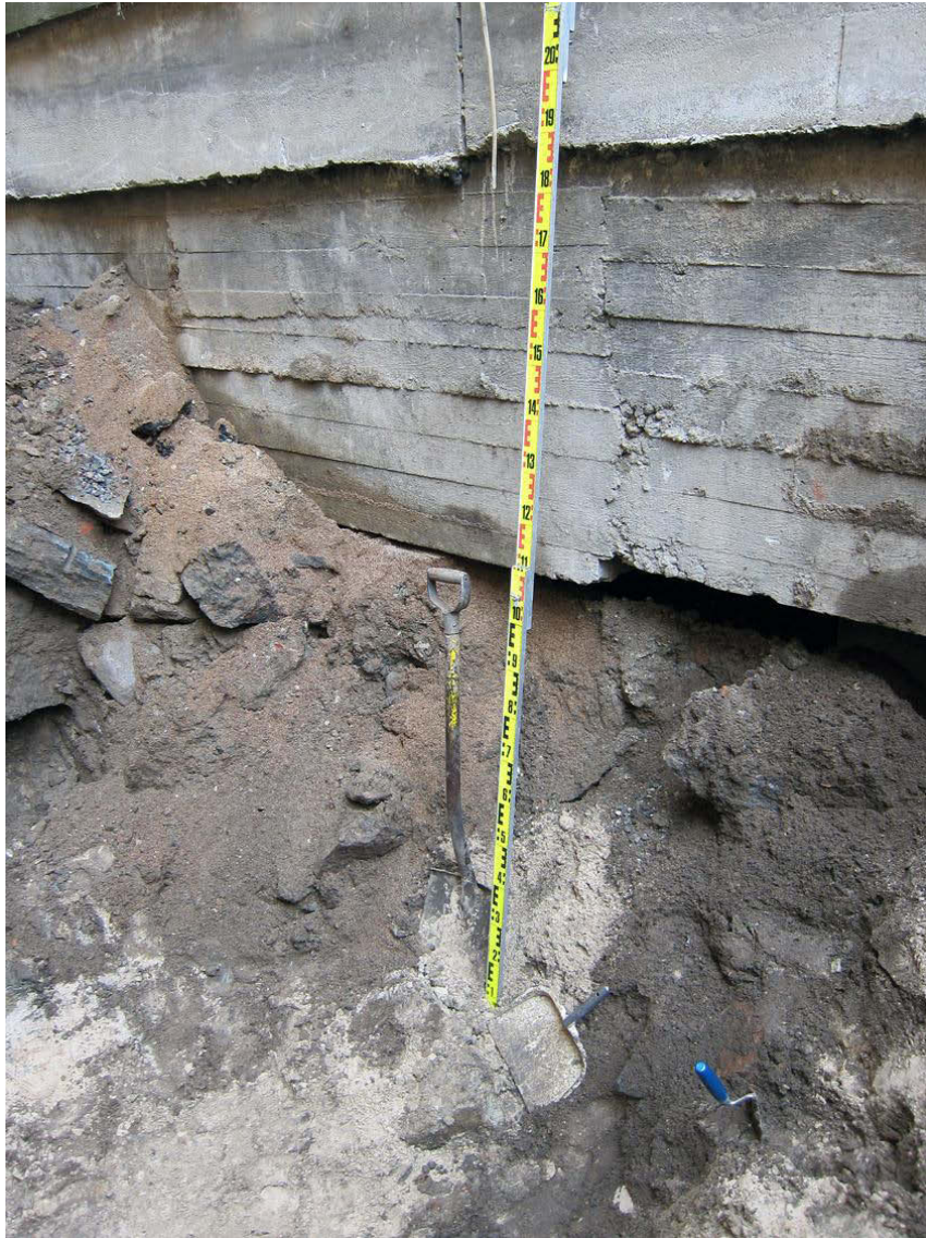
Kuva 211. Piha, lounaisosa. Havaintopiste 8. Lähetystön seinäperustus loppuvaiheessa. Kuvaussuunta SW. 24.7.2012.
