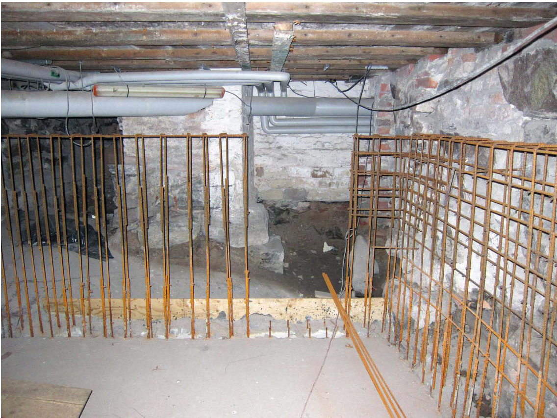
Kuva 24. Kellari II. Kellarin pohjoisosan lattia on valettu ja seiniä varten on rudoitukset valmiina. Kuvaussuunta S. 13.1.2012.
