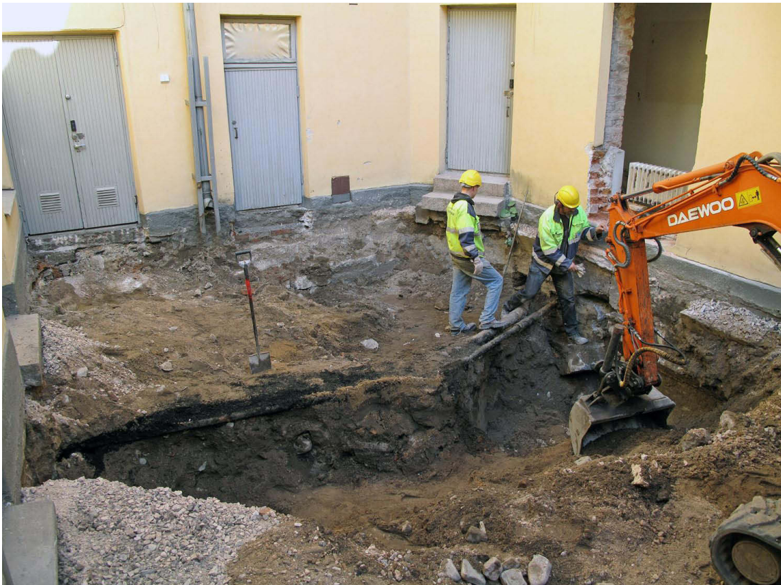
Kuva 111. Piha, pohjoisosa. Havaintopiste 1 sijaitsi vasemmanpuoleisen miehen edessä. Kuvaussuunta NE. 15.9.2009.
