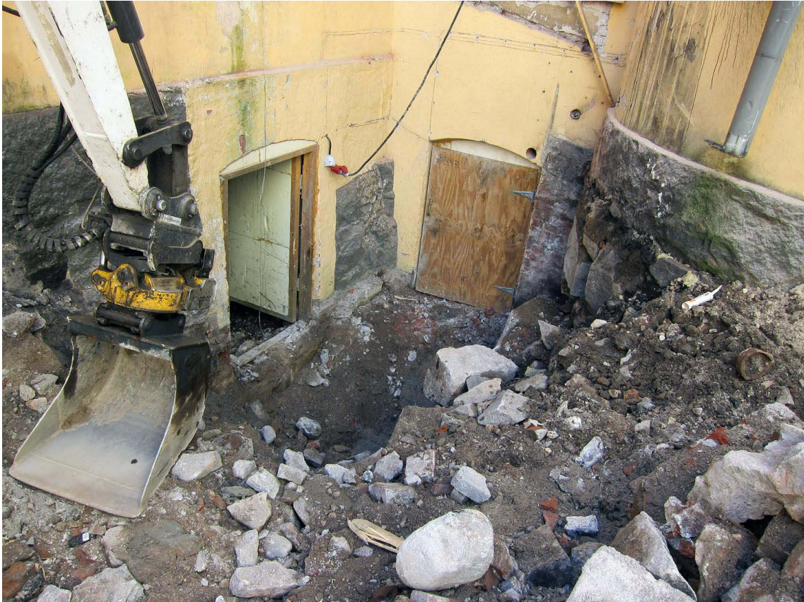
Kuva 217. Piha, kaakkoisosa. Edellinen tilanne. Vasemmanpuoleinen ovi johtaa kellareihin IV-V ja oikeanpuoleinen kellareihin I-III. Kuvaussuunta SE. 27.7.2012.
