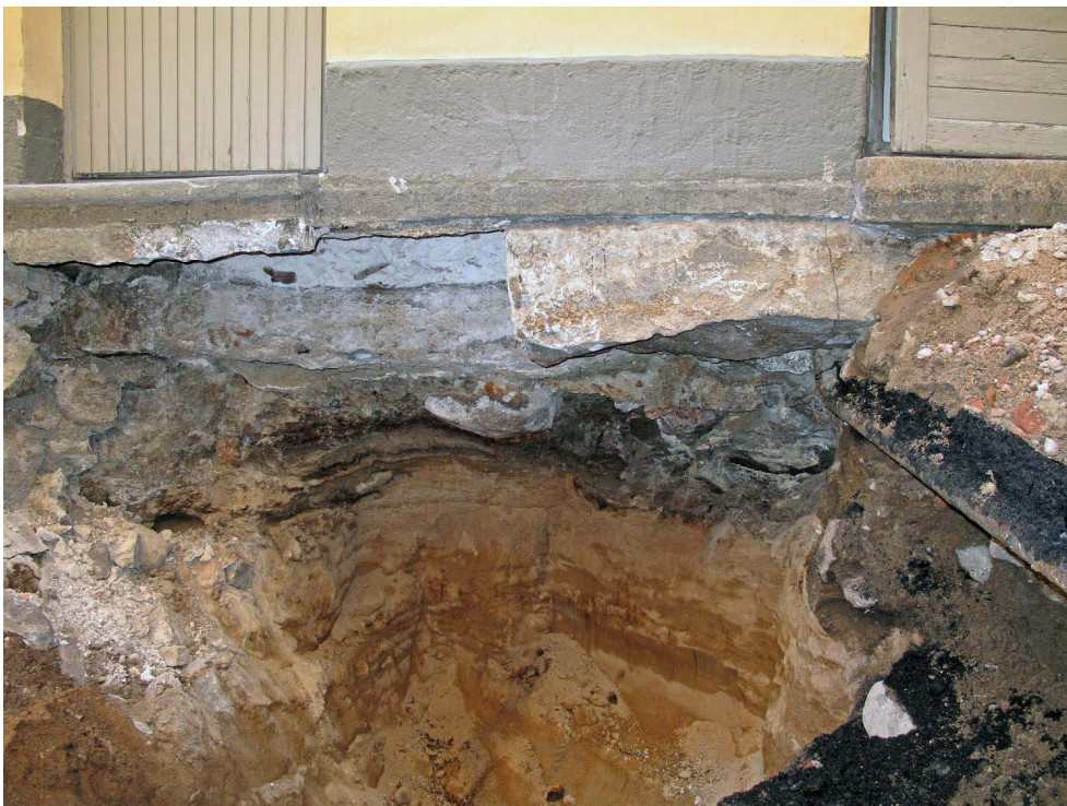
Kuva 126. Piha, pohjoisosa. Kaivannon länsipää piharakennuksen itäseinän perustuksen alla. Luonnollinen hiekka tulee melko korkealle. Kuvaussuunta W. 17.9.2009.
