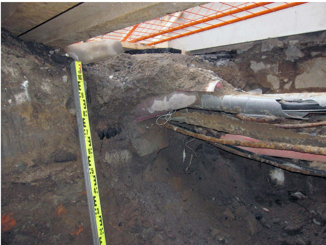
Kuva 274. Helen ankatu. Kaivanto Lampan talon kohdalla. Jalkakäytävän kohdalla oli runsaasti kaapeleita ym. Kuvaussuunta SW. 8.4.2013.
