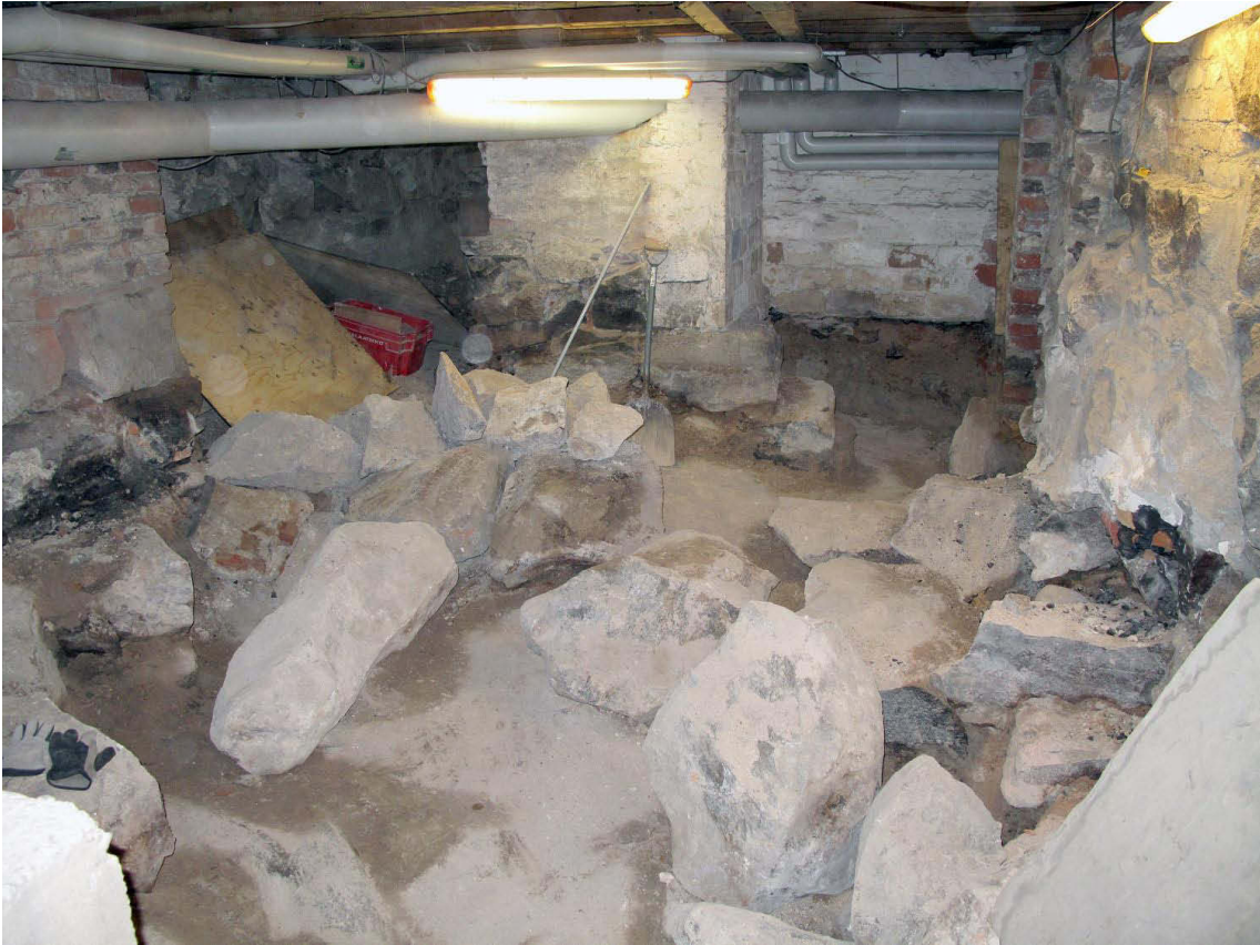
Kuva 19. Kellari II. Kellari betonilattian ja niiden alapuolisten maakerrosten poiston jälkeen. Tilassa on esillä kallio ja irtokiviä. Kuvaussuunta S. 21.9.2009.
