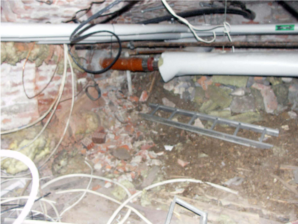
Kuva 53. Kellari V. Lähikuva edellisestä tilasta. Kuvaussuunta NE. 25.2.2009.
