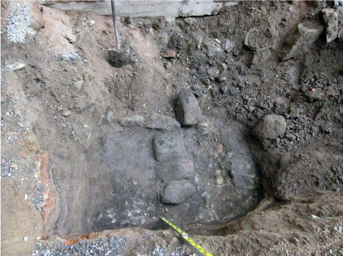
Kuva 181. Piha, lounaisosa. Havaintopisteen 8 itäisin aluskivi profiilin vierestä on poistettu. Poikittaiset kivet lapion alapuolella ovat lähetystön seinäperustuskaivannon irtokiviä. Kuvaussuunta W. 23.7.2012.
