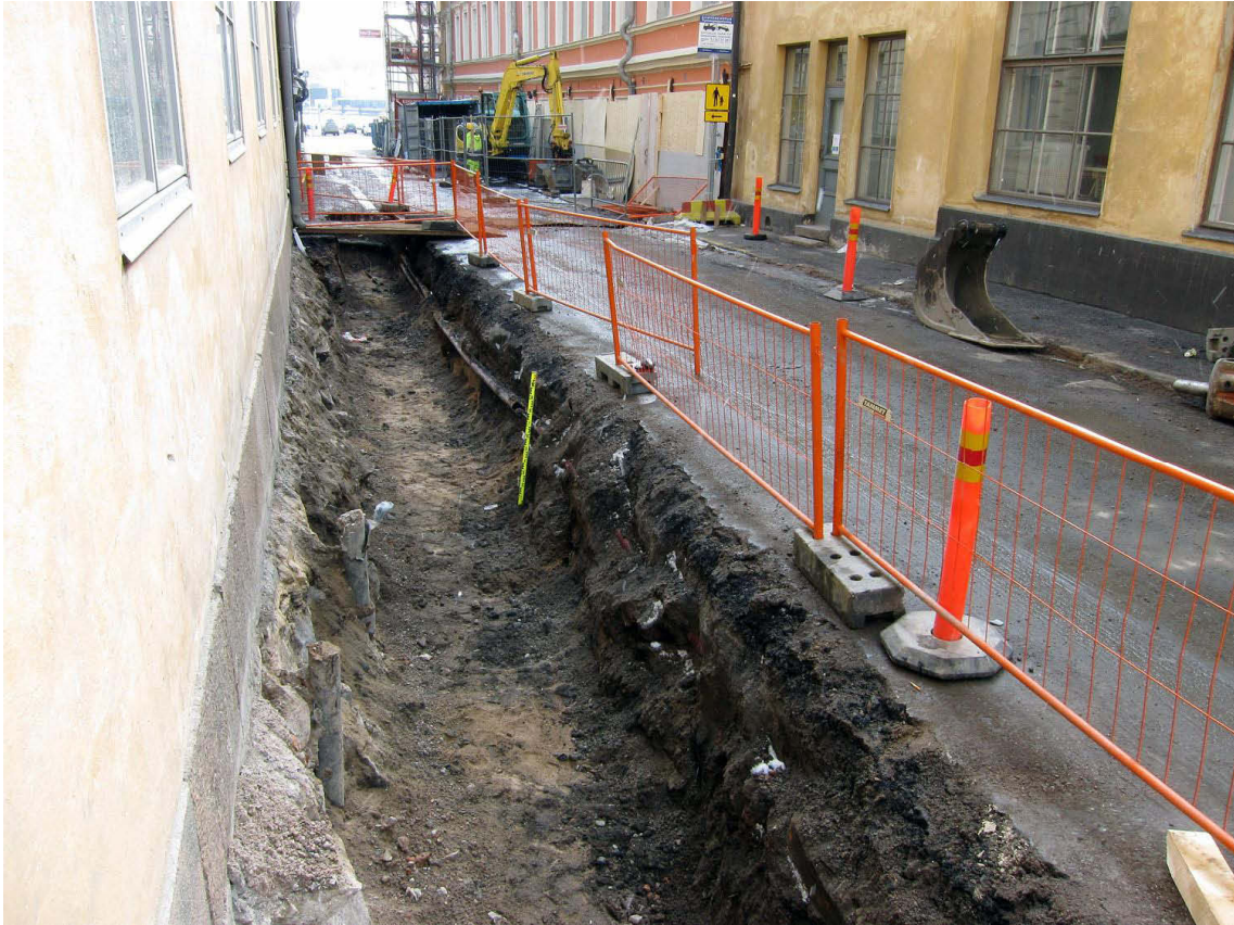
Kuva 270. Helen ankatu. Kaivanto kadun keskiosassa oikealla sijaitsevan Helenankatu 7 kohdalla ennen punaisen väristä Lampaa. Kuvaussuunta SSW. 8.4.2013.
