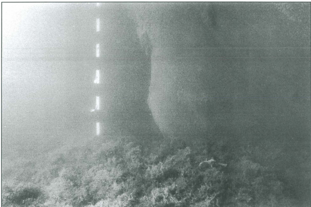
200016:74 Keularangan alaosa, jossa näkyvissä krii eli uloke (engl. gripe, ruots. kriet). Pohjassa kuollutta kasvustoa. Mittakaavapalkki 10 cm jaotuksella. Kuva Petteri Airanne, SMM.
