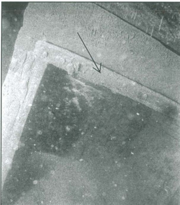
200016:75 Kuva piipun hormin kansitason saumoista. Kuva Petteri Airanne, SMM.
