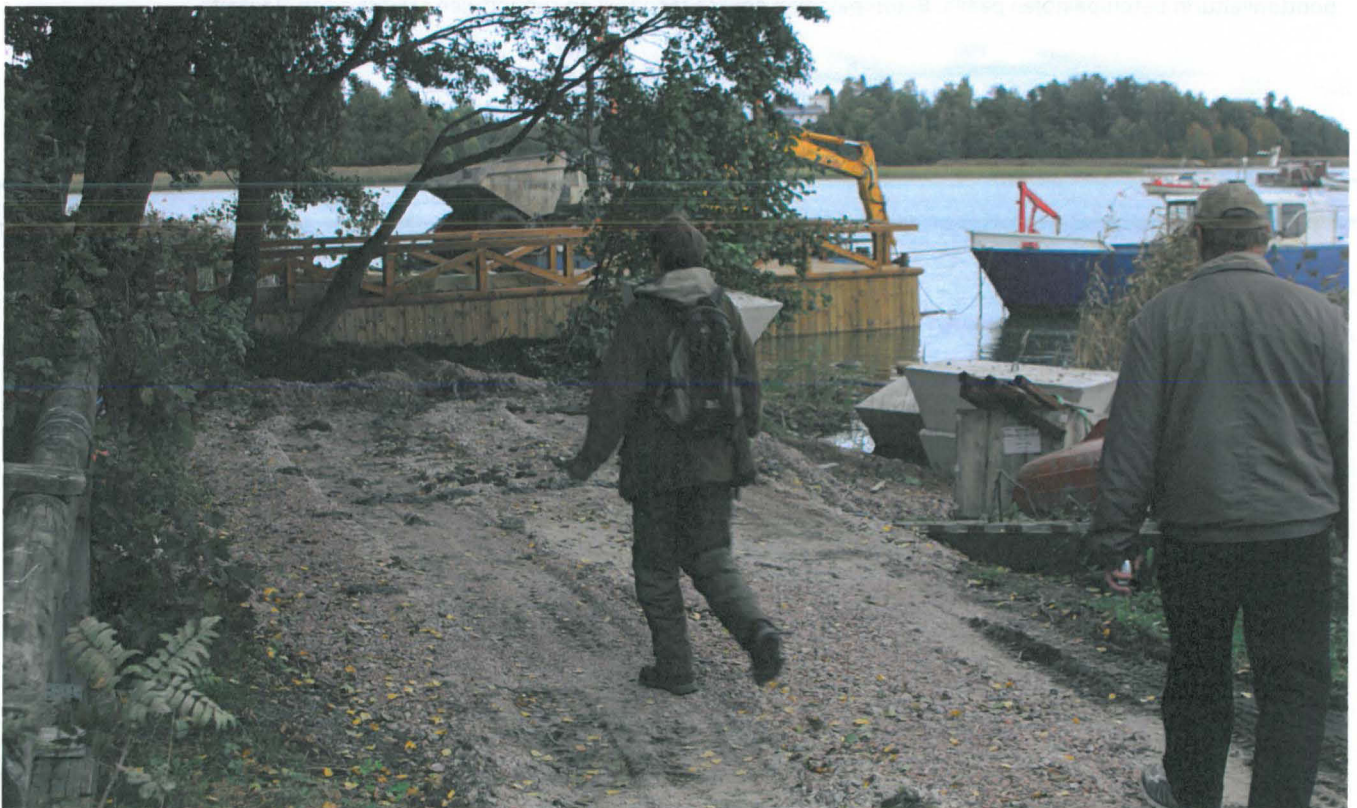
Kuvassa uusi laiturit, johon kaksi ponttonilaituria ja lisäosa kiinnitetään. Urakoitsija on myös joutunut tekemään työkoneille ensin tien, jotta he ovat päässeet laiturinrakennuskohteelle. Kuvassa edellä Laajalahden merenkävijät ry:n Keijo Nikander ja Heikki Aura.
