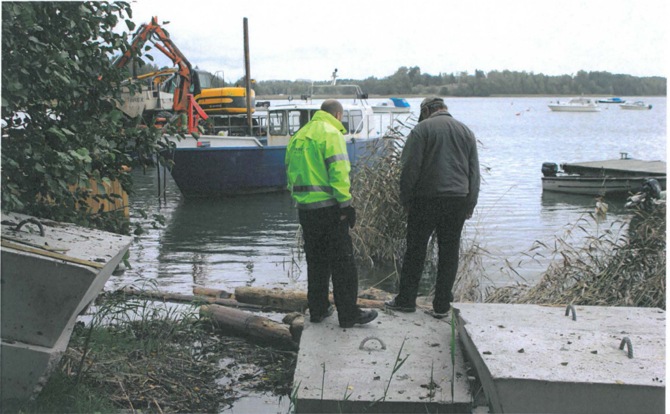
Kuvassa vasemmalla uuden ponttonilaiturin työmaa, jolla ruoppaus käynnissä. Olemassa oleva vierasvenelaituri jää kuvan oikealle puolelle. Aki Leinonen vasemmalla ja Laajalahden merenkävijät ry:n telakkamestari Heikki Aura oikealla seisovat tulevan ponttonilaiturin betonipainojen päällä. Betonipainojen edessä rannassa on ruopattujen salvoshirsien jäänteitä.
