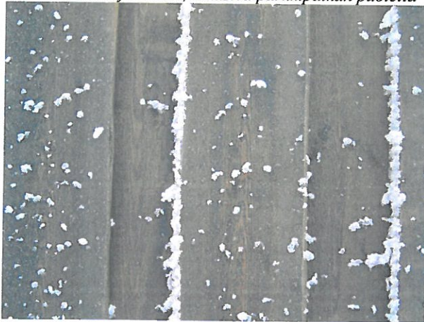
Kuva 26. Esiintymislavan julkisivun laudoitus
