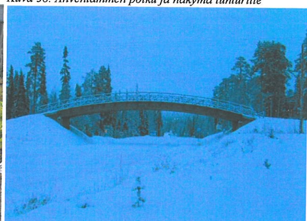
Kuva 40. latusilta muodostaa portin
