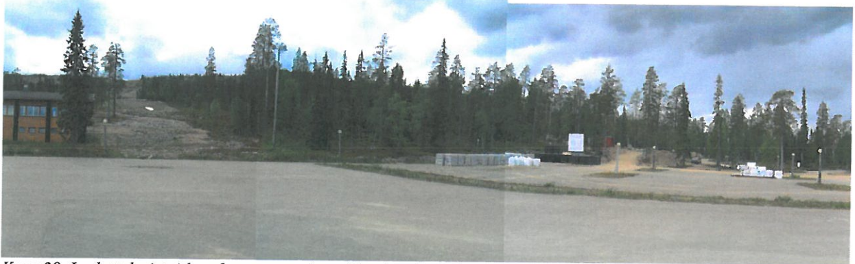
Kuva 28. Laskettelurinteiden ala-asema, rakenteilla oleva kortteli 53, Luosto Cabins
