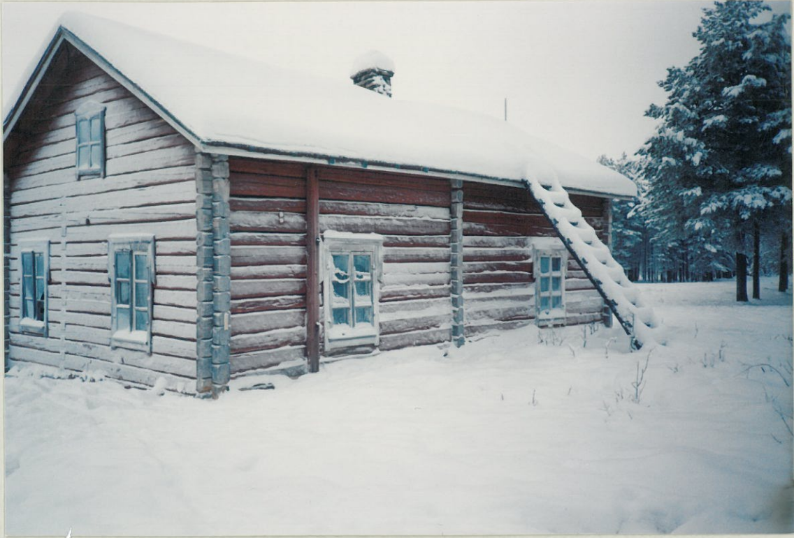
Päärakennus -pohjoissivu/itäpääty -itäpääty
