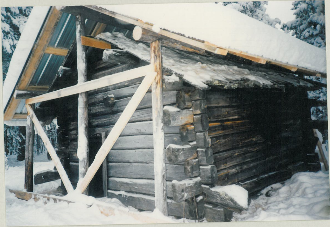
Savusauna - pohjoispääty/länsisivu -länsivu/eteläpääty
