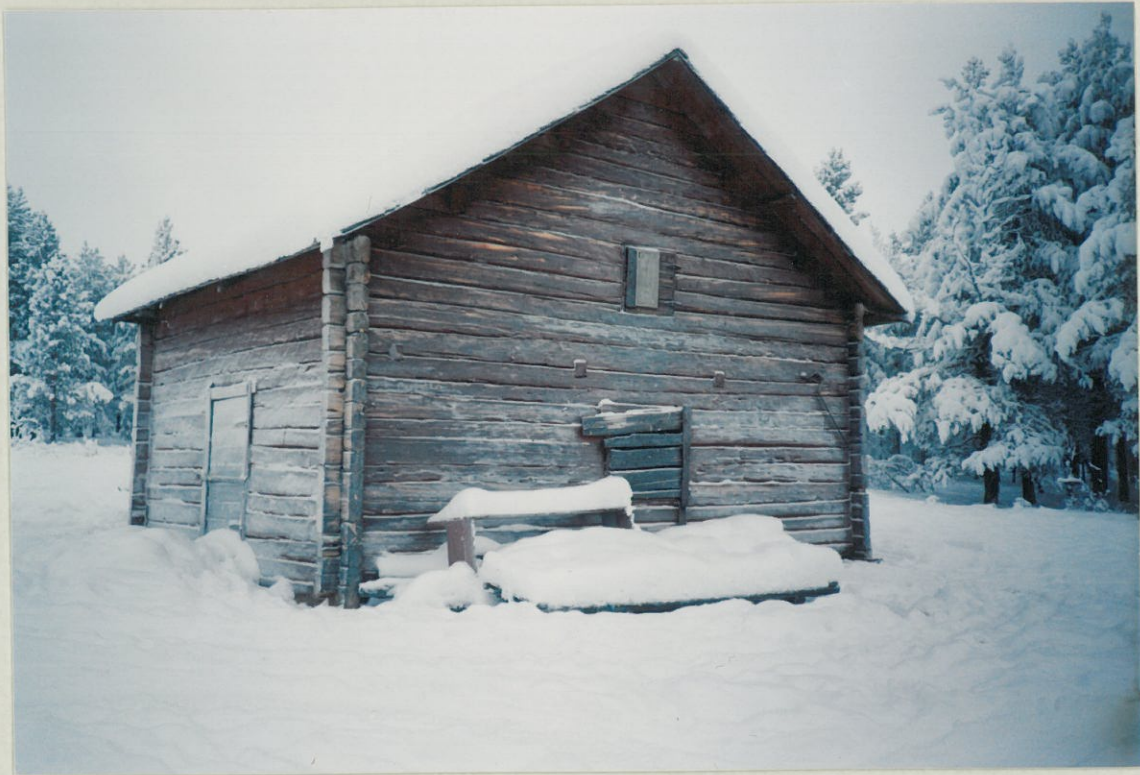
Uusi makasiini _pohjoispääty/länsisivu -eteläpääty/länsisivu -itäsisivulla ei aukkoja
