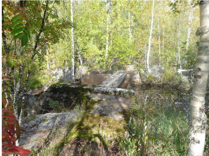
Kuva 35. Pato kuvattuna lounaasta.
