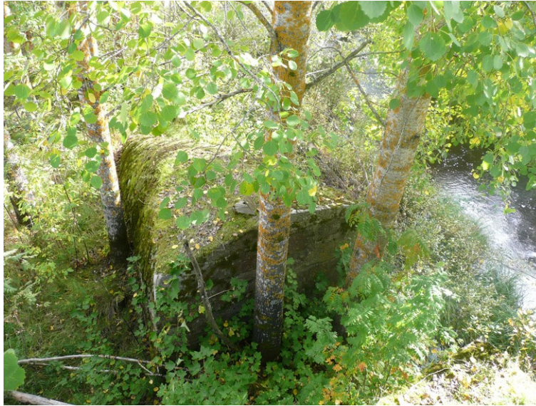
Kuva 34. Sillan kivijalka I. jäänsärkijä kuvattuna luoteesta.
