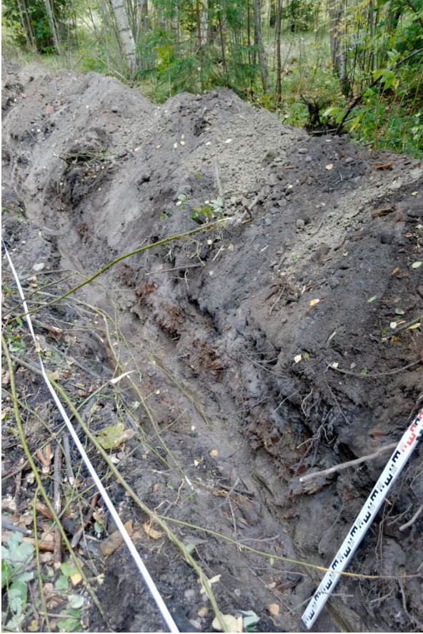
Kuva 3. Kaivanto 2:n ensimmäisen osan luoteispään rakennusjätettä, jonka seassa oli styroksia. Kuvattu pohjoisesta. AKDG3322_022
