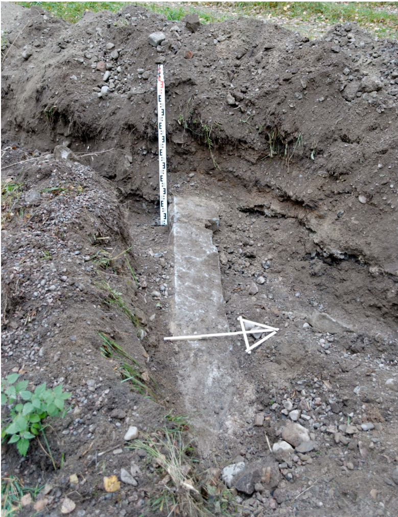
Kuva 6. Rakennuksen perustuskivi kaivannossa 4. Kivi oli navetan lounaispäädyssä 20,65 m etäisyydellä. Nuoli osoittaa koilliseen. AKDG3322_039
