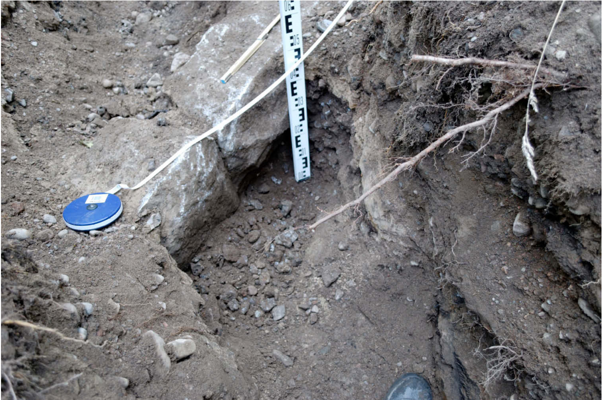
Kuva 5. Rakennuksen perustuskaivantoa. Kuvattu lännestä. AKDG3322_041
