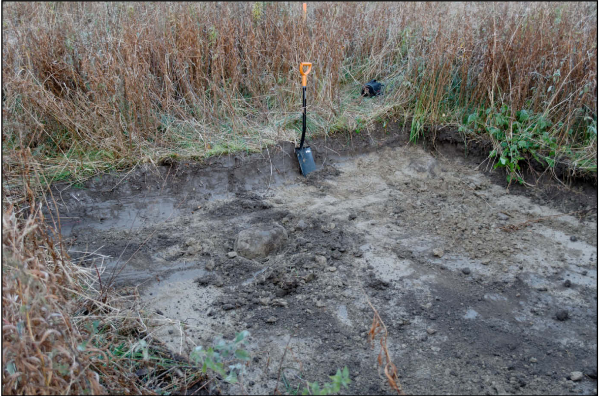
Kuva 1. Muuntajarakennuksen (kaivanto 1) kohdalla oli kaksi kiveä ja puhdas savi. Kuvattu idästä. AKDG3322_002
