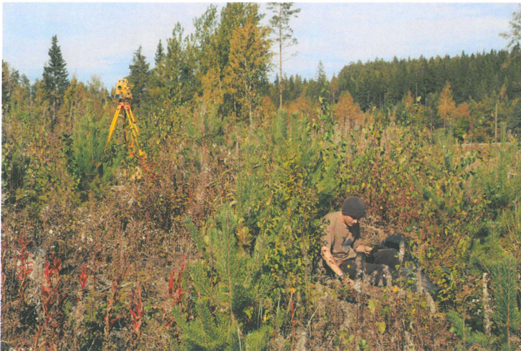
Kuva 2. Koekuoppaa kaivetaan taimikon ja vesakon seassa. (TYA 17:8)
