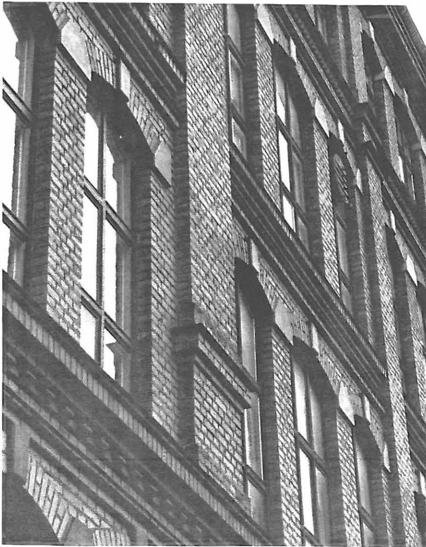
Kuva 93. TR 37, Siperia, julkisivumuurausta
