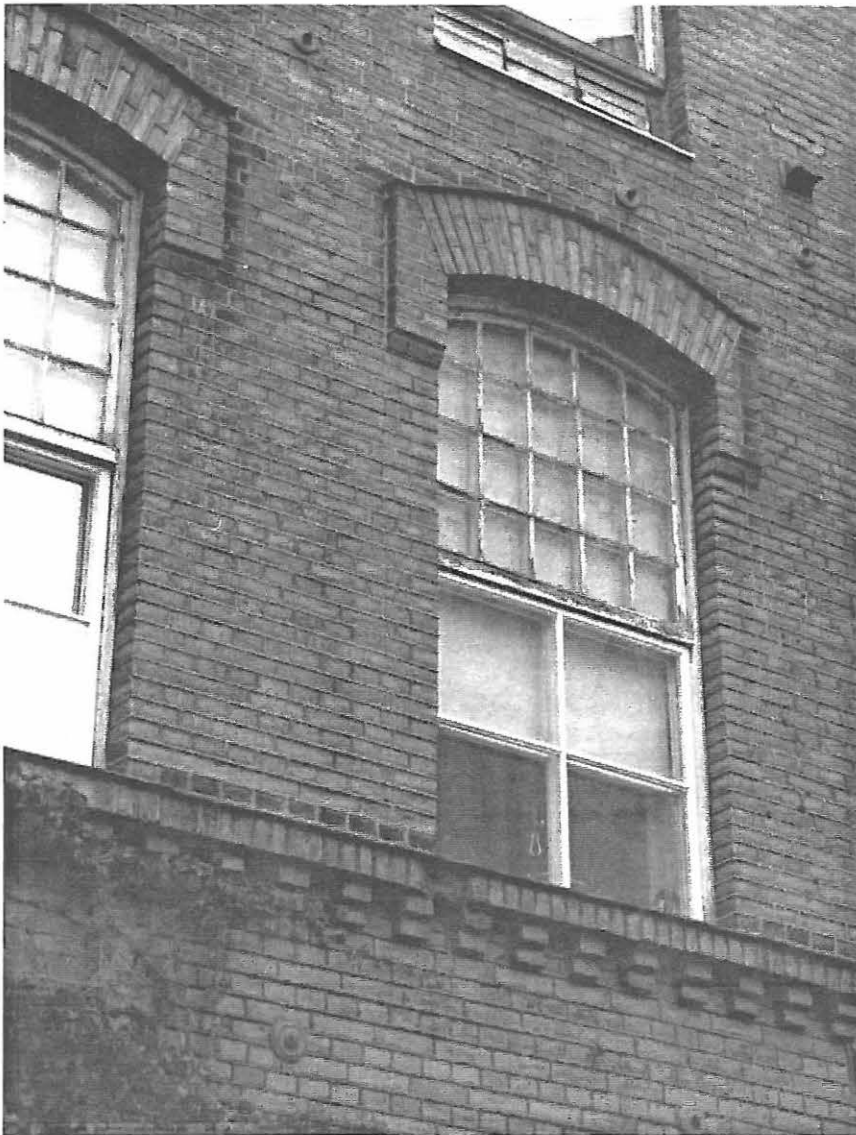
Kuva 85. Yksityiskohta TR 31 julkisivumuurauksesta
