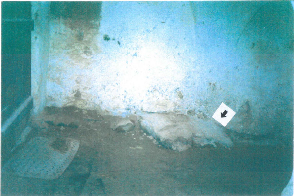
Kuva 3. Päälinnan kellaritilat on louhittu alla olevaan graniittikallioon, joka näkyy monin paikoin kellarin lattiassa. Osa kalliosta on tummaa tulen jäljiltä.
