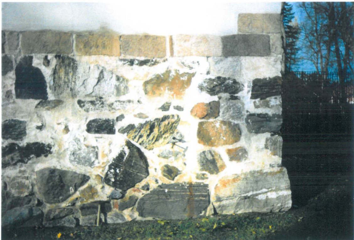
Kuva 4. Linnan vasemman sivurakennuksen itäseinän kivijalka on muurattu päälinnan kellaritiloista louhituista lohkeista ja lähiympäristöstä kerätyistä irtokivistä. Perusmuurin ylin yksirivinen kivivyö on ruotsalaista hiekkakiveä.
