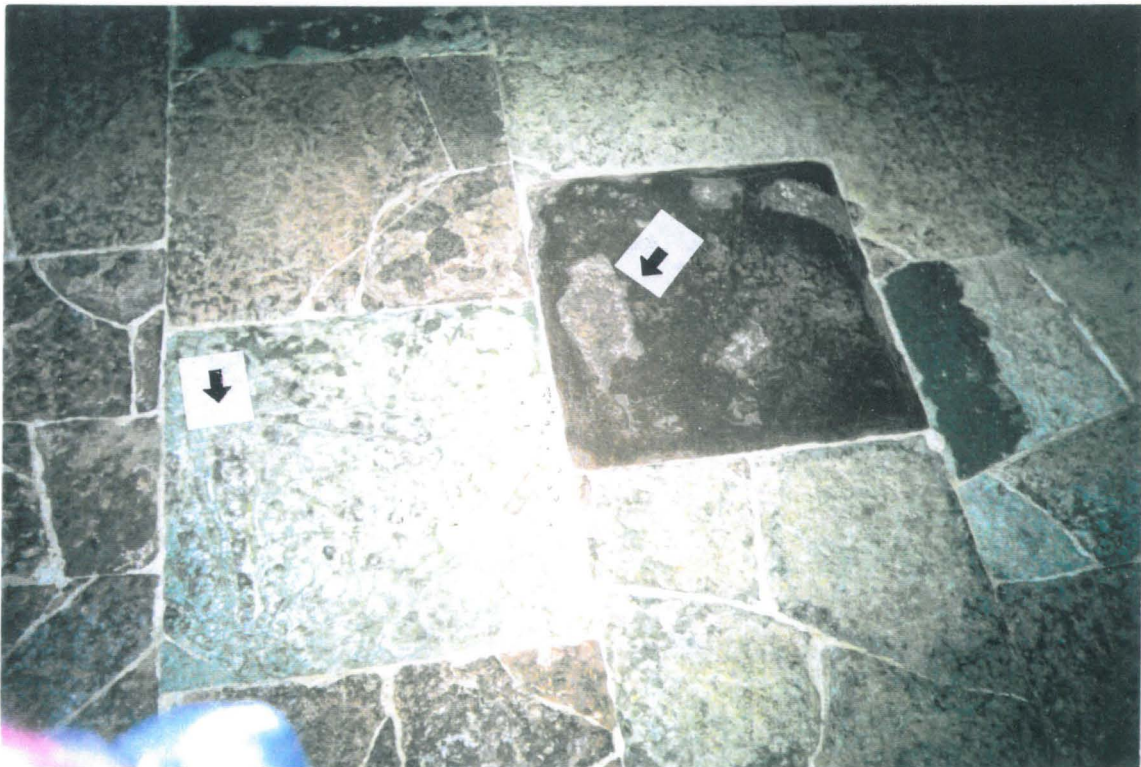
Kuva 7. Myös linnan vanhan keittiön lattia on päällystetty Öölannista tuoduista harmaista ja punertavista kalkkivilaatoista, joissa näkyy mm. oikosarvisten fossiileita.
