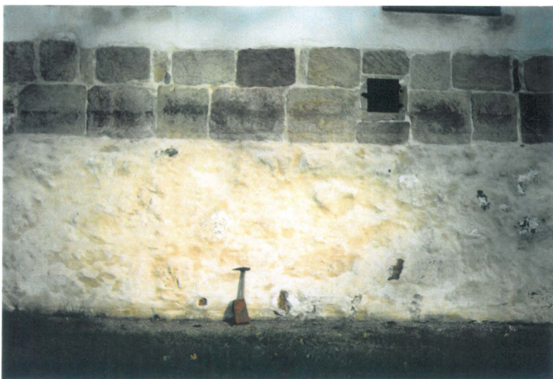
Kuva 5. Linnan länsiseinän kivijalka. Kaksi ylintä kiviriviä ovat gotlantilaista hiekkakiveä. Laastin alla olevat lohkarit ovat paikallisia peruskallion kiviä. Osa on linnan alla olevasta kalliosta kellaritiloja varten louhittuja irtolohkareita.
