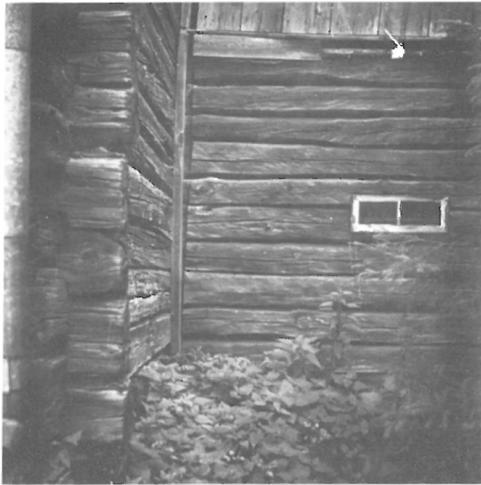
Kuva 14. Vähä-Kohmon tilan ulkorakennuksen hirsisalvosta.
