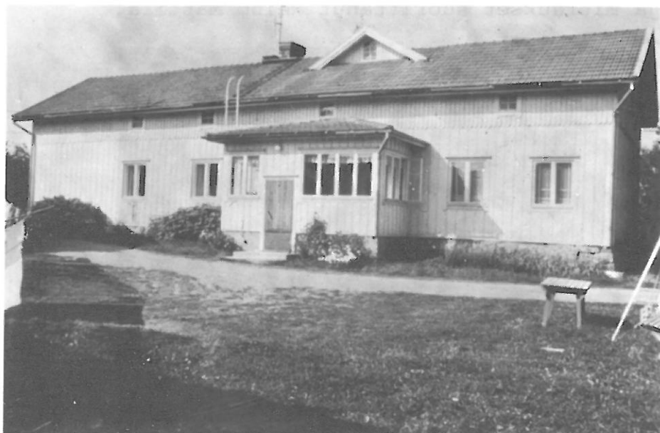
Kuva 31. Vähä-Kohmon asuinrakennus pihan puolelta.
