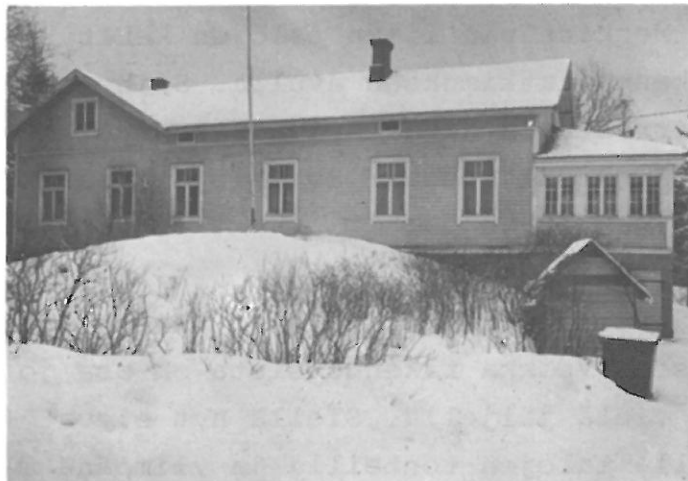
Kuva 37. Vähä-Rasin asuinrakennus luoteesta katsoen.
