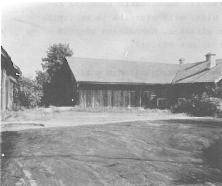
Kuva 23. Iso-Kohmon pihan sisääntuloväylä. Taustalla karjarakennus, oikealla asuinrakennuksen nurkka.
