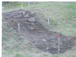
Pintamaan poiston jälkeen
