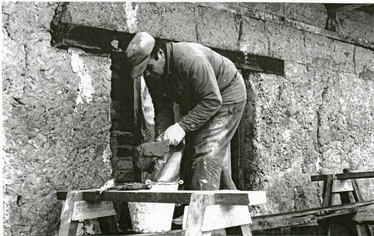
Arvi Sabel muuraamassa savipakarin ikkunan sivujen muurauksia. SatM.
