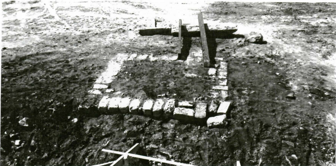
Slagitiiliperustus kankipajan länsipuolella. SatM.
