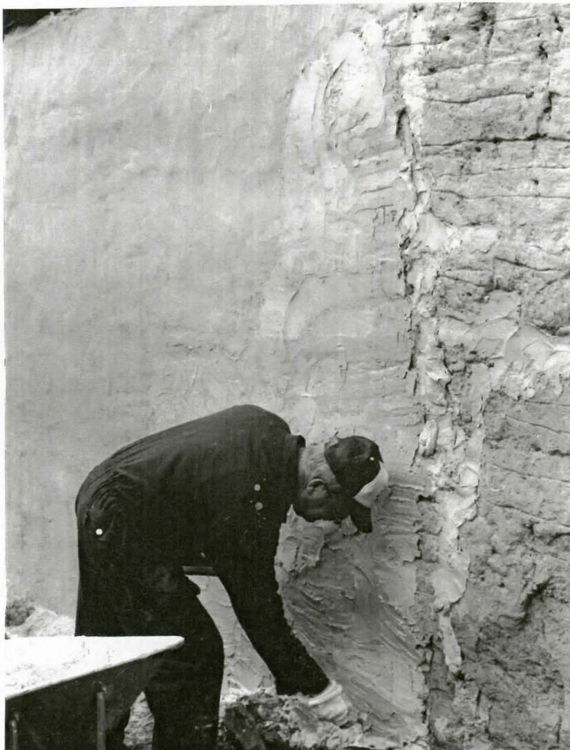
Saviseinän paikkausta polttamattomilla tiilillä. SatM.
