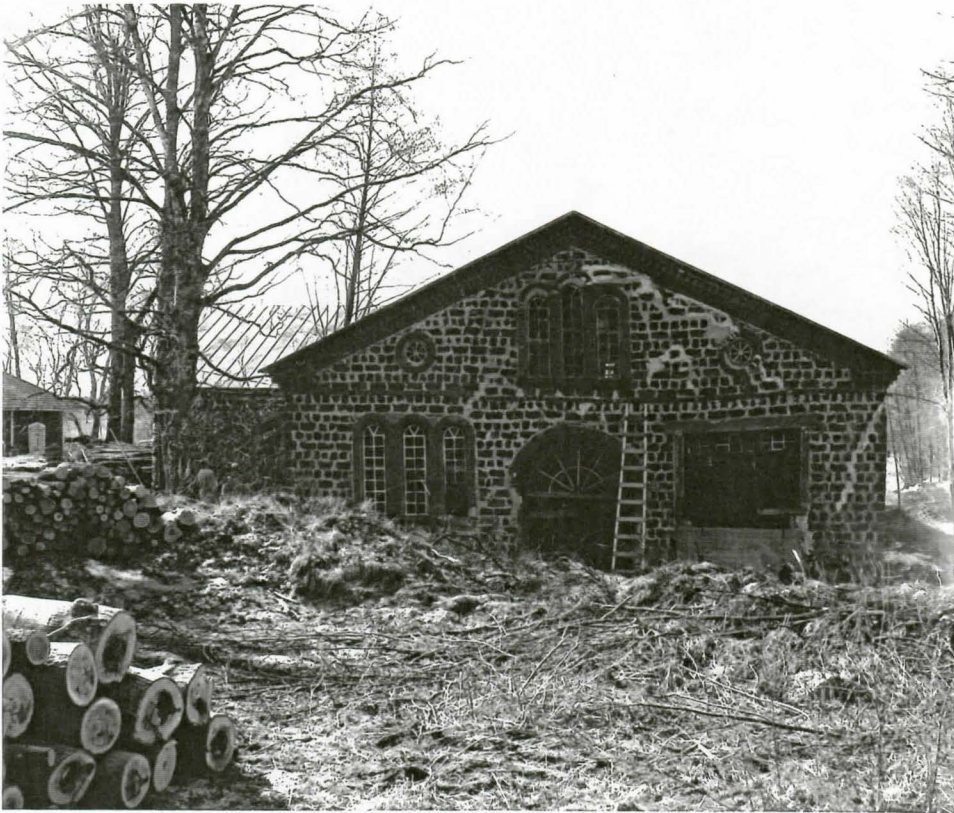
Kankipajan itäpääty ennen korjausta. MV/RHO.
