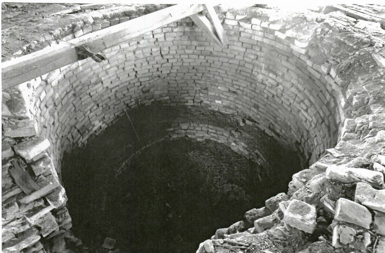
Masuunin piipun yläosa ennen korjauksia. SatM.
