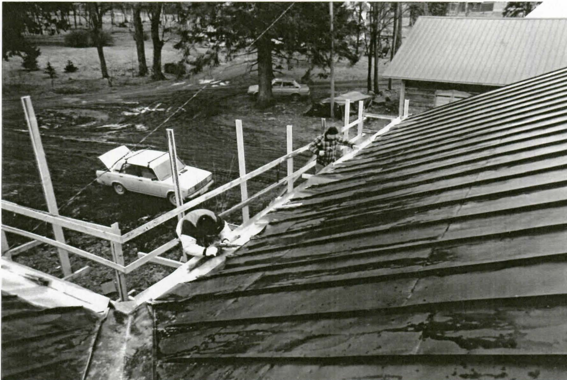
Jalkarännien tekoa vanhaan peltikattoon. SatM.
