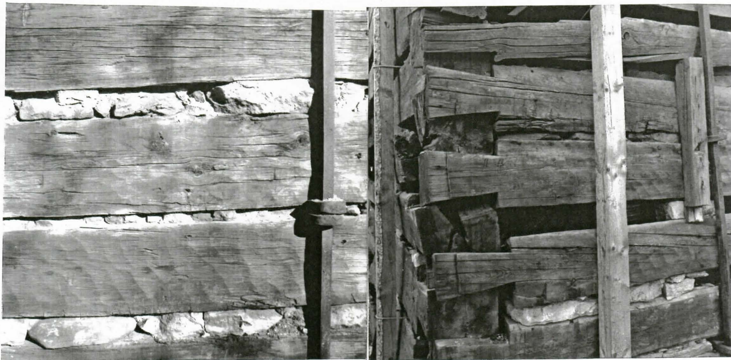
Vasemmalla ulkoapäin hyväkuntoisen näköisiä hirsiiä, oikealla alunperin huonokuntoisimmalta näyttänyt luoteisnurkka. SatM.
