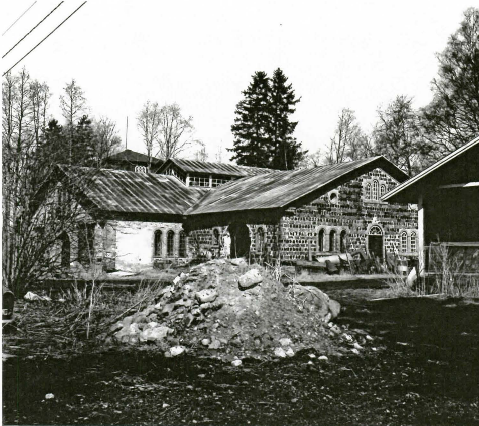
Kankipaja lounaasta ennen korjaustöiden alkua. MV/RHO
