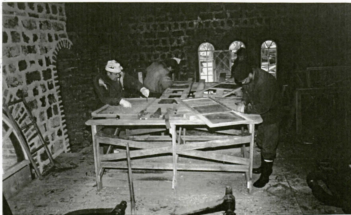
Kankipajan ikkunoiden korjausta ja uusimista kunnostetussa puutyöverstaassa. SatM.
