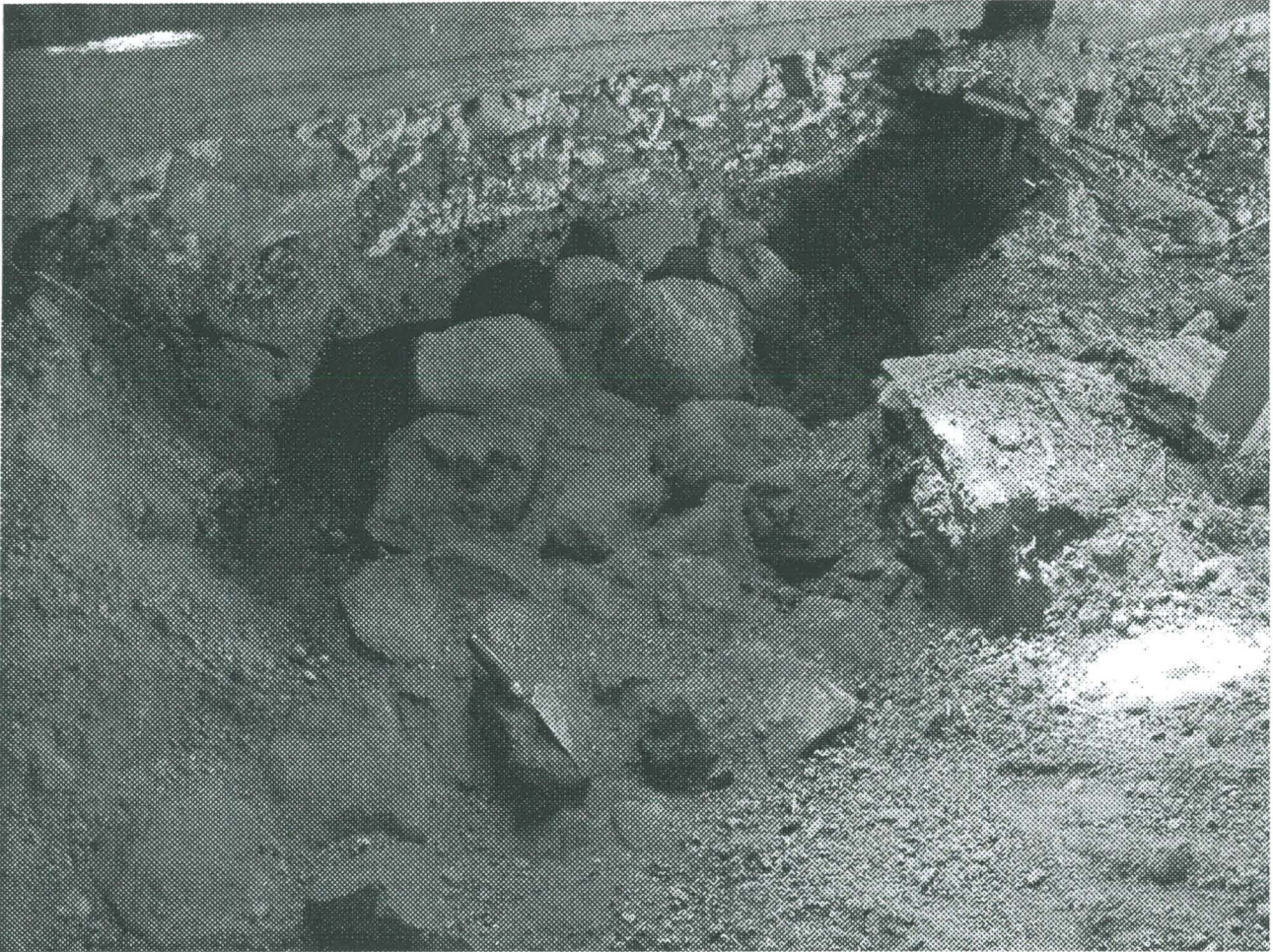
Koekuopassa 2 paljastettua kiviperustaa. Lastan kärjen kohdalla tiilen kappale. Jouni Taivainen.
