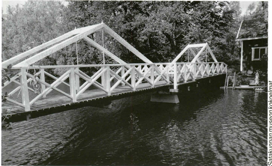
Uudelleenrakennettu kävelysilta joen poikki. Rebuilt pedestrian bridge crossing the river.
