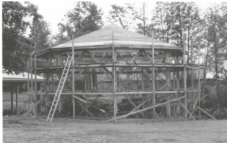
Pasutusuunin esiinkaivettujen raunioiden suojakatos rakenteilla. Construction of protective roofing for the excavated remains of the roasting kiln
