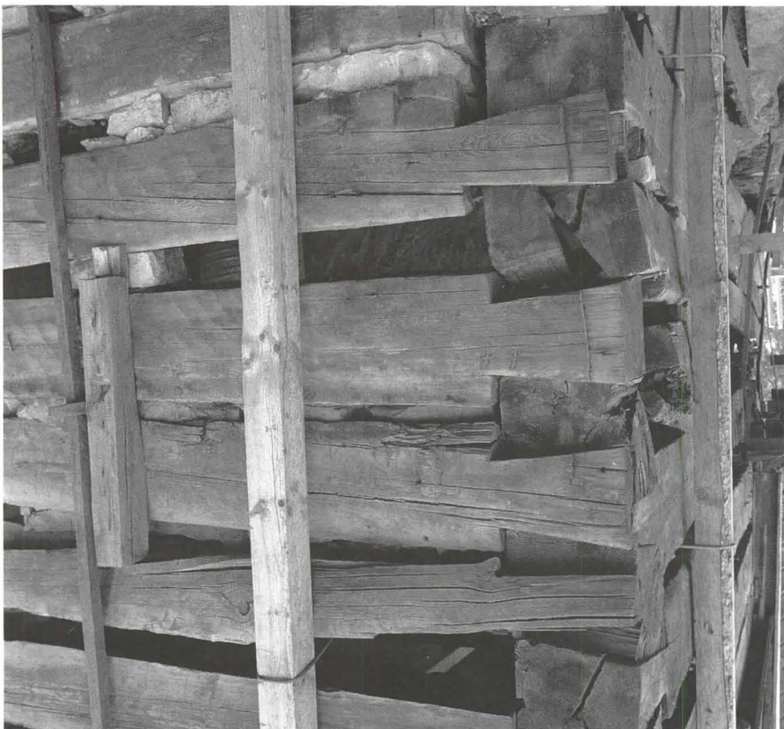
Masuunin alkuperäistä multahirsirakennetta. The original timber-clad construction of the blast furnace.
