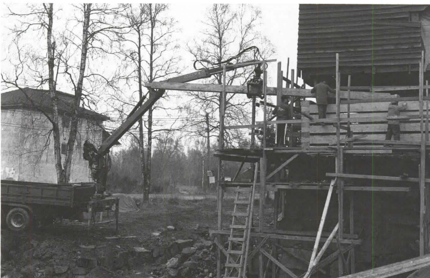
Uusia multahirsiä nostetaan paikoilleen. New timber cladding being installed.
