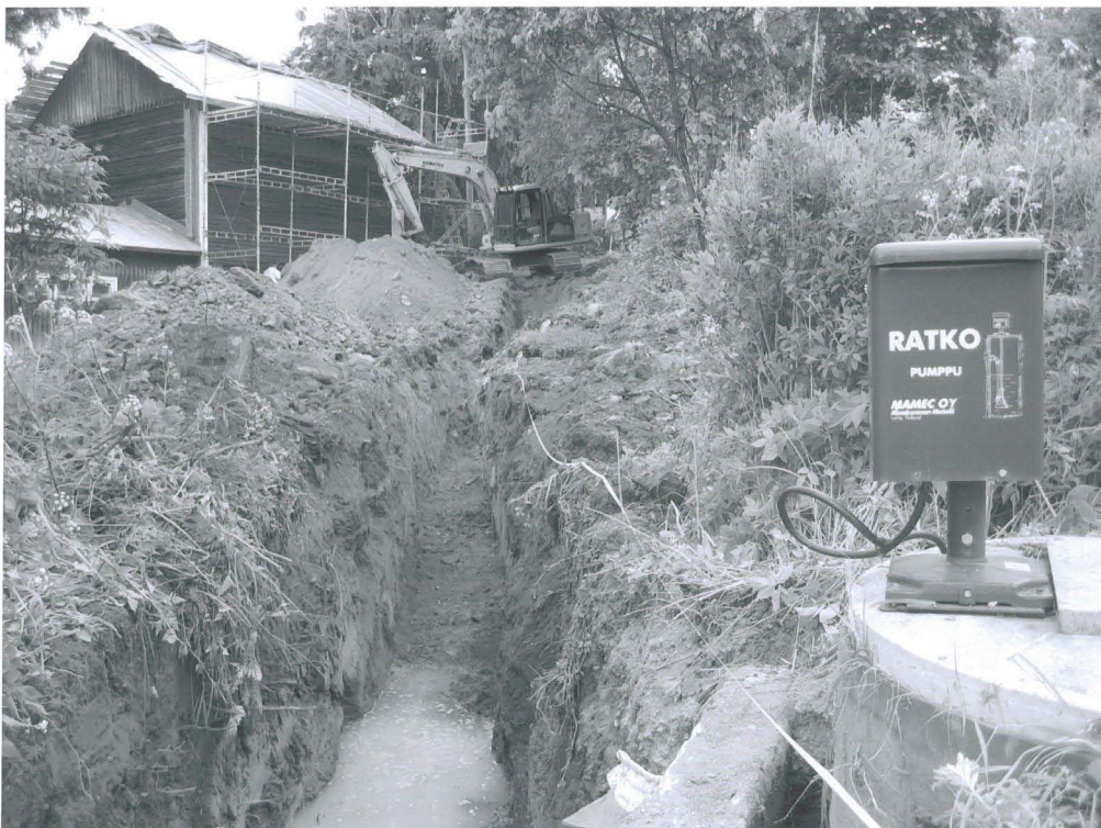
Kuva 4: Yleiskuva ojasta 1. Etelästä. JT.
