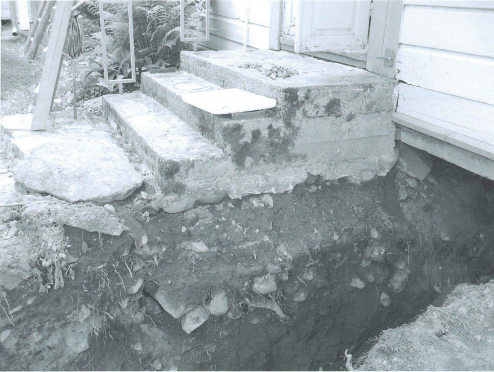
Kuva 13: Oja 3 alkoi Ylikartanon päärakennuksen koillisseinustan luoteispäädyn sisäänkäynnin luoteispuolelta. Portaiden alla näkyy vanhempi tumma likamaakerros ja sen alla vaaleampaa likamaata sekä kiveystä. Luoteesta. JT.
