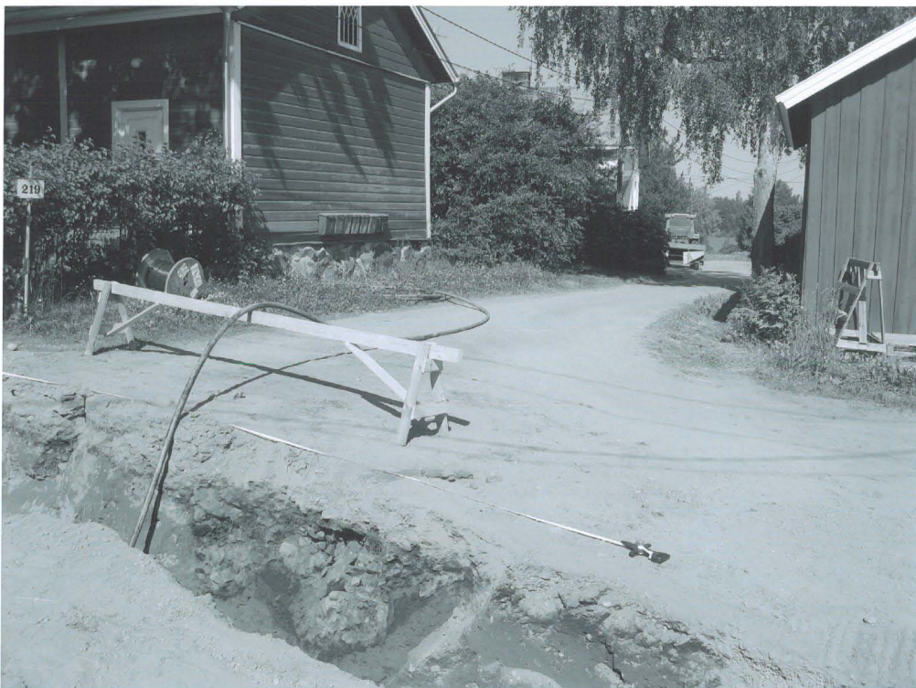
Kuva 20: Liesi/kiuasrakenne ojan 3 luoteisprofiilissa 37,5-40,5 metrin kohdalla kylänraitin alla. Idästä. JT.
