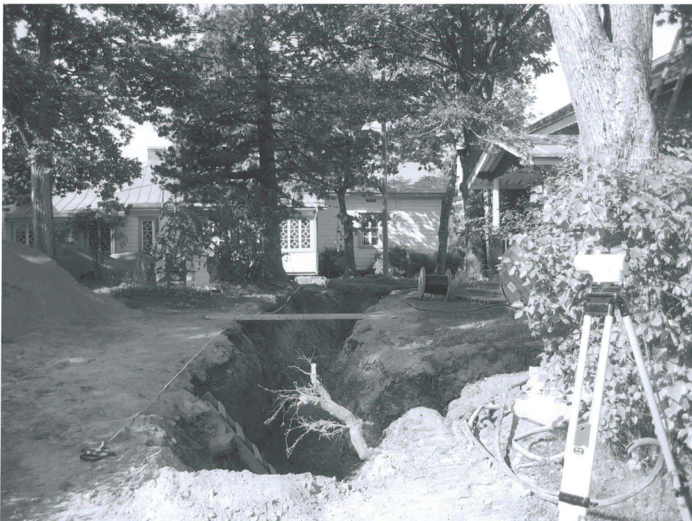
Kuva 12. Yleiskuva ojasta 3 Ylikartanon piha-alueella. Kuva otettu kylänraitilta. Oikealle haarautuu oja 4 ja sen takana hämmöttää kaapelikelan kohdalla ojan 1 ja 3 haara. Taustalla Ylikartanon päärakennus. Koillisesta. JT.
