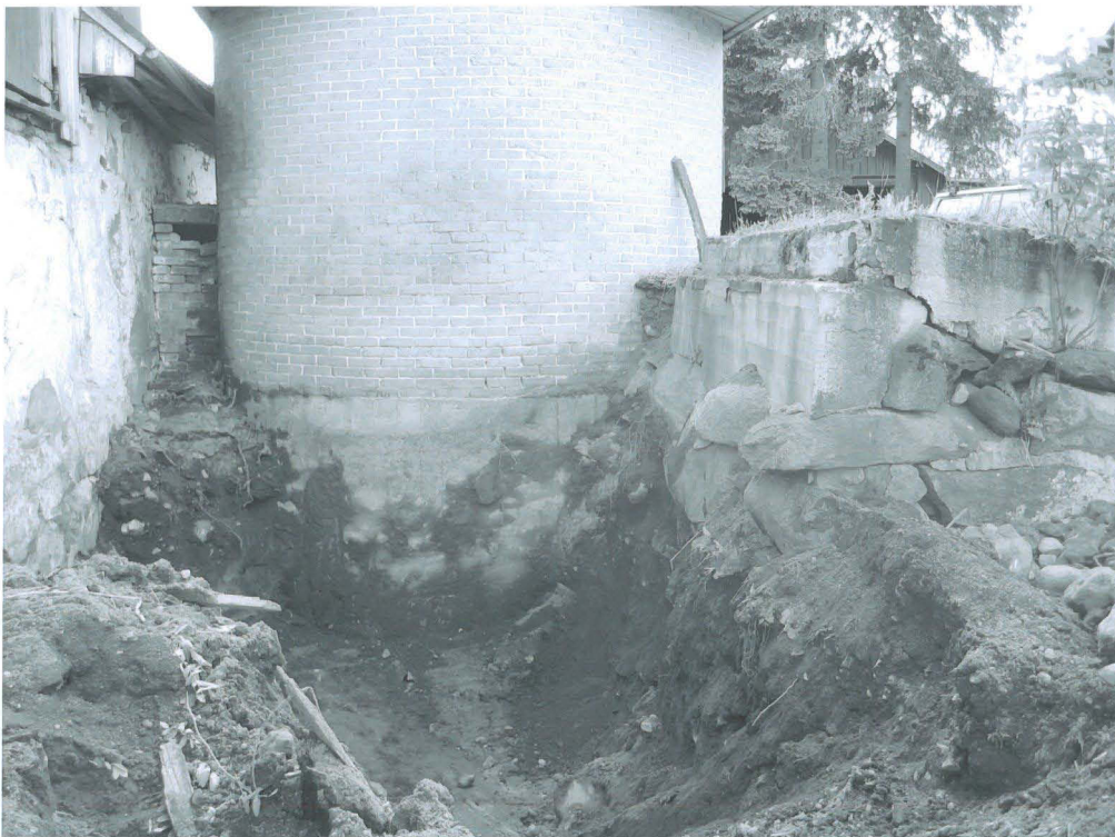
Kuva 24: Ylikartanon navetan lounaisseinustaa paljastettuna ojassa 3. Oikealla ylisille menevän ajoluiskan kiveys, keskellä rehusiilo, vasemmalla navetan seinusta. Luoteesta. JT.
