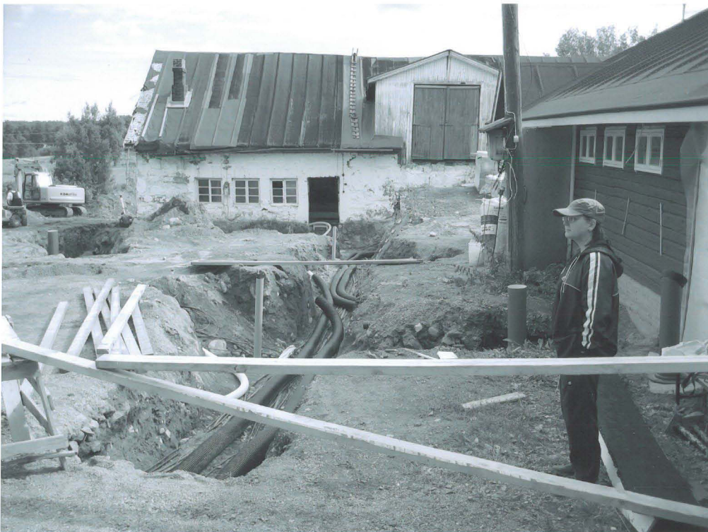
Kuva 22: Yleiskuva osittain täytetystä ojasta 3 Ylikartanon karjapihan alueella. Oikealla oja 8 risteää Ylikartanon tallin luoteisseinustalle. Vasemmalla osittain täytetty oja 9 (punaisen putken kohdalta) liittyy Ylikartanon navetan seinustalla ojaan 3. Lounaasta. JT.
