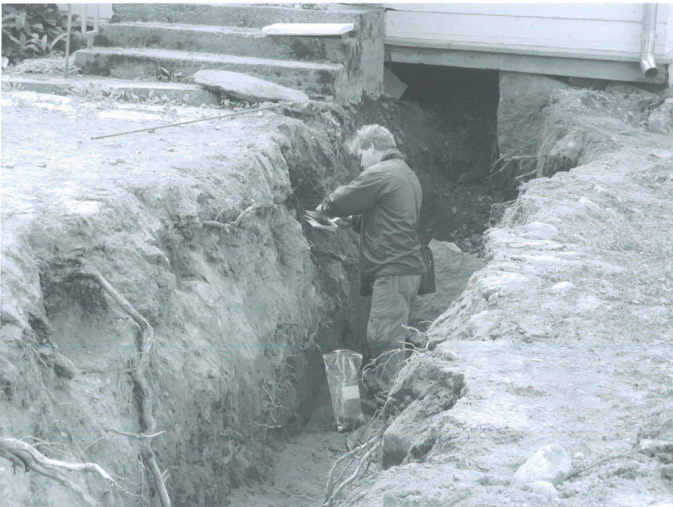
Kuva 14: Oja 3, Jouni Taivainen ottaa makrofossiilinäytettä kaakkoisprofiilin rakenteesta välillä 2-3 metriä. Pohjoisesta. Tiina Jäkärä.
