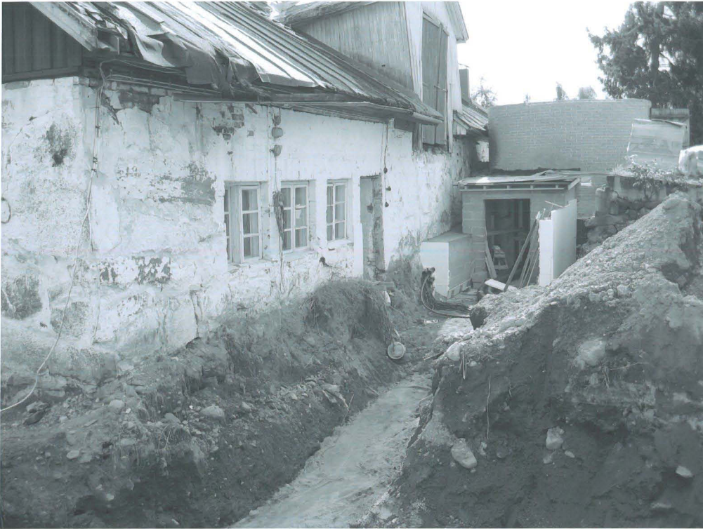
Kuva 23: Ojan 9 ja 3 risteys Ylikartanon navetan luoteispään etelänurkalla. Luoteesta. JT.
