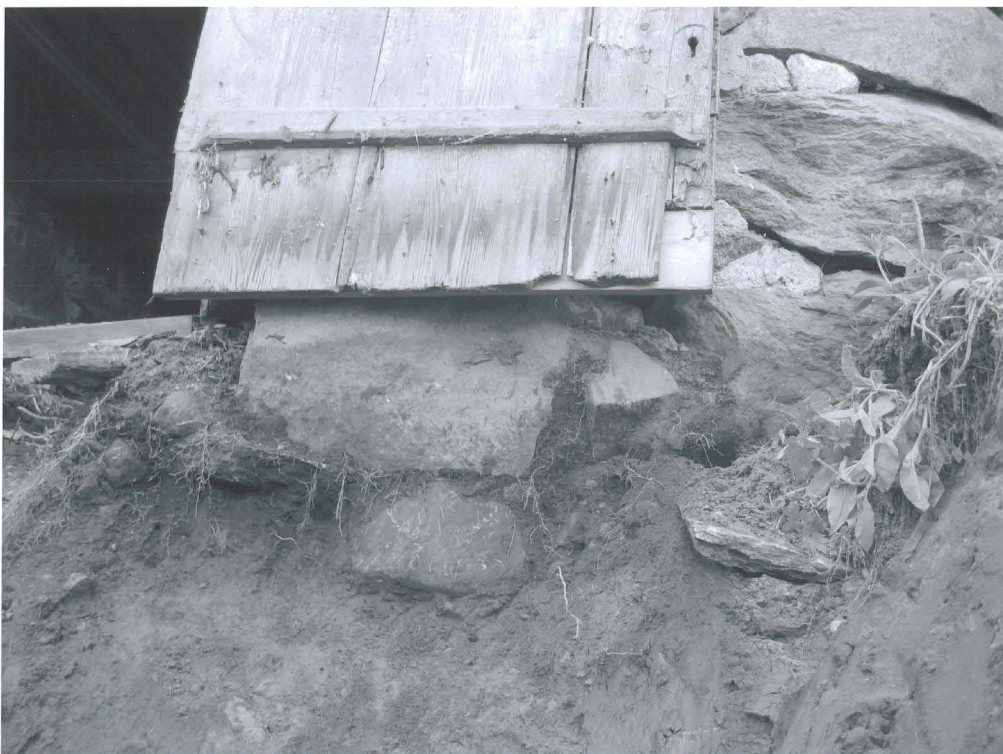
Kuva 10. Ylikartanon päärakennuksen luoteispäädyn perustus. Luoteesta. JT.
