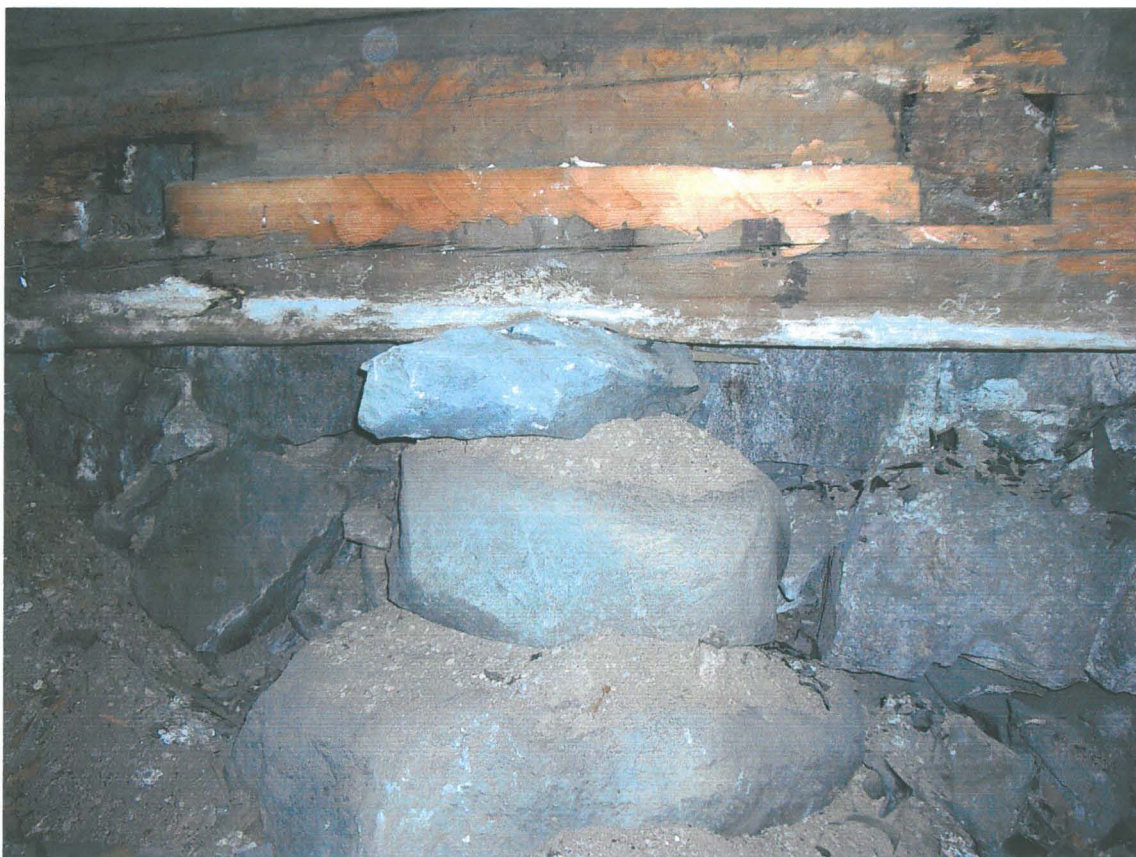
Kuva 5. Edessä hirsirakennuksen itäseinän "aluskipylväs" ja taustalla itäpuolisen kivirakennuksen kivijalka. Kuva lännestä. 3.1.2005
