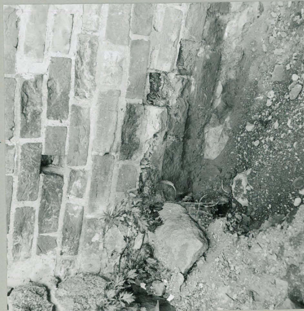
24-28.: RUNKOHUONEEN ETELÄSEINÄ ASEHUONEEN VASEMMALLA PUOLELLA; TIILI- SEINÄN ALAOSA KONTREFORIN JA ASEHUONEEN VÄLISSÄ
