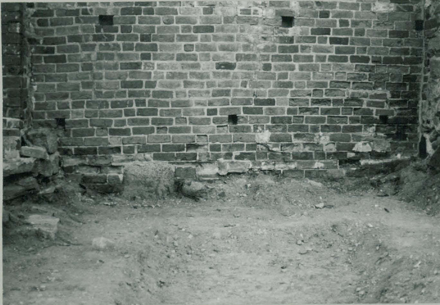
22. RUNKOHUONEEN ETELÄSEINÄ ASEHUONEEN VASEMMALLA PUOLELLA; TIILISEINÄN ALAOSA KONTREFORIEN VÄLISSÄ SEN JÄLKEEN KUN PENSAAT JA MAATA OLI POISTETTU
