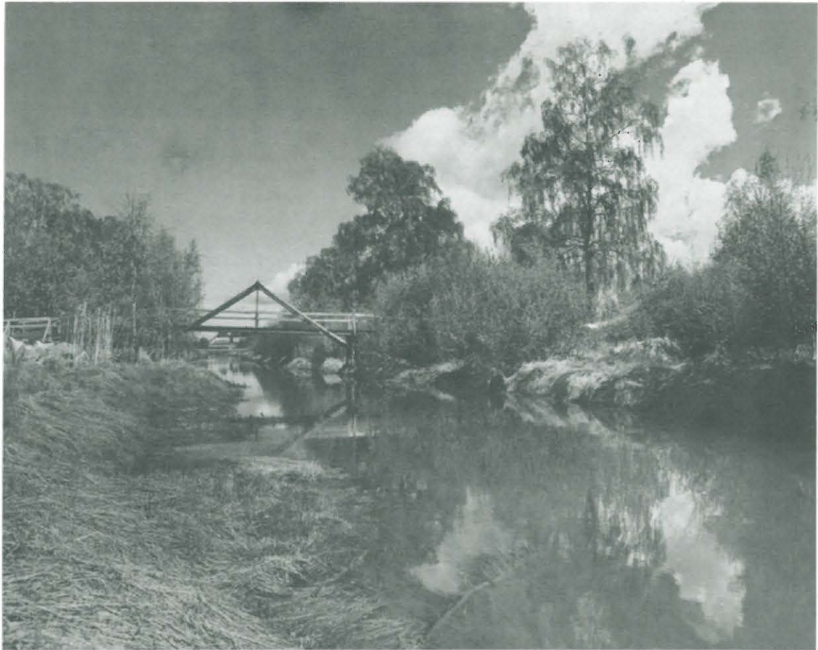
Kaupunginsalmi oli 1700-luvun alussa vielä merkittävä kulkureitti. Kuva M. Julkunen.
