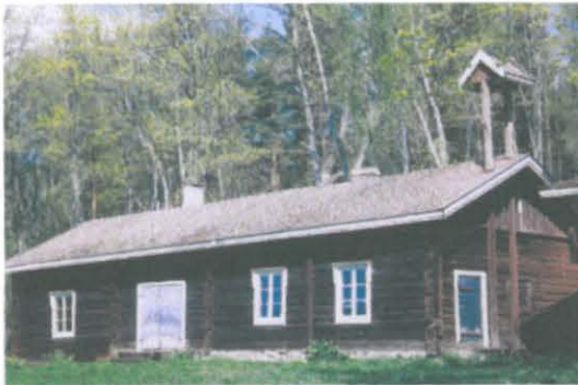
1) julkisivu etelästä päin katsottuna
