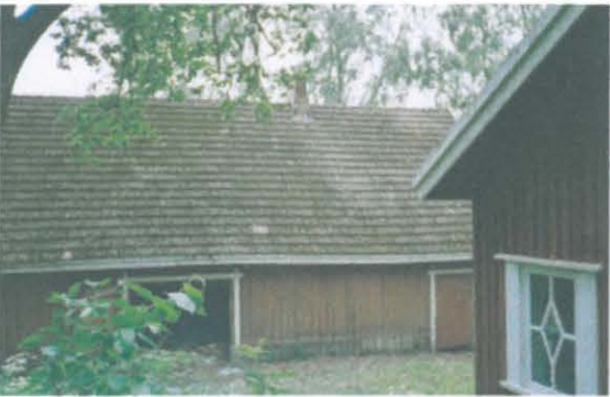
3) liiteripuoli eli koillista julkisivua
