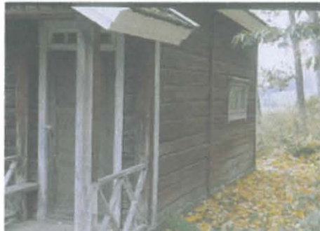
5) harjun puoleista eli koillista julkisivua
