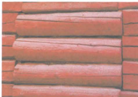
6) luoteissivun tukittu ikkuna-aukko
