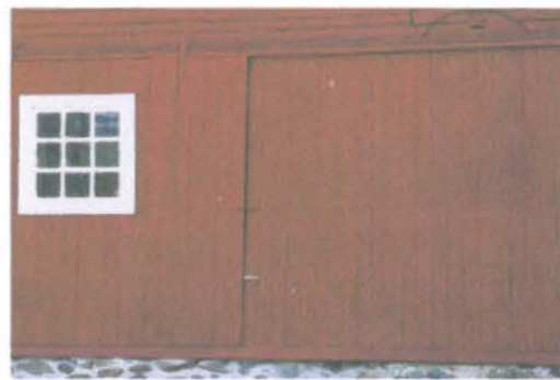
9) luoteispäädyn liukuovi ja ikkuna
