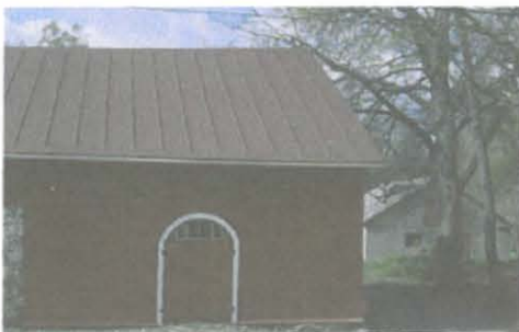
4) koillissivun pariovi luoteispäässä
