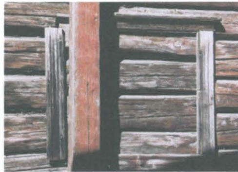
2) kaakkoispäädyn tukittu ikkuna
