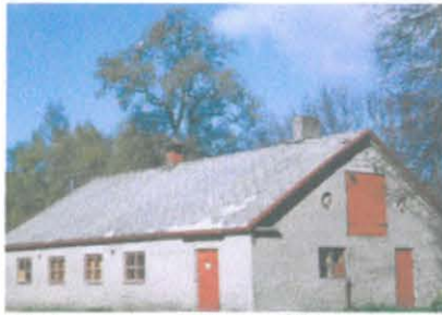
2) kaakkoista ja koillista julkisivua
