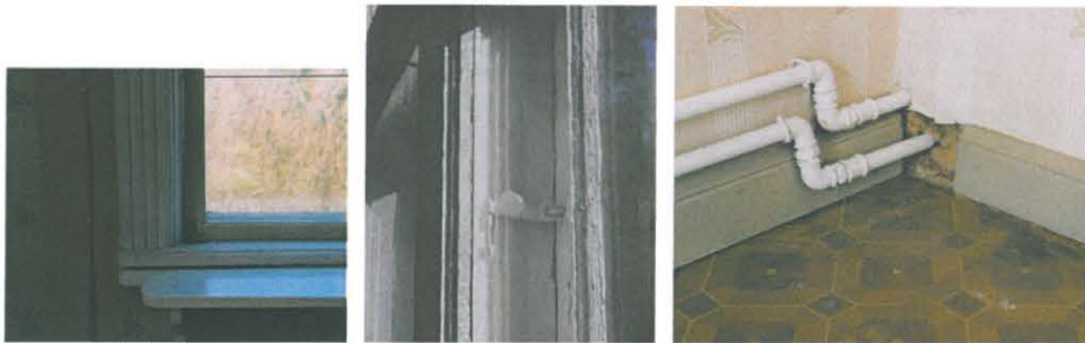
4) yks.kohta sivuikkunasta, 5) ulkopokan tuulihaka, 6) putkistoa ja korkkimatto
