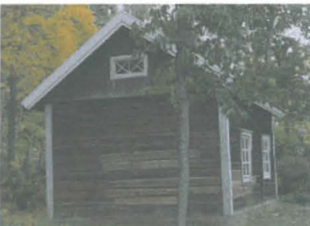
4) takaseinän korjattua seinää
