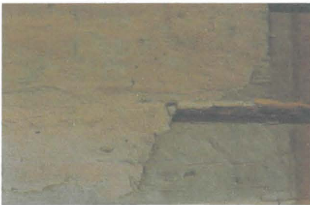
4) savirappausta avovintin seinissä
