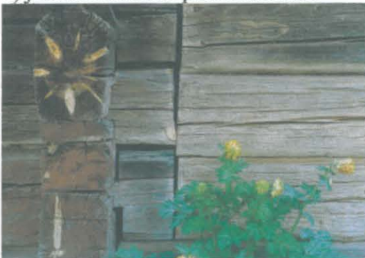
3) yksityiskohta lounaisseinän liitoskohdasta ja 4) följarista
