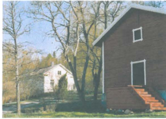
2) näkymä etelästä päärakennukselle päin
