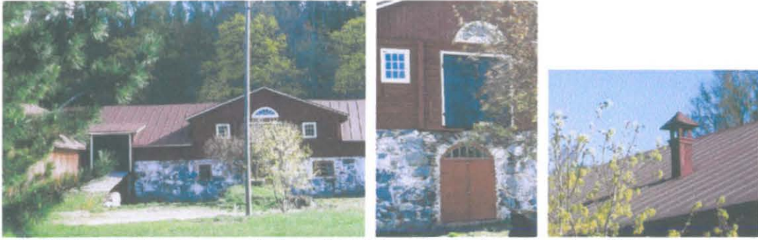
12), 13) ja 14) ajosilta parvelle ja poikkipääty sekä tuuletushormin pää lounaassa
