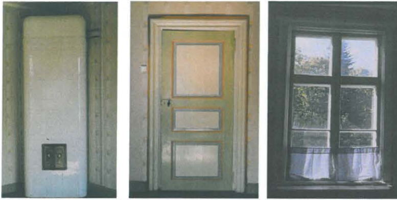
1) kaakeliuuni, 2) päätyhuoneiden välinen ovi, 3) sivuikkuna
