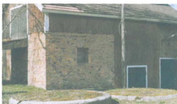
2) koillisivun edessä olevat purettujen siilojen pohjat
