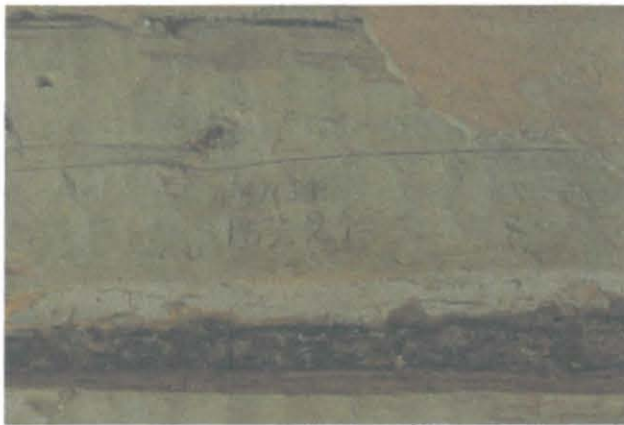
3) rakentajien nimikirjaimet ja päiväys avovintin hirsissä, oviaukon harjunpuoleisessa seinässä
