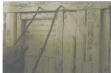
3) väliseinä pystyhirttä
