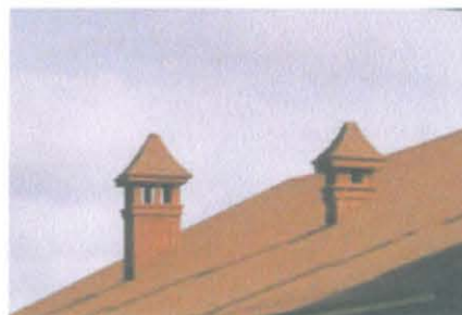
5) tuuletushormin päät katon koillislapeella
