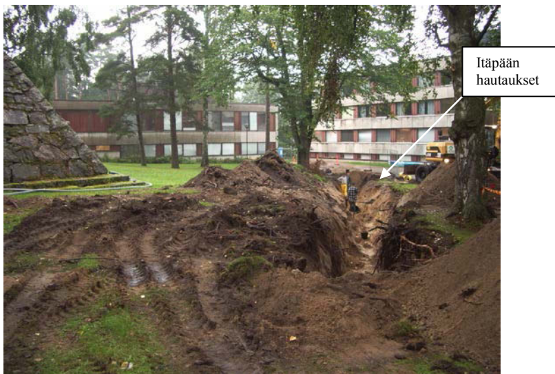
Kuva 1. Kuvassa kaivanto toisena työpäivänä. Kuva on otettu osapuilleen länsipään haudausten päältä. Kuva M. Niukkanen.
