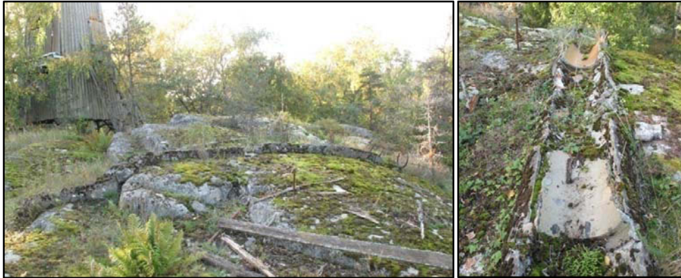
Kuvat 65 - 66 Osa ventilaattorin betonista kourua, jonka sisällä on keraaminen putki. Kuvat: U. Köngäs 2009
