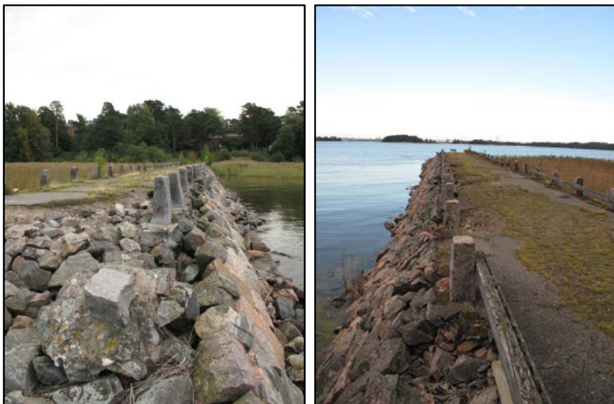
Kuva 117 (vasemmalla) Laituri merenpuoleinen pää on sortunut. Kuva: U. Kõngäs 2009. Kuva 118 (oikealla) Yleiskuva laiturista. Kuva: U. Kõngäs 2009.
