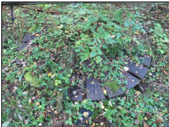
Kuva 88 (vasemmalla) Betonisessa ampuma-aseman jalustassa oleva tykkikehän kiinnitysalusta. Kuva: U. Kõngäs 2009.
