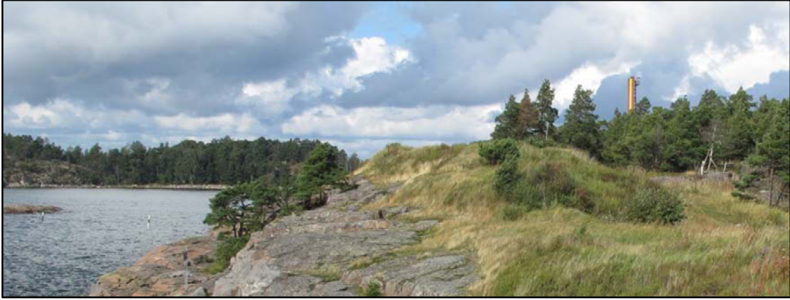
Kuva 38 Tykkipatterin I länsiosan maarakenteinen varustus kohoaa kallioiden päällä. Kuva: U. Kõngäs 2009.
