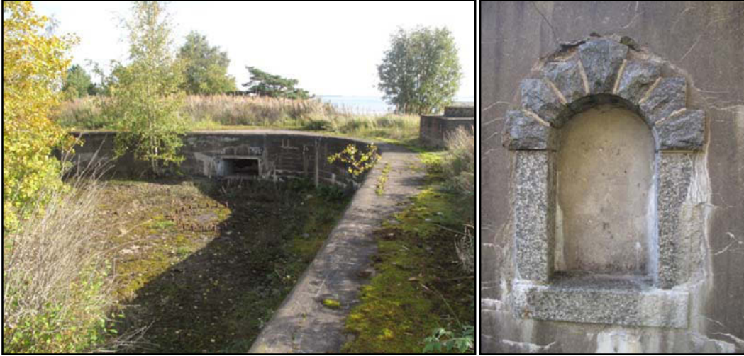
Kuva 60 (vasemmalla) Yksi tykkipatterin IV tykkiasemista ja betoninen rintavarustus. Kuva: U: Köngäs 2009. Kuva 61 (oikealla) Betonisessa rintavarustuksessa oleva ikonipaikka. Kuva: U: Köngäs 2009.
