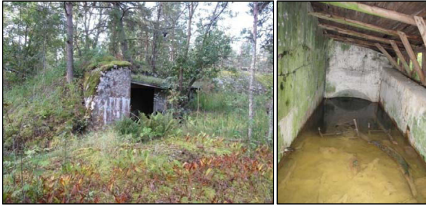
Kuvat 69 - 70 Kallioon louhittu tunneliruutikellari ja oikealla näkymä sen sisältä. Kellari jatkuu veden alla. Kuva: U. Köngäs 2009.
