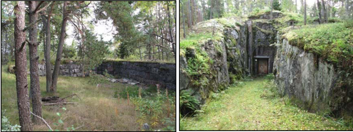
Kuva 12 (vasemmalla) Patterin kivirakenteinen rintavarustus. Kuva: U. Köngäs 2009.
