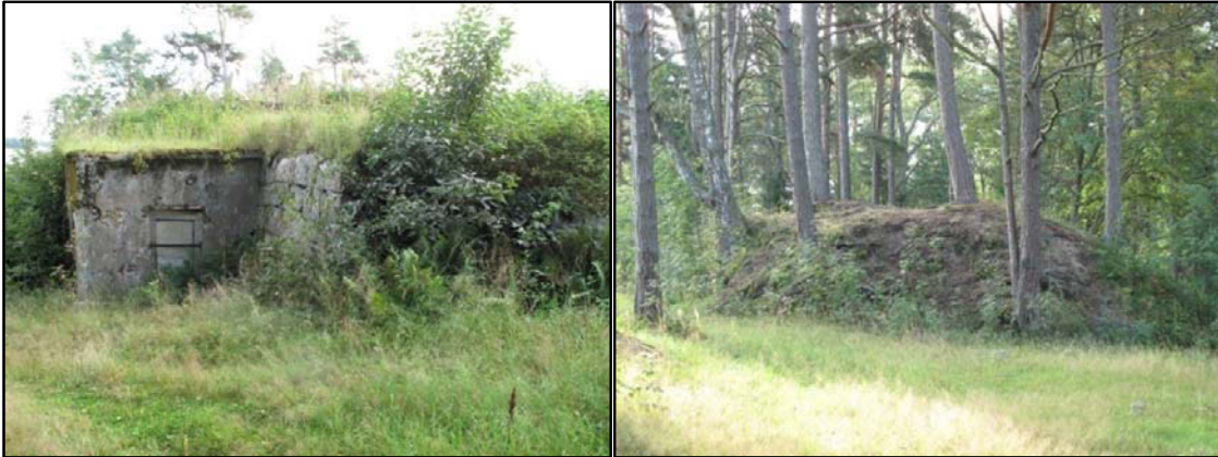
Kuva 18 (vasemmalla) Tykkipatterin luoteiskulmassa oleva betoninen ruutikellari ja kivillä tuettua patterin seinämää. Kuva: U. Köngäs 2009.
