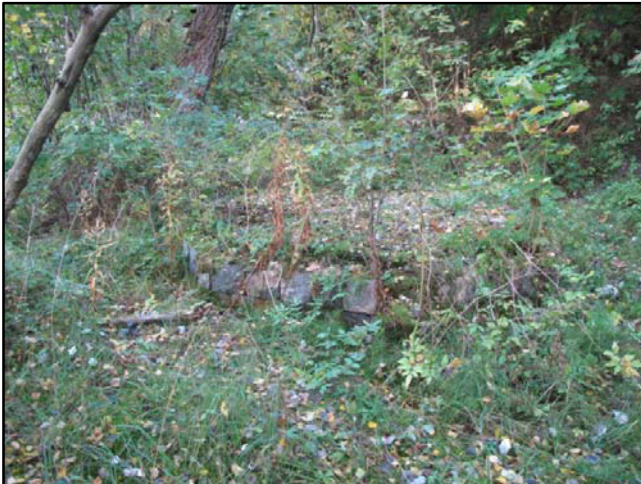
Kuva 97 Kaapelikaivo on kahdeksankulmainen ja sen reunat on kivetty. Kuva: U. König 2009.
