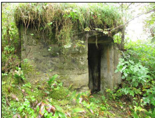
Kuva 93 Betoninen suojahuone. Kuva: U. Kögäs 2009.
