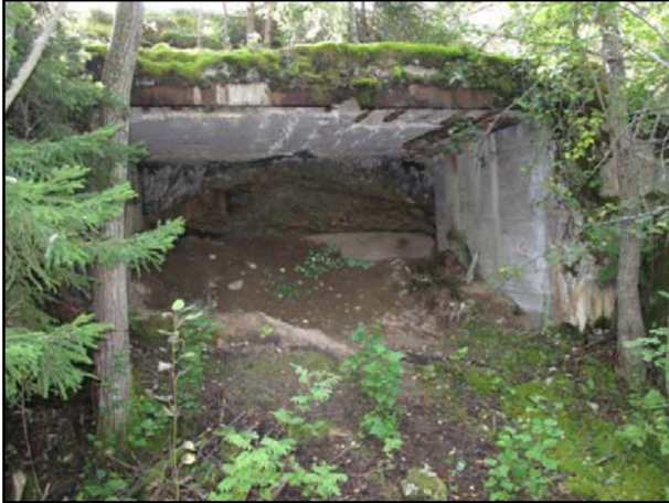
Kuva 92 Betoninen kallioon louhittu suoja. Kuva: U. Kögäs 2009.
