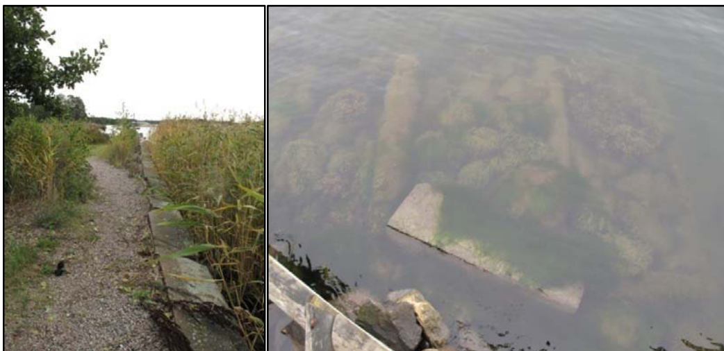
Kuva 113 (vasemmalla) Maanpuolustuskorkeakoulun laiturin osa rannan puolella. Kuva: U. Köngäs
