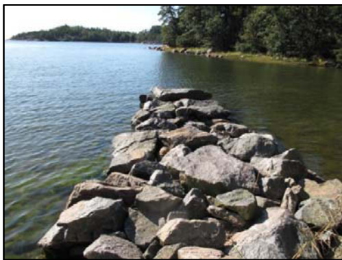
Kuva 130 (vasemmalla) Rannassa oleva kivinen laiturinperustus. Kuva: U. Köngäs 2009
