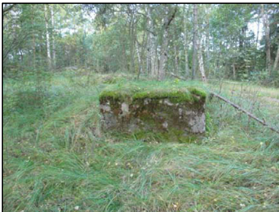
Kuva 88 (vasemmalla) Betonisessa ampuma-aseman jalustassa oleva tykkikehän kiinnitysalusta. Kuva: U. Kõngäs 2009.
