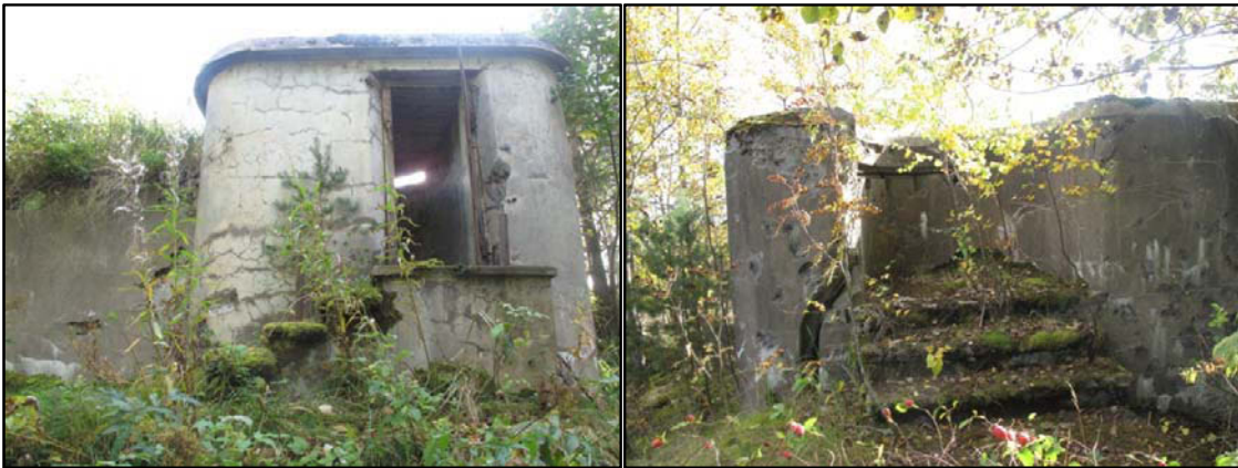
Kuva 63 (vasemmalla) Varustuksen länsipäädyn tähytys- ja tulenjohtotorni. Kuva: U. Köngäs 2009.
