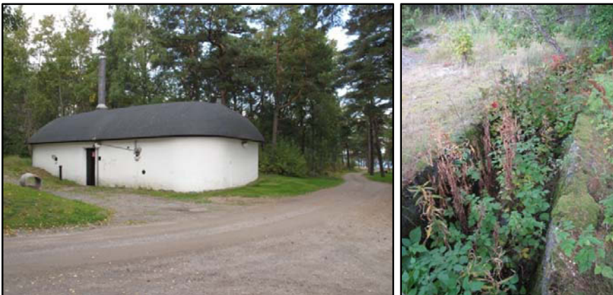
Kuvat 15 - 16 Vasemmalla on miina-asema ja oikealla siihen liittyvä kaapelikaivanto. Kuvat: U: Kõngäs 2009.
