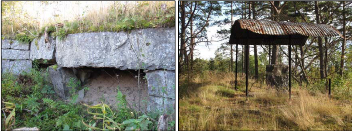
Kuva 50 (vasemmalla) Rintamuri on sortumaisillaan ampumarvikekomeron kohdalla. Kuva: U. Köngäs 2009.
