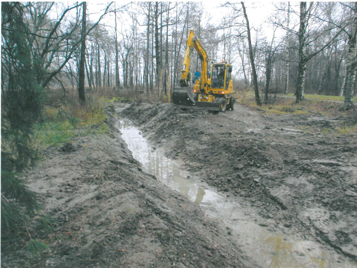
Puiston itäosassa Villa Arabeskin kohdalla kaivetaan puroa. Kuva länsiluoteesta. 10.11. Kuvat: Markku Heikkinen.
