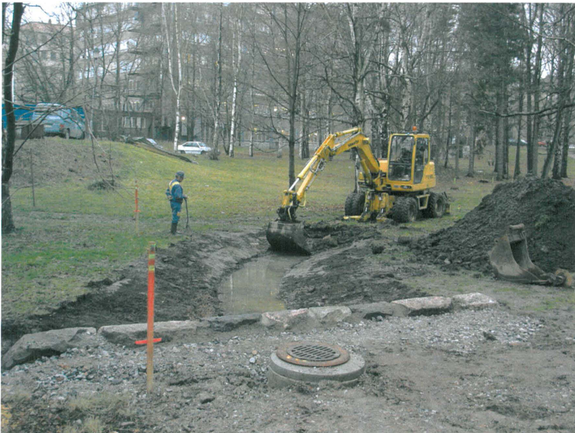
Puroa kaivetaan aivan Villa Arabeskin länsipuolella luoteis-kaakkosuuntaisen kevyenliikenteenväylän eteläpuolella.. Kuva koillisesta. 11.12.
