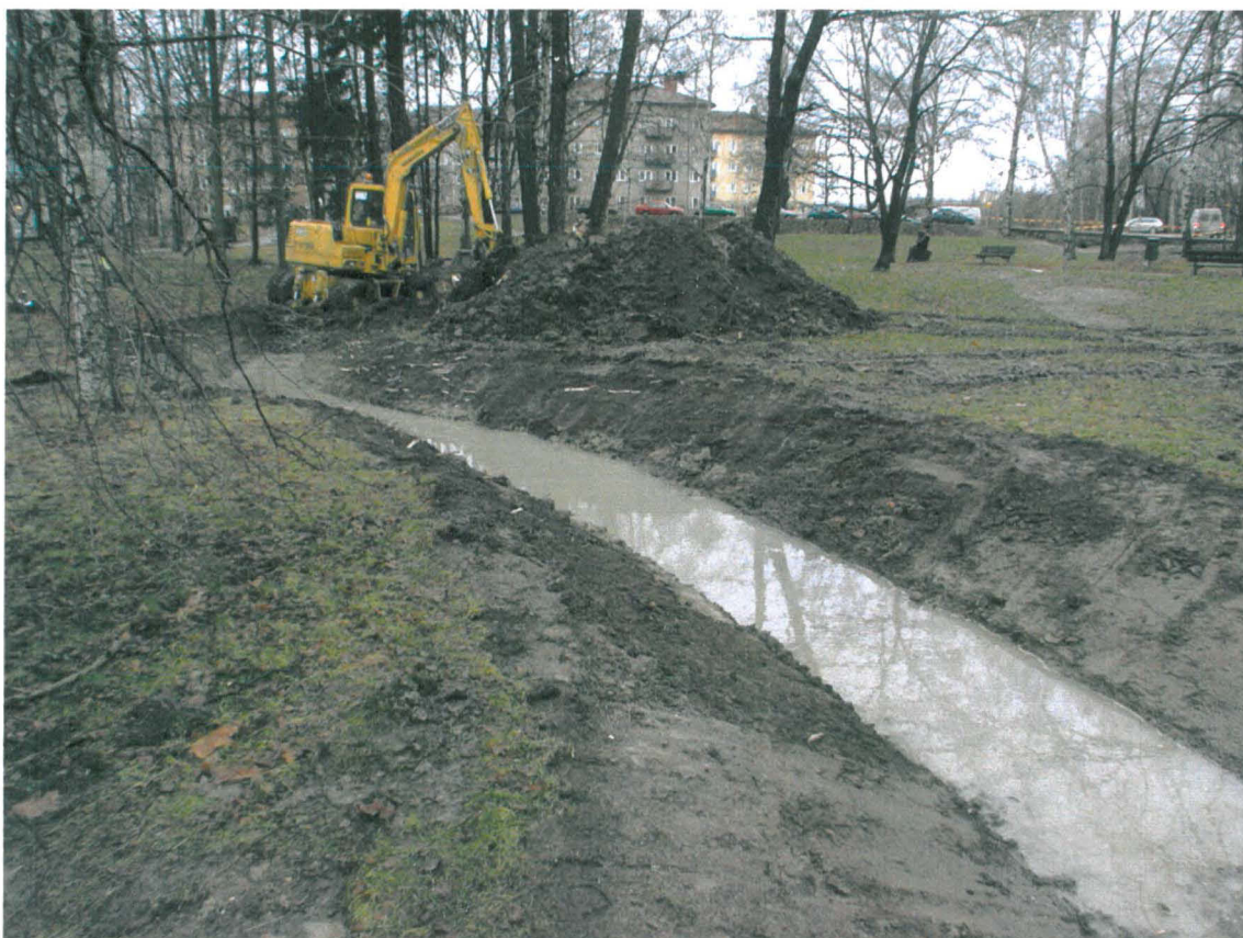
Puroa kaivetaan edellisen kohdan länsipuolella. Kuva idästä. 12.12.
