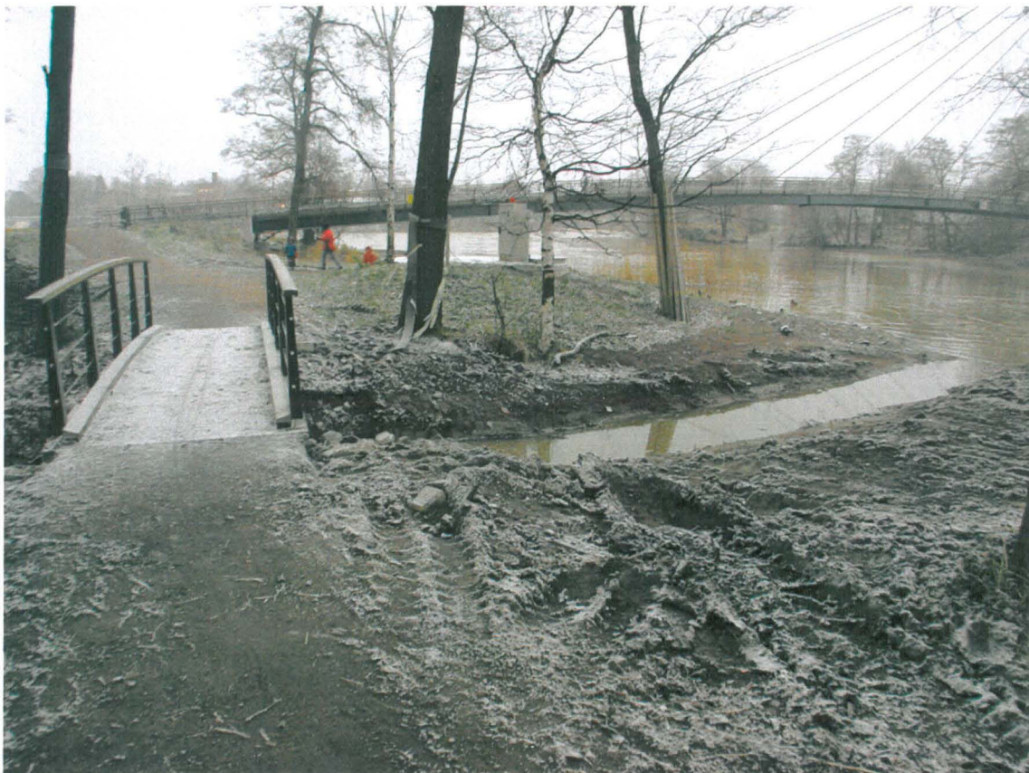
Puron suu kuvattuna etelästä. Puron ylittävä silta on sama kuin edellisen kuvan oikean reunan silta. Rannassa näkyy pumppuasema, jolla pumpataan vettä puron latvalle. 21.11.
