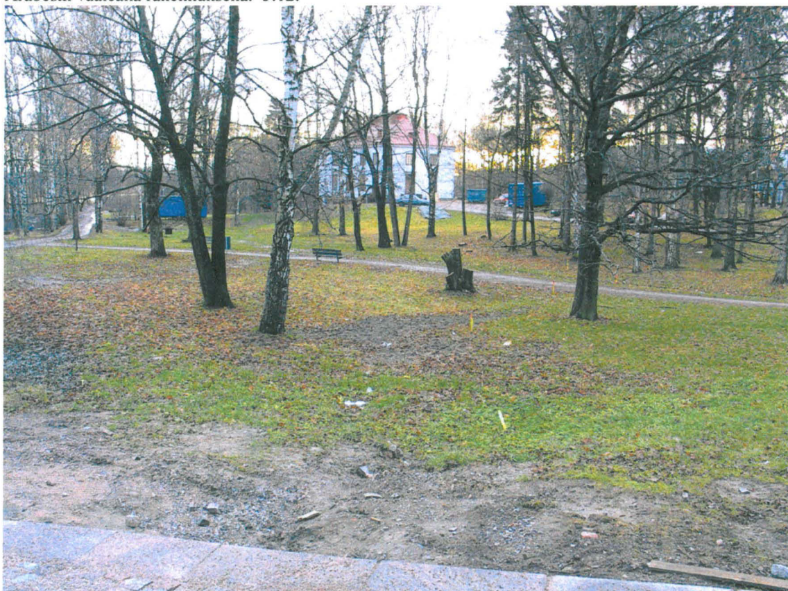
Verkatehtaanpuiston länsiosa ennen puron kaivamista. Tausta näkyy Villa Arabeski. Puron linja on merkitty paaluilla. Kaivausalue sijaitsee kuvan keskellä näkyvän kannon oikealla puolella kevyenliikenteenväylän takana. Kuva luoteesta. 5.12.
