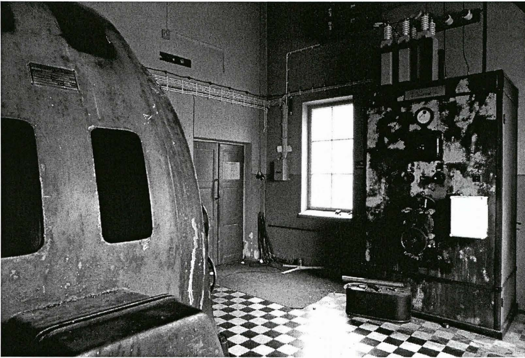
Sisäkuva voimalaitokselta. Kuvassa kolmivaihesynkronimoottori ja peltinen kojekaappi. Matti Huuhka 1998, Museokuva, MV.
