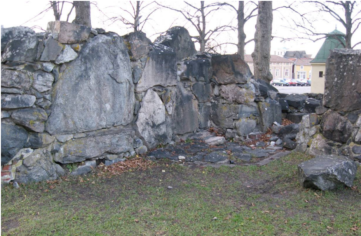
Kuva. Tiilipilasterien varaan tehdystä holvauksesta on vielä näkyvissä pilastereiden perustukset. Pohjoisseinällä näkyy myös porrasaukko. Päivi Hakanpää RHOA 126049:1.
