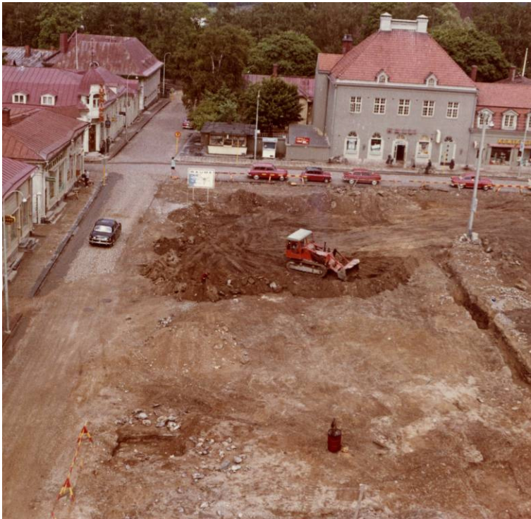
Kuva. Kauppatorin maakerroksia poistetaan kaivinkoneella vuonna 1966. Pentti Koivunen 1966 RHOA.
