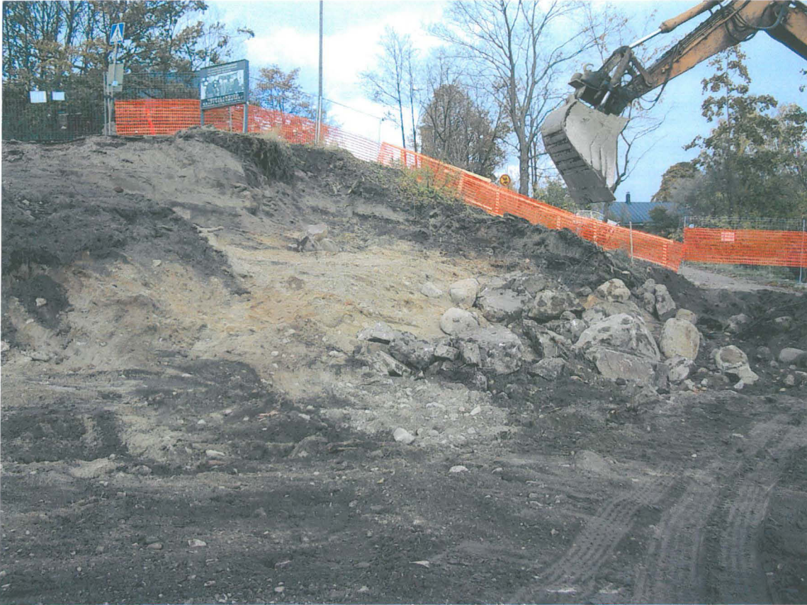
Kuva 35. Valvonta-alueen koilliskulmasta on kaavittu saastunutta maata pois. Kuvan vasemmassa reunassa näkyy rantaan johtava tie. Kuva kaakosta. 11.10.2004.
