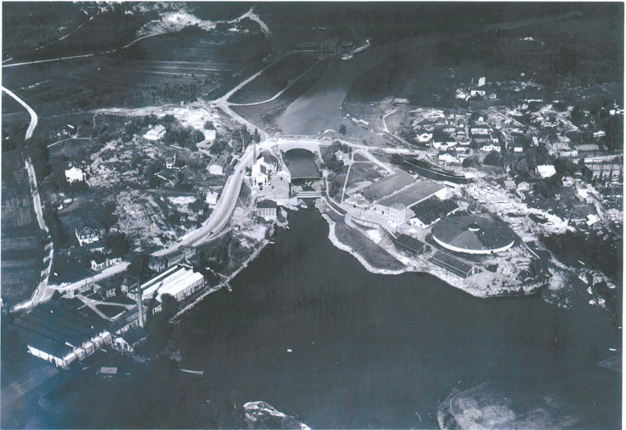
Valvonta-alue näkyy vasemmassa nurkassa olevan verkatehtaan pohjoispuolella n. vuonna 1930. Handolinin värjäämö oli sijainnut verkatehtaan pohjoisen siiven kohdalla. Kuva kaakosta. Oy Sääsä/HKM.
