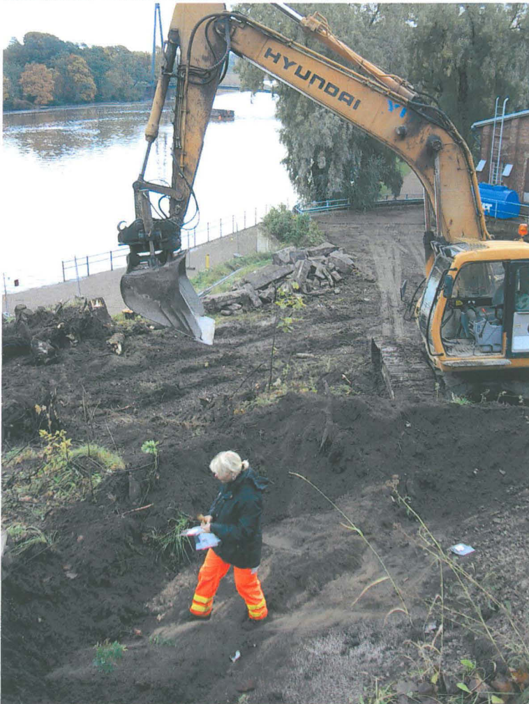
Kuva 34. Maaperän saastuneisuutta mitataan valvonta-alueen puisto-osalla kaavinnan lomassa. Kuva luoteesta. 8.10.2004.
