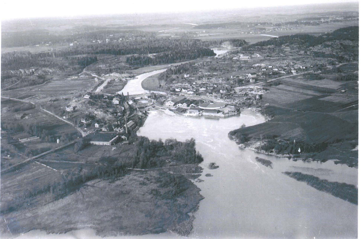
Vanhakaupunki ilmeisesti hiukan myöhemmin kuin edellinen kuva, sillä Imatran Voiman muuntamon rakennustyömaa näkyy selvästi. Kuva etelästä. HKM.
