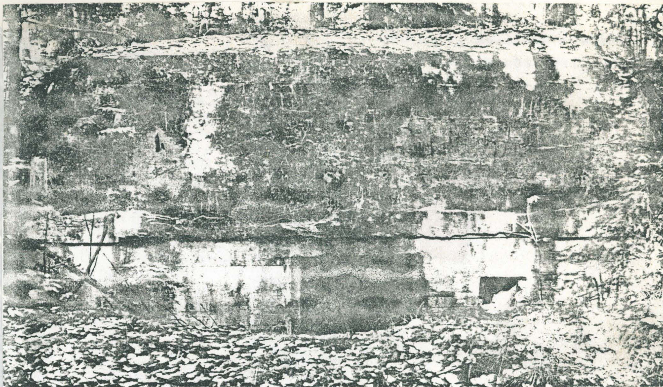
KUVA 16. Ehjä suojahuone patterissa 87.
