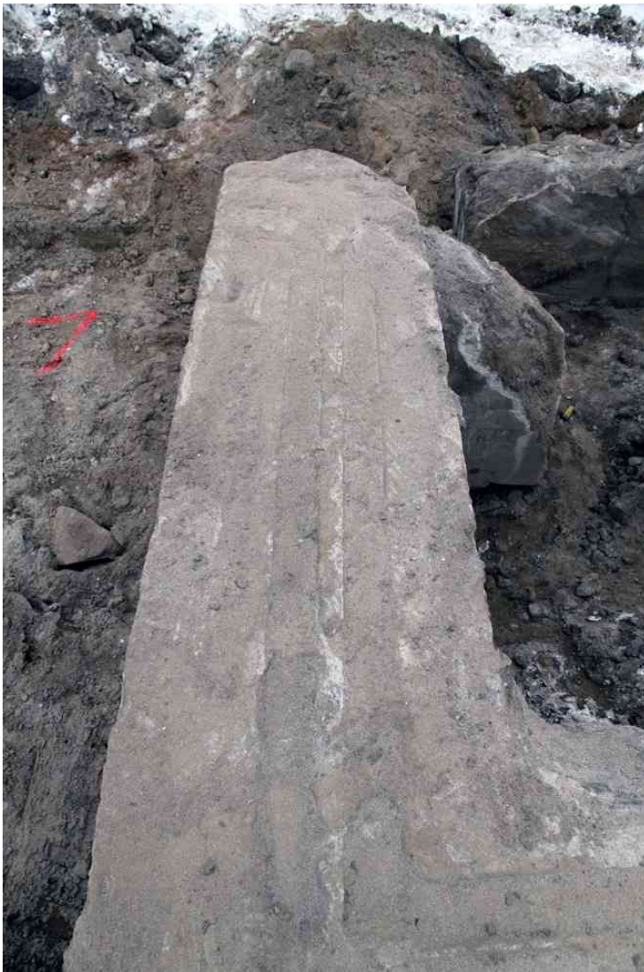
Kuva 109. Suojahuone. Suojahuoneen itäseinän yläpinta ilmeisesti ratakiskojen painautumiseen. 9.12.2010. Kuvaussuunta S.
