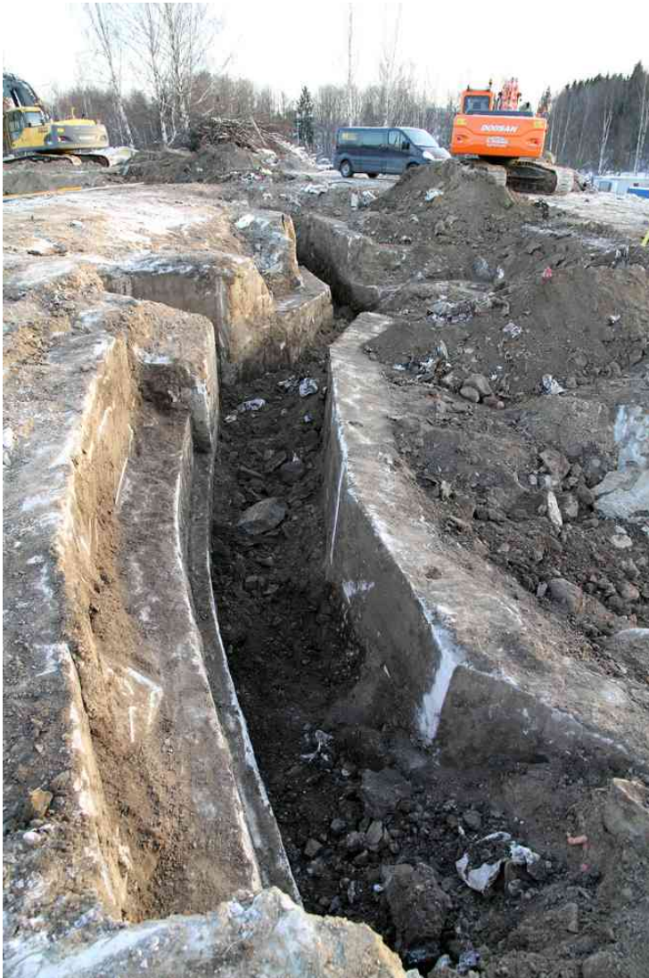
Kuva 33. Luoteinen asemanosa. Luoteisen asemanosan kalliota louhittu betonilla vahvistettu taisteluhauta. Torjuntasuunnan seinä ampumakorokkeineen ja porraskelmineen tukeutuu kokonaisuudessaan kalliota, mutta haudan taustaseinän kohdalla kalliota yläpinta on laskeutunut voimakkaasti. 26.10.2010. Kuvaussuunta SE.
