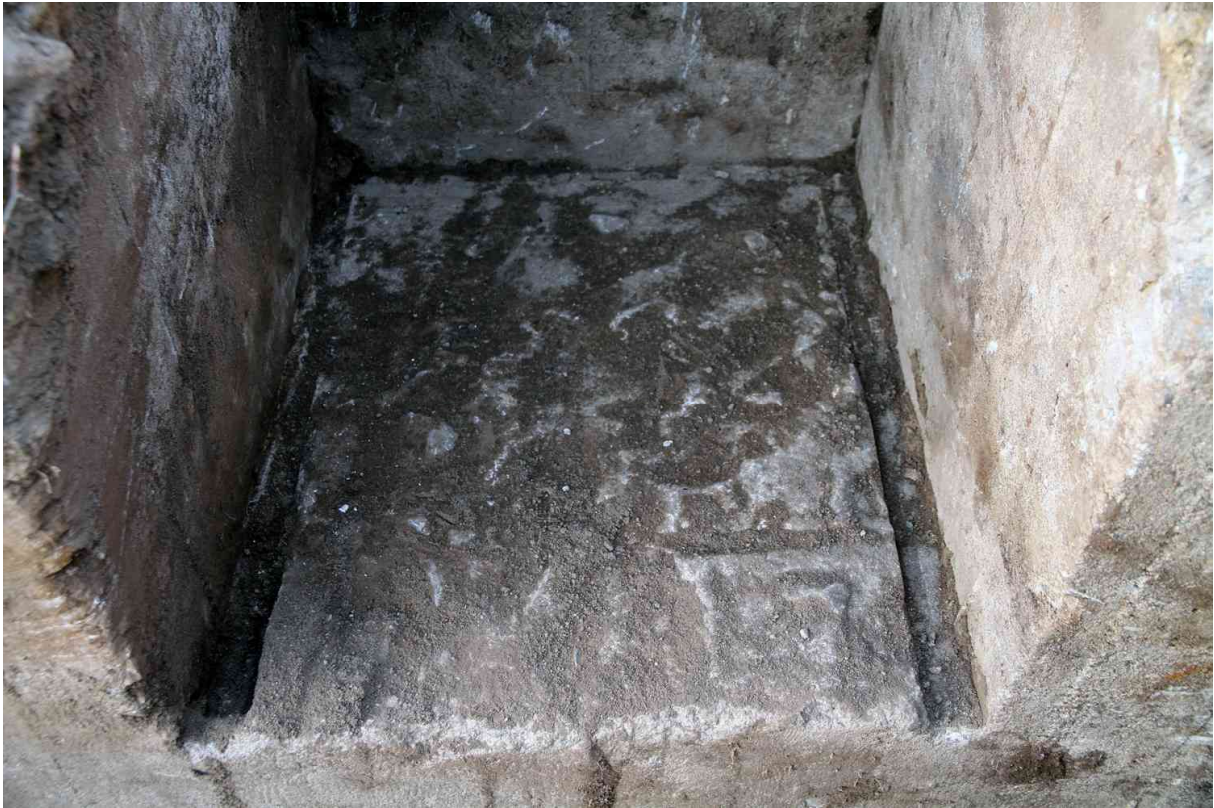
Kuva 44. Luoteinen asemanosa. Lähikuva komeron alaosasta. Pohjan urat on komeron vuoraukseen/valuun käytetyistä laudoista peräisin. 26.11.2010. Kuvaussuunta NW.
