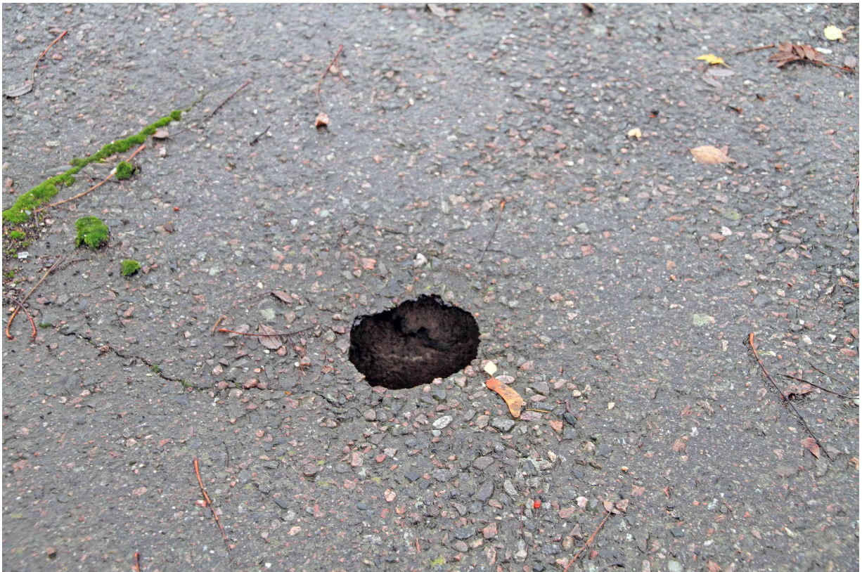
Kuva 21. Tukikohta IX, asema 7. Pihan kaakkoisnurkassa asvaltilla pilkisti suojuhuoneen betoninen yläpinta. 4.11.2010.
