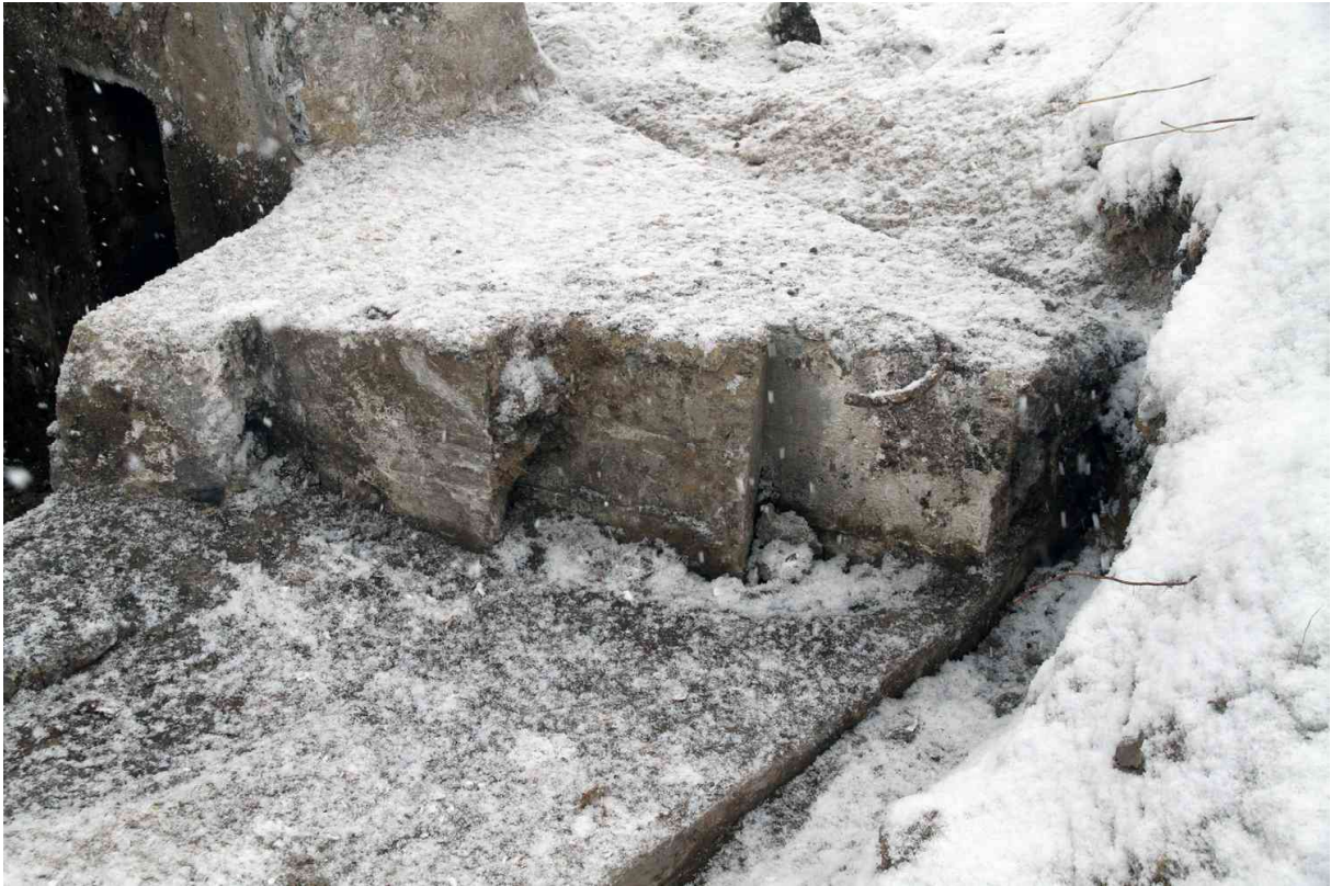
Kuva 82. Lounainen asemanosa. Ampuma-aukon eteläinen sahalaitainen pieli. 3.12.2010. Kuvaussuunta S.
