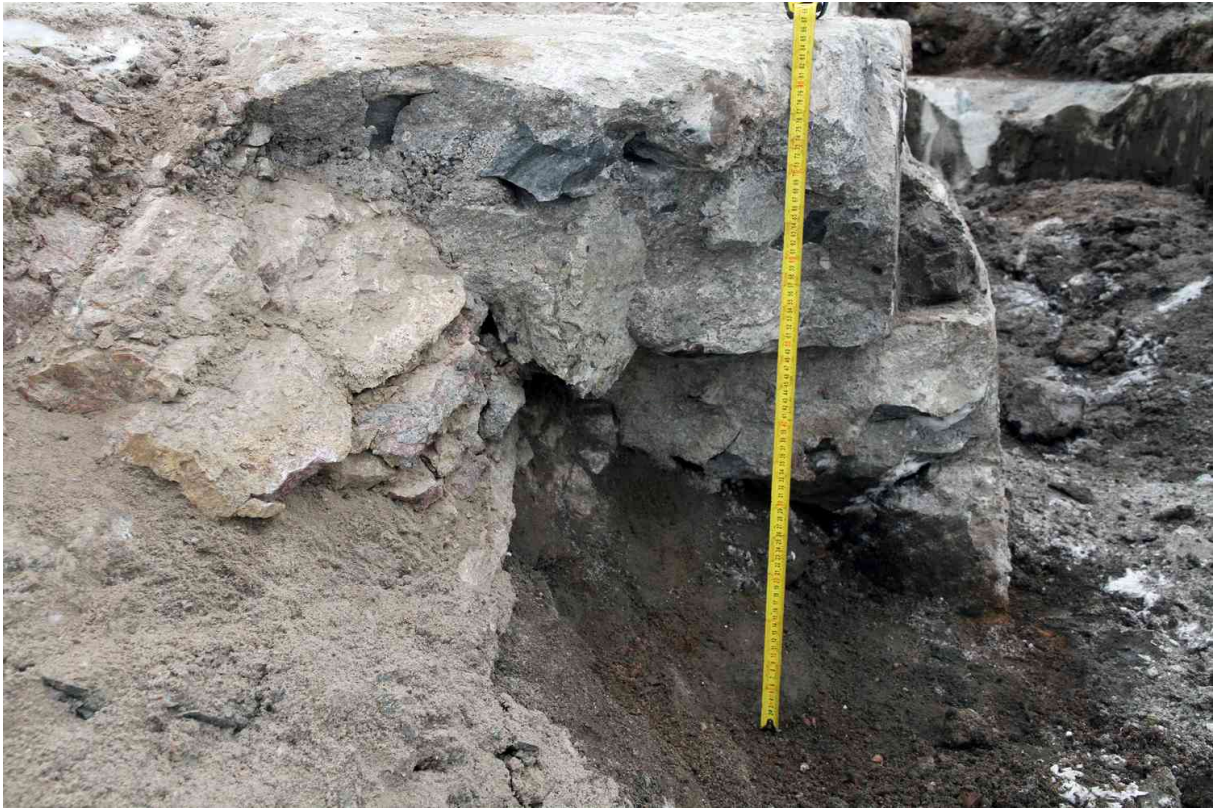
Kuva 118. Itäinen asemanosa. Lähikuva edellisestä. Betonikivirakenne tukeutuu kallioon. 9.2.2010. Kuvaussuunta SE.
