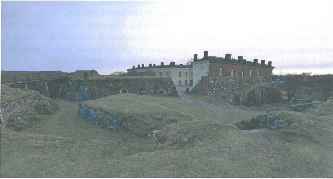
Von Spångenin varustusta. Kuvattu kaakosta. (AKDG3646:4)
