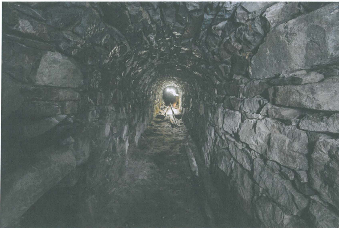
Maanalainen tunneli, jota käytettiin vedenpoistoon telakka-altaasta. (AKDG3646:8)
