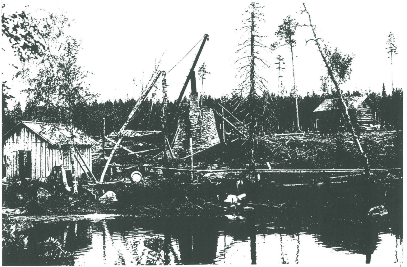
TERVATEHDAS TOIMINNASSA 1930-LUVULLA. LUONNONKIVESTÄ LADOTTU TÄRPÄTTITISLAAMO JÄÄ KUVAN ULKOPUOLELLE OIKEALLE.
