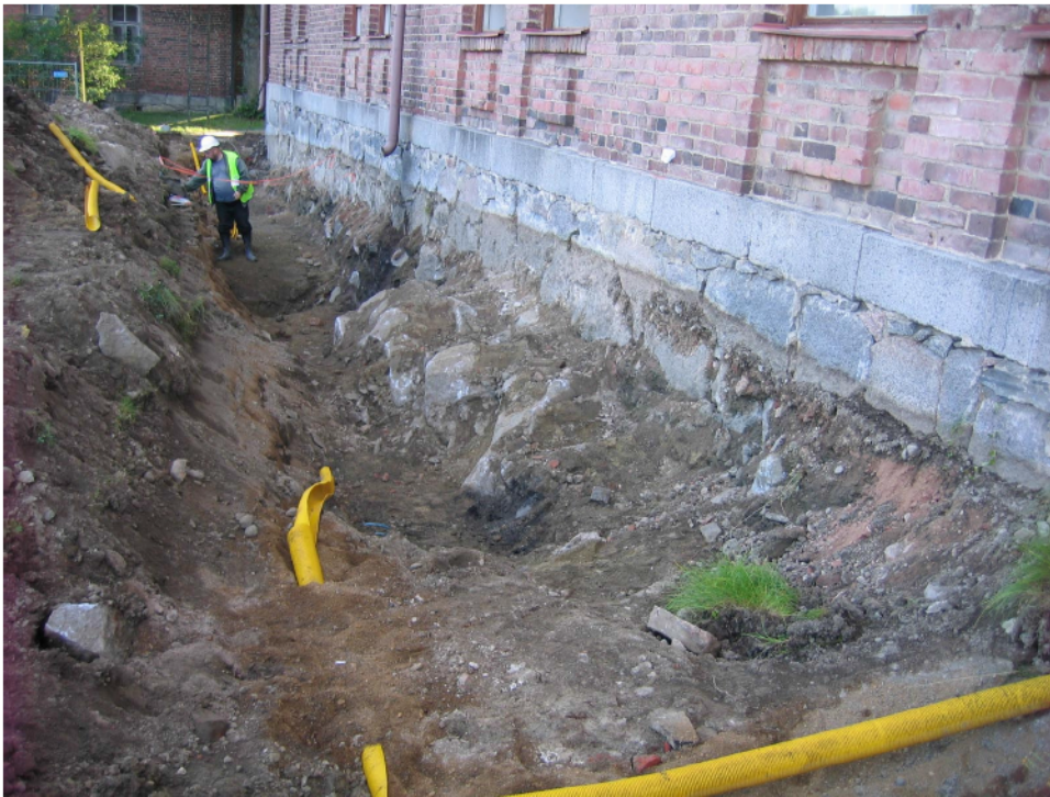
Kuva 7. K3a. Länsisivulla perustusten alla olevaa kalliota.
