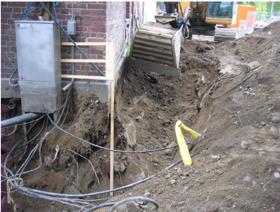
Kuva 1. Kaivannon K1e alkupään kaapelisuma.
