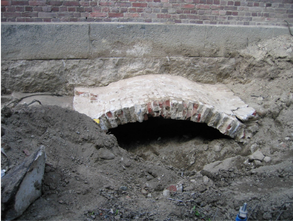
Kuva 4. Kellarin holvi esiin puhdistettuna.
