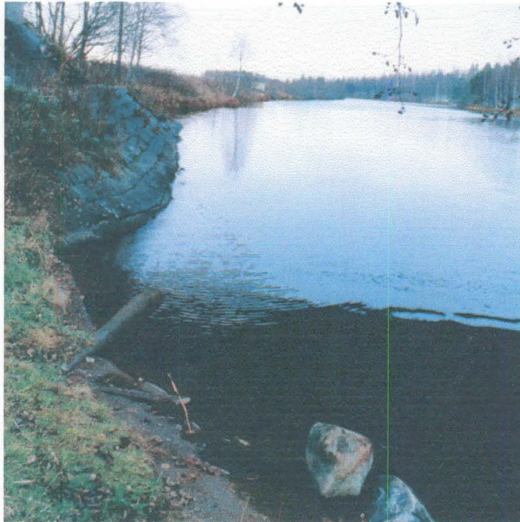
Kuva 4. Hirsiparru, joka liittyyne 1800-luvulla rakennettuun hirsiaarkkusiltaan. Hirsi on nykyisen sillan alla.
