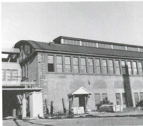
Karihaaran sahasalia on kuvan esittämästä alkuperäistilanteesta huomattavasti muutettu. Katon betonikaaret ovat ennallaan. MV/KKA.
