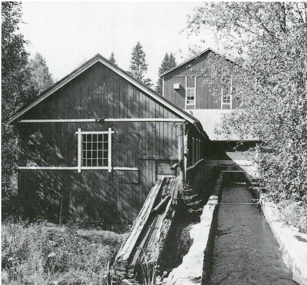
Palsan vesimylly jatkaa vuosisataista myllyperinnettä Päijät-Hämeessä. Myllyyn liittyy yksikehäinen saha, jonka pääty näkyy kivisen voimakanavan vieressä. Valok. Timo Kantonen 1994. MV/RHO.
