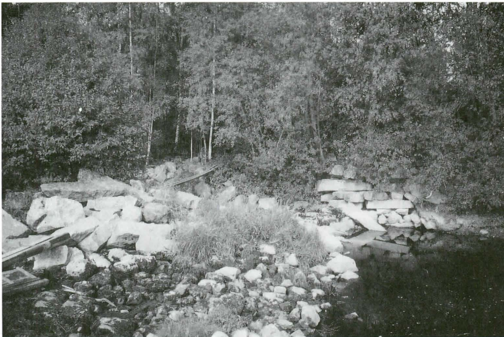
Vesisahan, myllyn ja voimakanavien kivrakenteita Kolkkilan koskessa. Valok. Timo Kantonen 1994.
