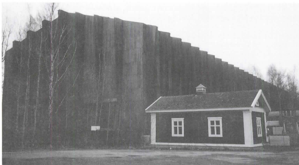
Arkkitehti Alvar Aallon suunnittelema kooltaan ja konstruktioltaan vaikuttava sahatavaran varasto on modernin saha-arkkitehtuurin helmi. Valok. Timo Kantonen 1994. MV/RHO.
