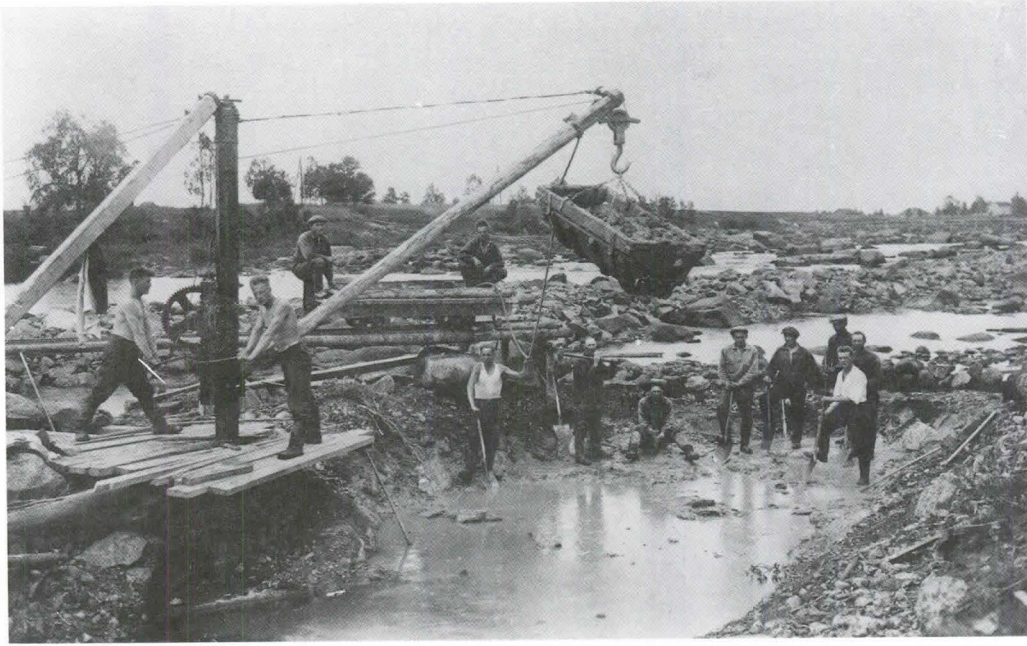
Historiallisia työkuvia Tyngän myllyn kokoel- mista: voimakanavaa kaivetaan vuonna 1916 ja ensimmäistä sahan raamia asennetaan paikalleen.
