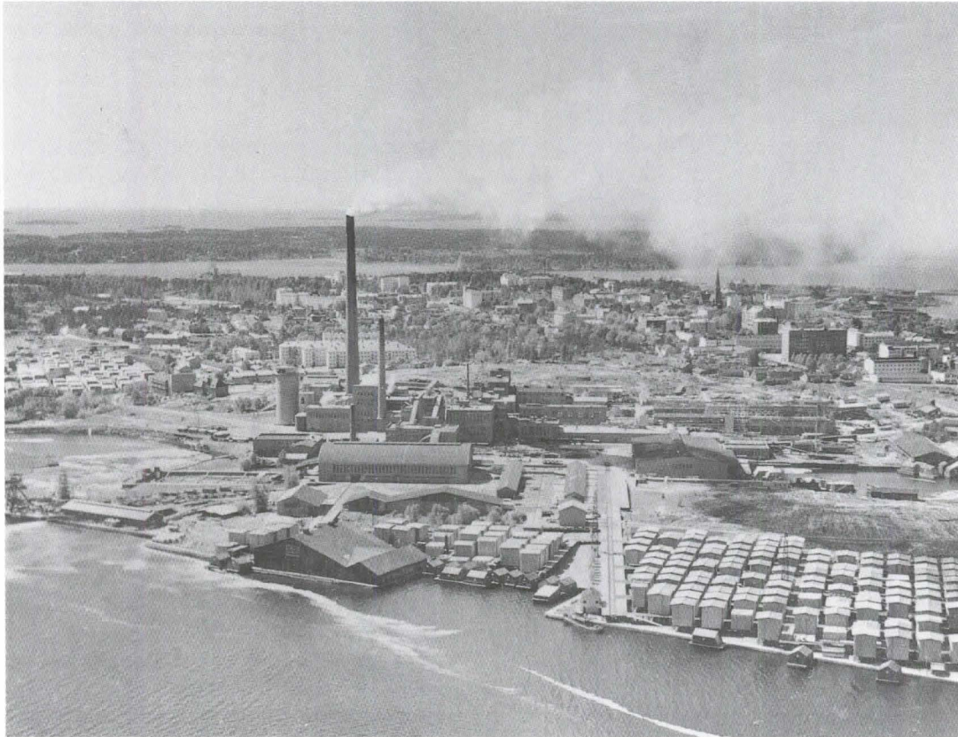
Enso-Gutzeitin tehasalue Kotkansaarella 1960-luvulla. Rantakaistalle levittäytyvää Norjan sahan tuotantoaluetta hallitsivat vielä tuolloin lautatarhat. Nykyisin sahatavara kuivataan yksinomaan keinokuivaamoissa. MV/KKA.
