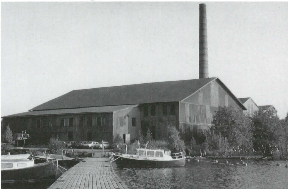
Reposaaren vuonna 1901 valmistunut sahalaitos on maamme vanhin suursahan saharakennus. Arvokkaaseen rakennusryhmään kuuluu sahan rinnalla voima-asema ja savupiippu. Valok. Erkki Härö 1993.
