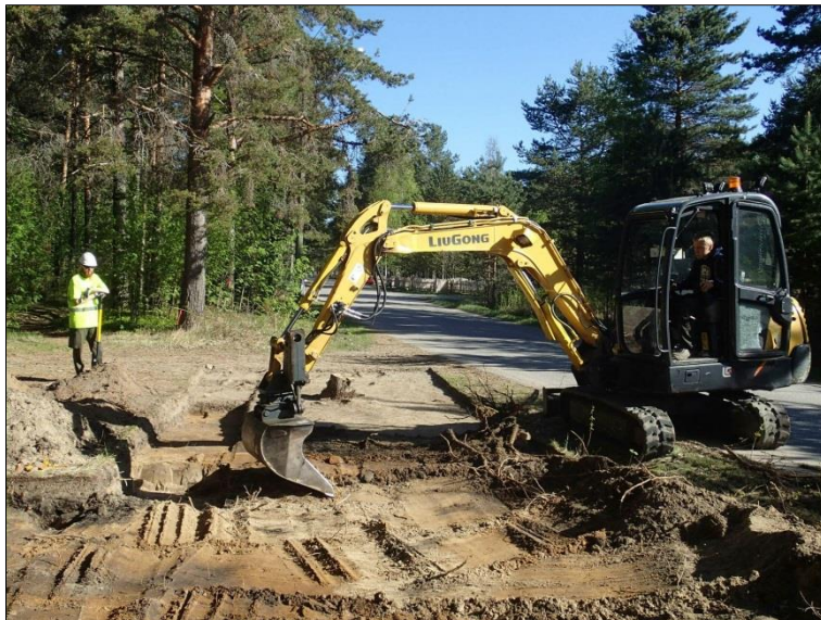
Kaivausalueen pintamaita poistetaan koneellisesti.
