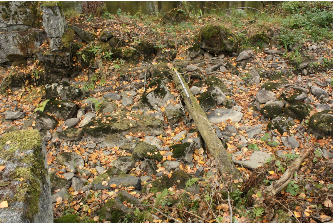
Kuva 6. Sastamala Honkasen mylly. Ruuhen ja sen edessä olleen "häkin" tukihirsiä sekä kiveyksiä myllyuoman päässä, myllyn koillisseinustalla. Kohti luodetta. 24.9.2013. Kerkko Nordqvist.
