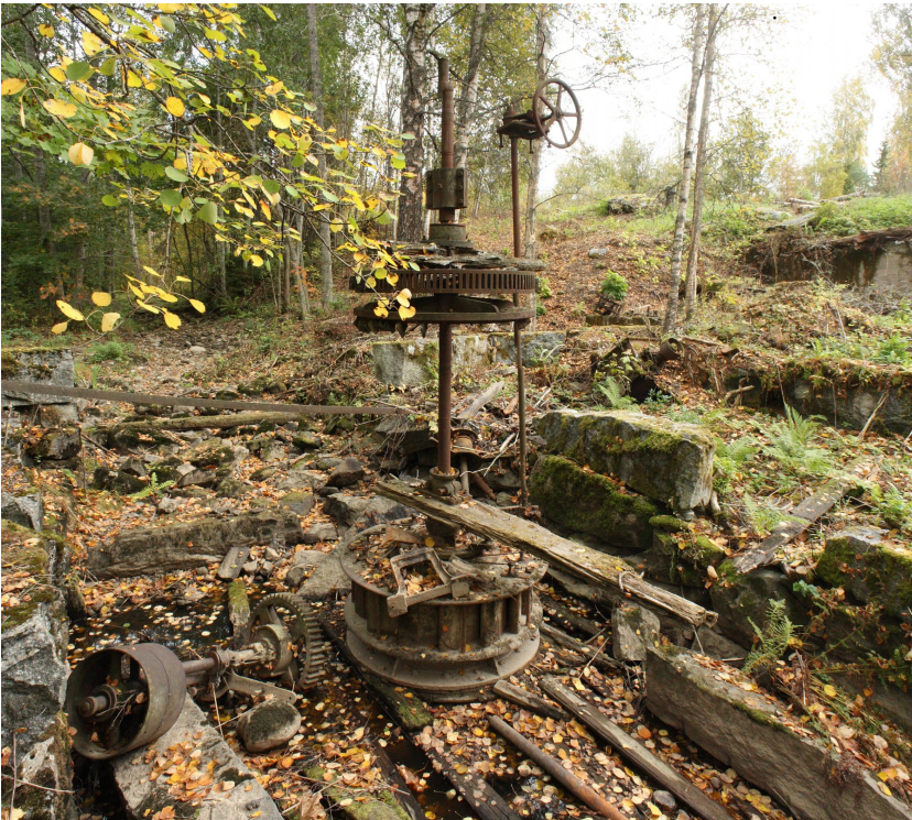
Kuva 5. Sastamala Honkasen mylly. Turbiinimontussa seisova vesiturbiini akseleineen ja muita uomassa lojuvia voimansiirtokoneiston osia maapadon päältä kuvattuna. Kohti itää. 24.9.2013. Kerkko Nordqvist.
