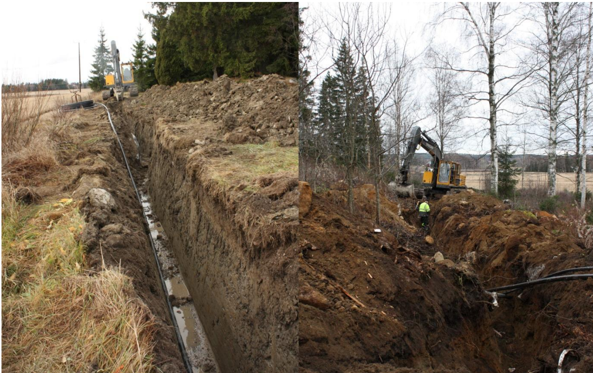
Kuva 2. Vasemmalla tyhjää putkikaivantoa savisessa pellossa mäen lounaispuolella ja oikealla Tikkalan talon lounaispuolen koivikossa, länsipuolelta. Kohti luodetta ja lounasta 29.10.2013 ja 31.10.2013. S. Sandell.
