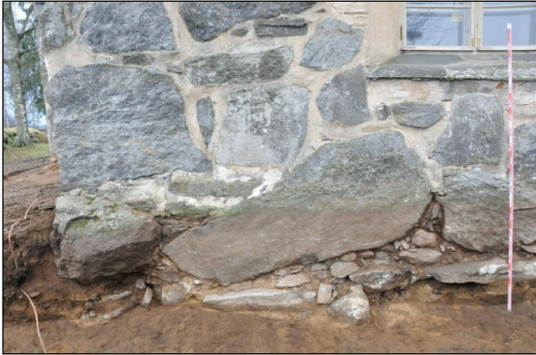
Sakastin pohjoisseinä alaosa esille puhdistettuna – itäpuolisko. Pohjoisluoteesta.
