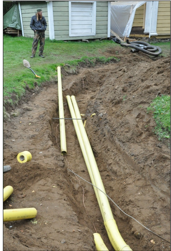
Viemärikaivanto asehuoneen lounaispuolella suurimpaan syvyyteensä kaivettuna. Oikeassa yläkulmassa kellotapuli. Idästä.
