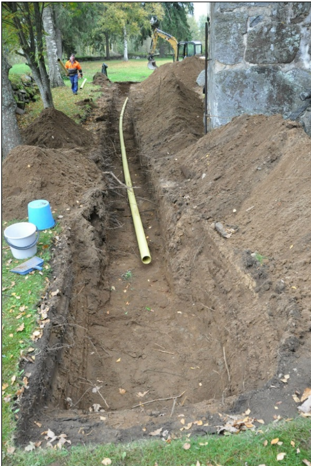
Kirkon itäpuolen pohjoinen–etelä-suuntainen viemäriöja suurimpaan syvyyteensä kaivettuna. Pohjoisesta.
