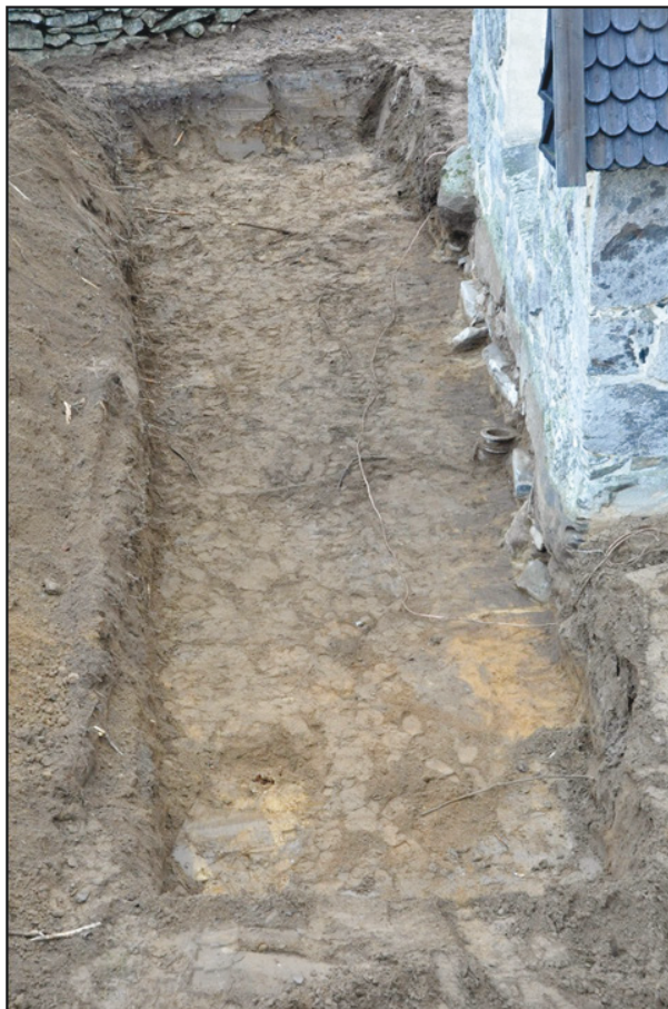
Sakastin pohjoispuolen bentoniittimattoalue suurimmassa syvyydessään. Alhaalla vasemmalla vaaleammassa maassa paikalleen jätetty hautaus. Länneestä.
