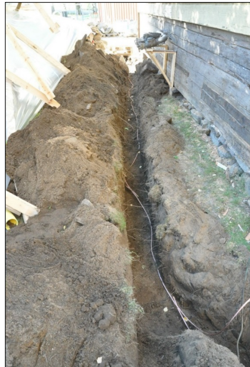
Tapulin kaakkoispuolen sähkökaapelioja suurimmassa syvyydessään – koillisosa. Etelästä.
