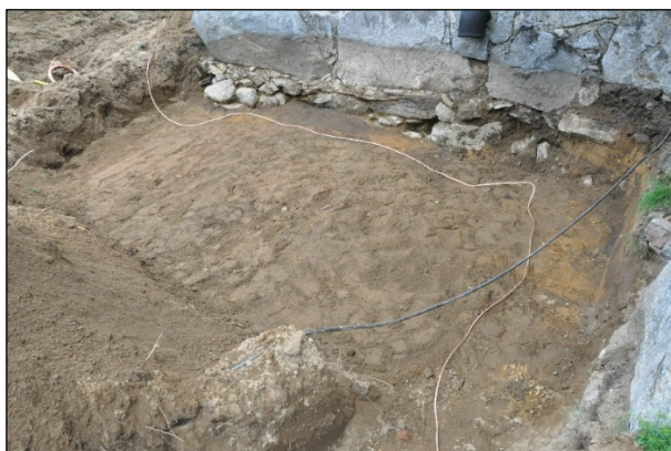
Asehuoneen länsipuolen bentoniittimattoalue lopulliseen syvyyteensä kaivettuna. Itäkaakosta.
