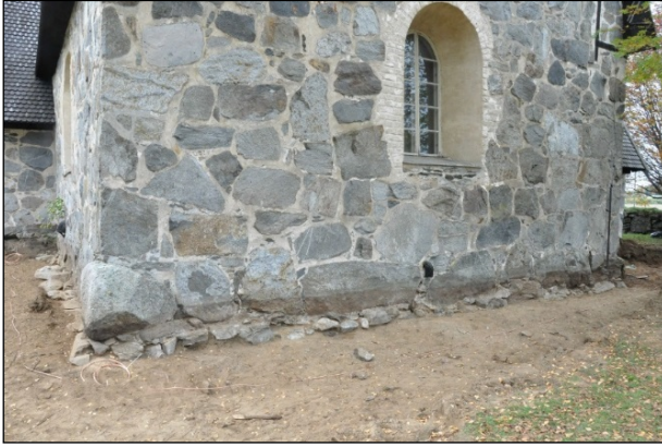
Yleiskuva runkokuoneen itäpäädystä seinän alaosan esille puhdistamisen jälkeen. Itäkaakosta.
