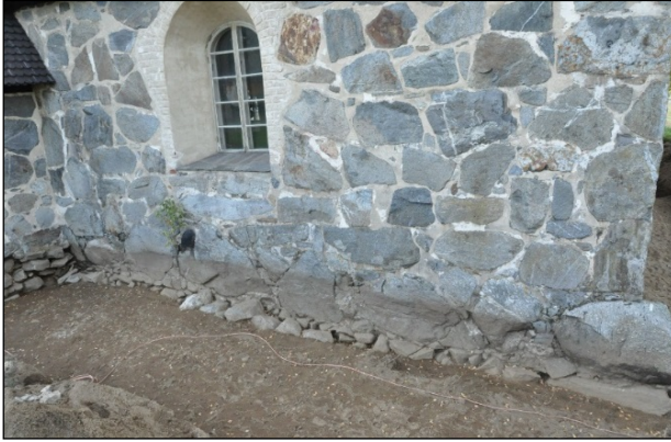
Runkohuoneen eteläseinän alaosa asehuoneen itäpuolella esille puhdistettuna. Itäkaakosta.
