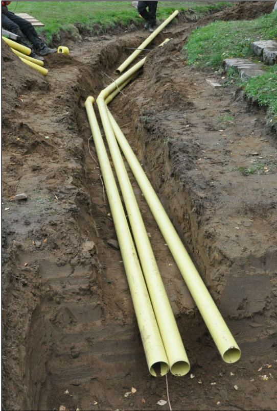
Viemärikaivanto asehuoneen eteläpuolella suurimpaan syvyyteensä kaivettuna. Etualalla sadevesikaivon kuoppa asehuoneen kaakkoiskulman kohdalla. Itäkoillisesta.
