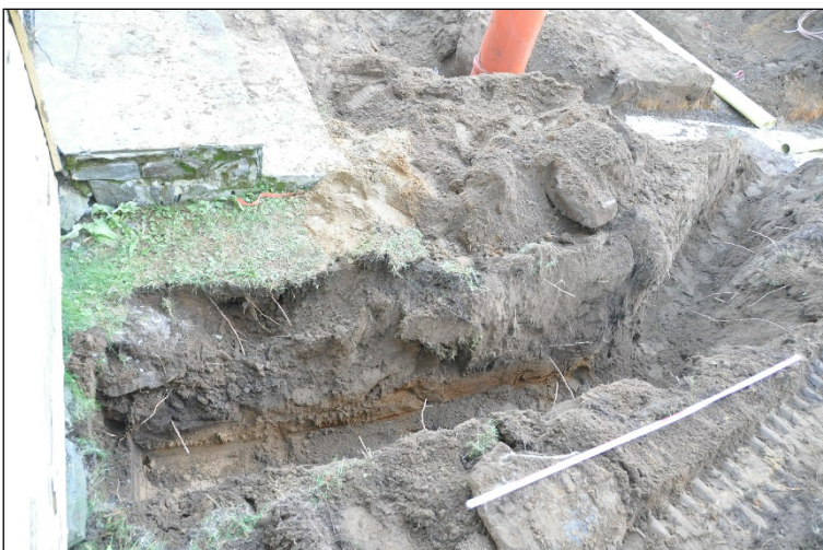
Haudan 13 luota kohti läpikäytävää kaivettu sähkökaapeli suurimmassa syvyydessään. Luoteesta.
