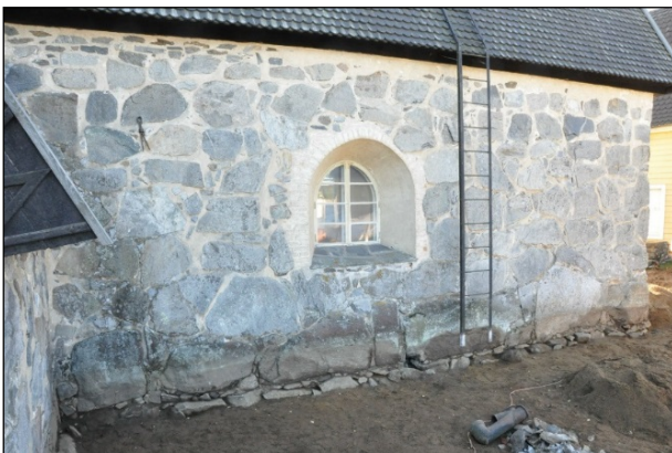
Runkohuoneen pohjoisseinä sakastin länsipuolella seinän alaosa esille puhdistettuna. Pohjoisesta.
