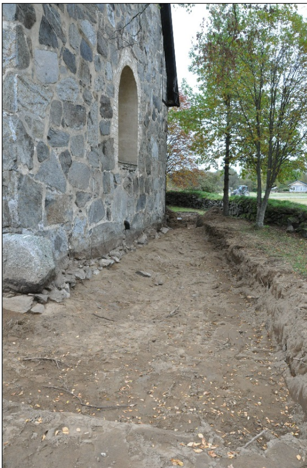
Kirkon itäpäädyn bentoniittimattoalue lopulliseen syvyyteensä kaivettuna. Kaakosta.
