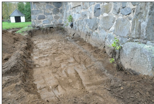
Kirkon eteläpuolen ja asehuoneen itäpuolen bentoniittimaton alue lopullisessa syvyydessään. Itäkoillisesta.
