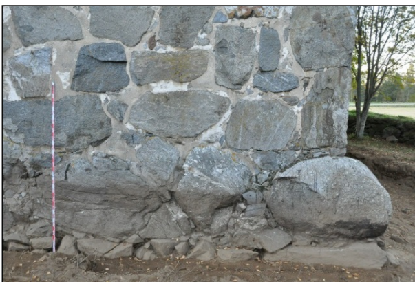
Runkohuoneen eteläseinän alaosa asehuoneen itäpuolella esille puhdistettuna – itäisin kolmannes. Eteläkaakosta.
