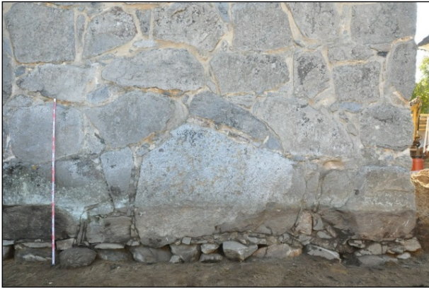
Runkohuoneen pohjoisseinä sakastin länsipuolella alaosa esille puhdistettuna – läntinen kolmannes. Pohjoisluoteesta.
