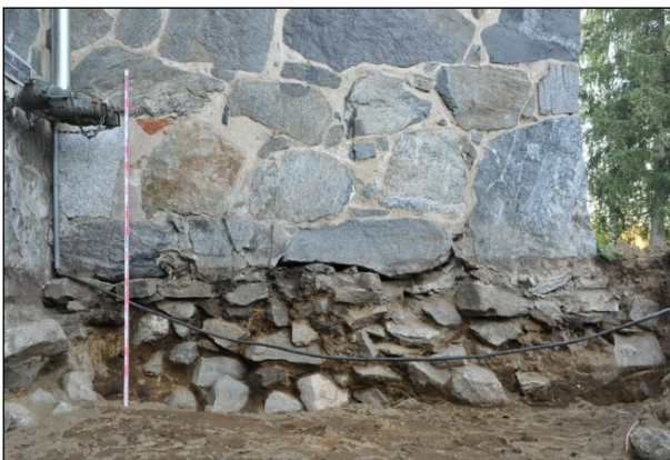
Asehuoneen länsiseinän alaosa esille puhdistettuna. Länsilounaasta.
