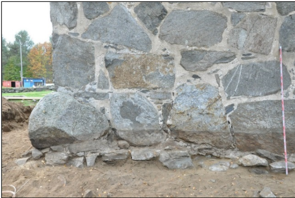
Runkokuoneen itäpäättyä seinän alaosan puhdistamisen jälkeen – eteläisin kolmannes. Itäkoillisesta.
