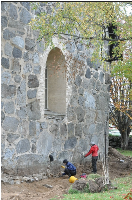
Työkuva. Runkohuoneen itäpäädyn seinän alaosaa puhdistetaan dokumentointia varten.
