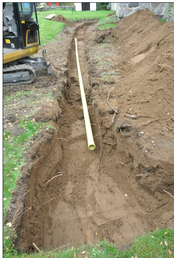
Kirkon eteläpuolen itä–länsi-suuntainen viemärioja suurimmassa syvyydessään. Idästä.
