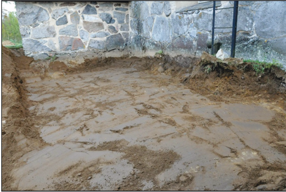
Runkohuoneen pohjoispuolen ja sakastin länsipuolen bentoniittimattoa varten kaivettu alue suurimmassa syvyydessään – itäosa. Lännestä.
