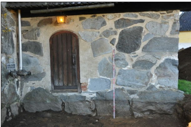
Sakastin itäseinän alaosa esille puhdistettuna. Itäkoillisesta.
