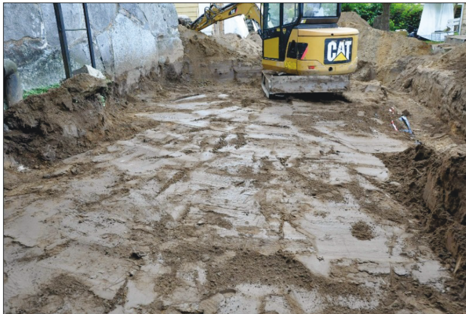
Runkohuoneen pohjoispuolen ja sakastin länsipuolen bentoniittimattoa varten kaivettu alue suurimmassa syvyydessään – länsiosa. Koilli-
