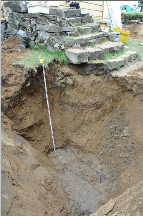
Kirkon ja kellotapulin väliin sadevesikaivoa varten tehty kaivanto ja arkunjäännös sen pohjalla. Takana kellotapulin portaita. Kaakosta.
