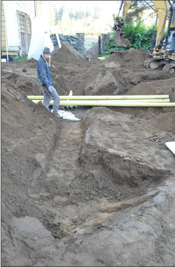
Tapulin pohjoispuolella olevan kirkkoaidan portin suunnasta kohti kirkon luoteisnurkkaa kaivettu sähkökaapeli
