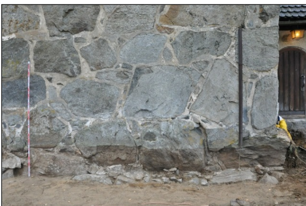
Runkokuoneen itäpäättyä seinän alaosan puhdistamisen jälkeen – pohjoisin kolmannes. Itäkoillisesta.
