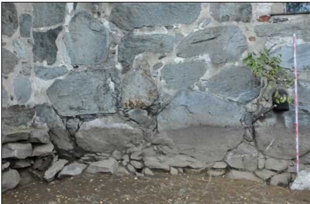
Runkohuoneen eteläseinän alaosa asehuoneen itäpuolella esille puhdistettuna – läntisin kolmannes. Eteläkaakosta.
