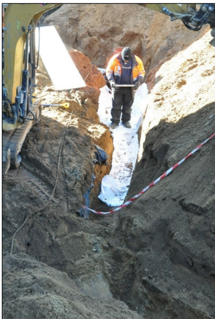
Runkokuoneen pohjoispuolen viemärikaivannon itä–länsi-suuntainen osa lopullisessa syvyydessään. Itäkoillis-
