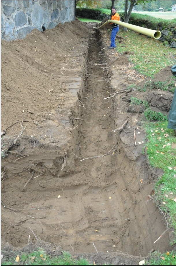
Kirkon itäpuolen pohjoinen–etelä-suuntainen viemäriöja suurimpaan syvyyteensä kaivettuna. Etelästä.
