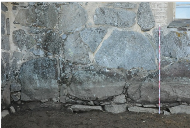
Runkohuoneen pohjoisseinä sakastin länsipuolella alaosa esille puhdistettuna – itäinen kolmannes. Pohjoisluoteesta.
