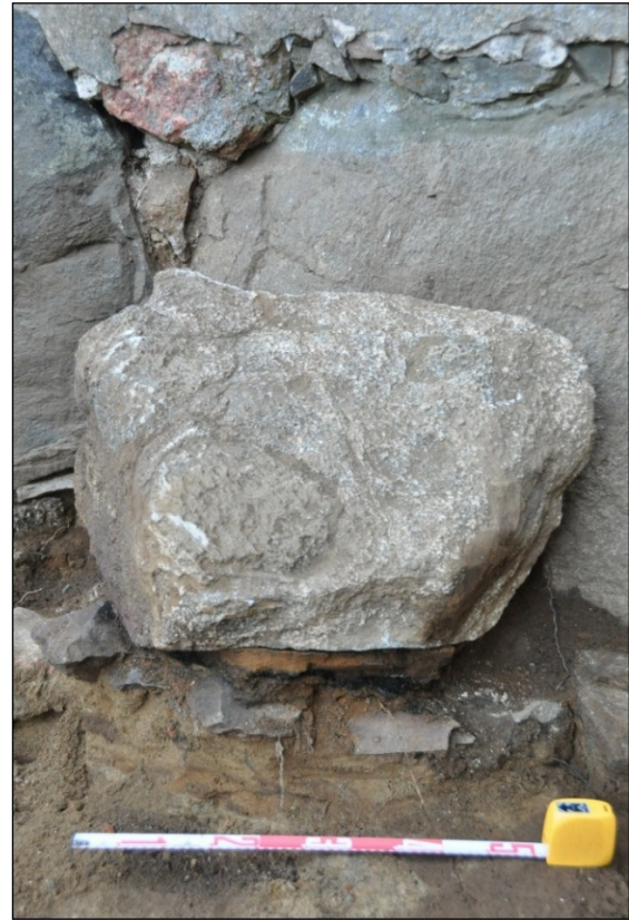
Hiilikerros irtokiven alla sakastin länsiseinän pohjoispäässä. Länneestä.
