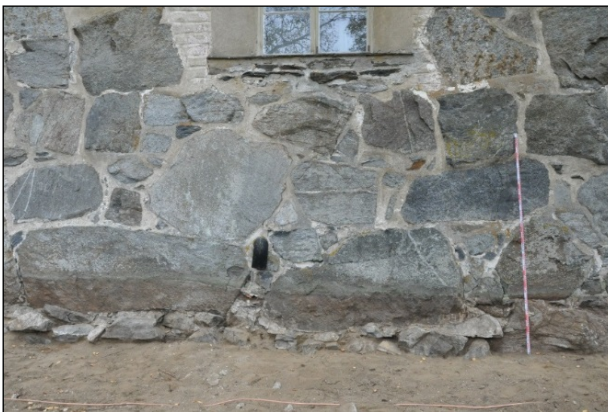
Runkokuoneen itäpäättyä seinän alaosan puhdistamisen jälkeen – keskimäinen kolmannes. Itäkoillisesta.
