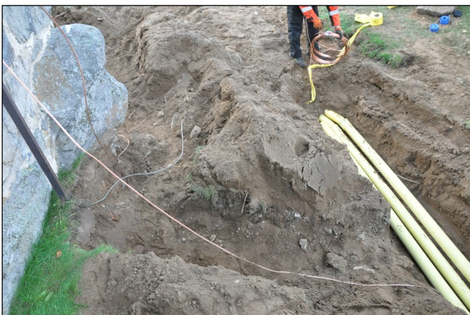
Runkohuoneen lounaisnurkan kohdalle avattu L-kirjaimen muotoinen kaapelikaivanto lopullisessa syvyydessään. Pohjoisluoteesta.
