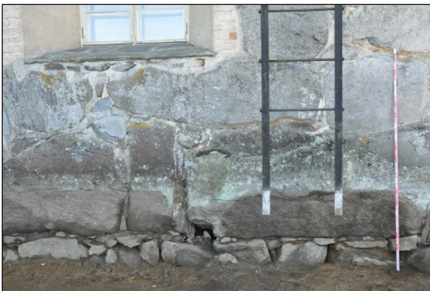
Runkohuoneen pohjoisseinä sakastin länsipuolella alaosa esille puhdistettuna – keskimmäinen kolmannes. Pohjois-
