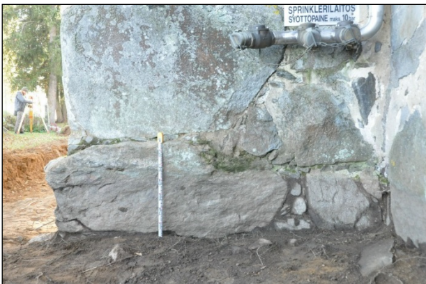
Runkokuoneen pohjoisseinän alaosa sakastin itäpuolelta esille puhdistettuna. Pohjoisluoteesta.
