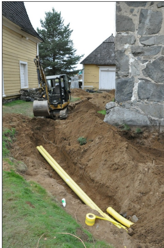
Sadevesiviemärin kaivanto runkokuoneen lounaisnurkan kohdalla suurimpaan syvyyteensä kaivettuna. Kaakosta.
