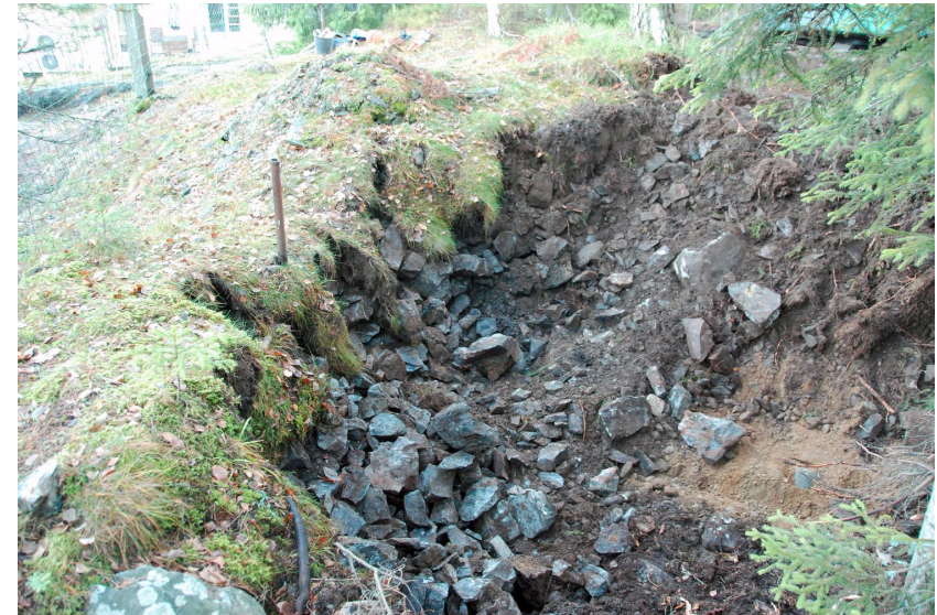
Kuva 23. Kaivos 4. Edellinen tilanne. Taustalla länsivallin päällä näkyy pieni louhintakivikasa. Kuvaussuunta N. 11.11.2013.
