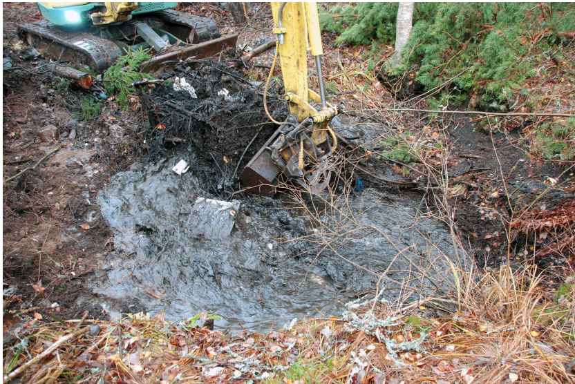
Kuva 37. Kaivos 6. Kaivosta tyhjennetään. Kuvaussuunta N. 5.11.2013.
