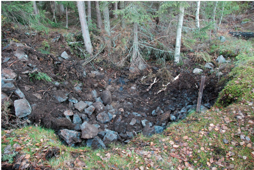
Kuva 22. Kaivos 4. Keskiosan kiviä poistetaan. Kyseessä ei ollut kaivos vaan korkeiden louhoskivivallien keskellä oli lisää louhoskiveä alkuperäisen maanpinnan ja hiekkakerrosten päällä. Kuvaussuunta SE. 11.11.2013.
