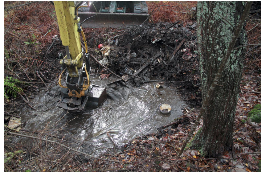
Kuva 49. Kaivos 7. Kaivosta on alettu tyhjentämään. Kuvaussuunta N. 4.11.2013.
