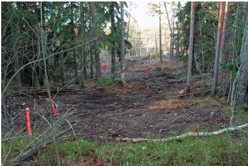
Kuva 90. Kaivokset 9 ja 8. Tilanne kaivosten täyttämisen jälkeen. Kuvaussuunta W. 11.11.2013.
