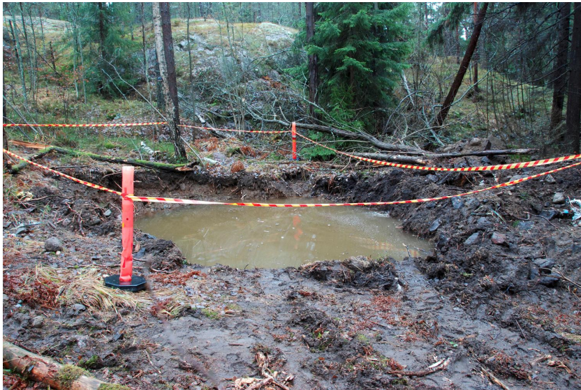
Kuva 78. Kaivos 9. Veden valtaama kaivos seuraavana päivänä. Kuvaussuunta ESE. 5.11.2013.
