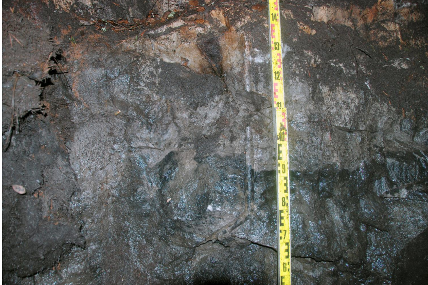
Kuva 46. Kaivos 6. Itäseinän poran jäljet. Kuvaussuunta E. 5.11.2013.
