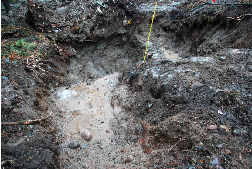
Kuva 64. Kaivos 8. Edellinen tilanne toisesta suunnasta kuvattuna. Kuvaussuunta SW. 5.11.2013.
