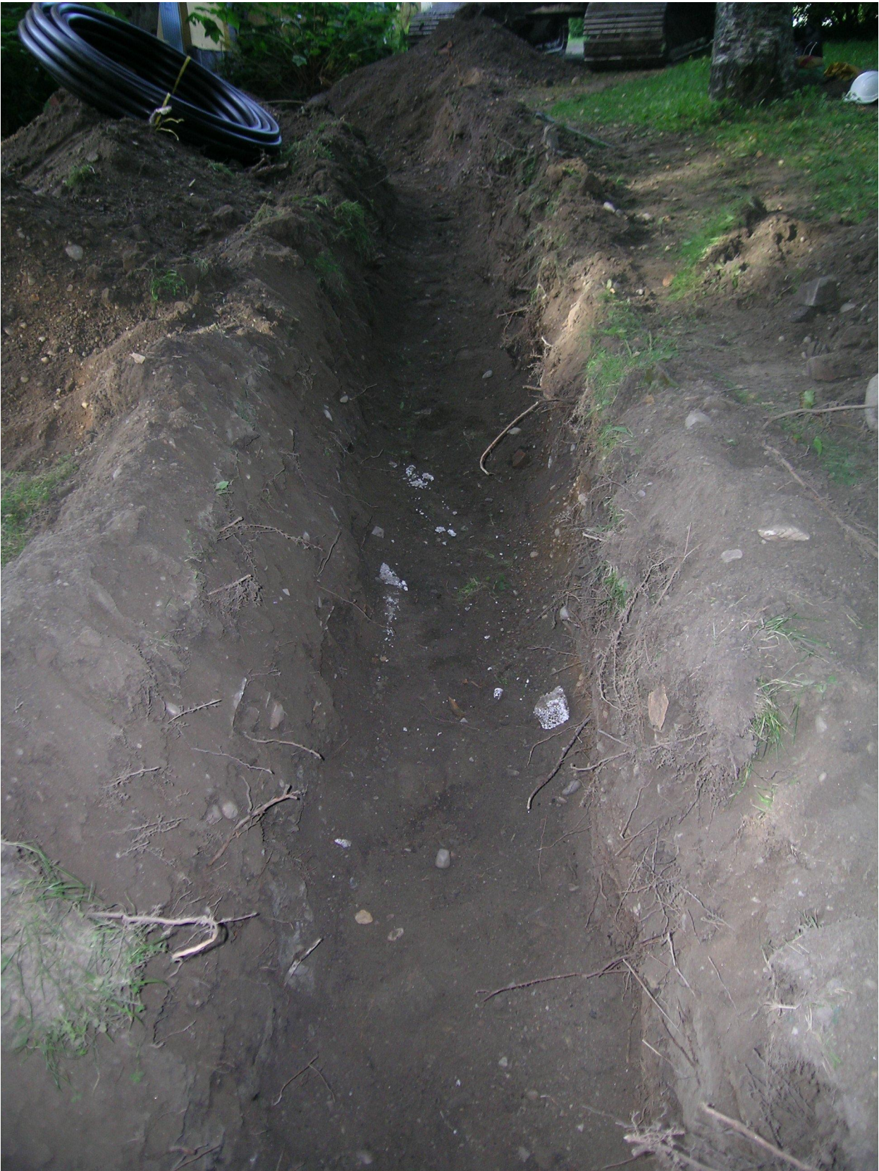
Kuva 3: Putkilinjakaivantoa ylärinteeseen ja länsilounaaseen päin nähtynä. Vasemmassa yläkulmassa näkyy pappilan arkistosiiven kivijalkaa ja keltaista seinää. Kuvassa näkyy routaeristeestä tms. peräisin olevaa styroksia. Kuvaaja: Sami Raninen. KYY 123: 5.
