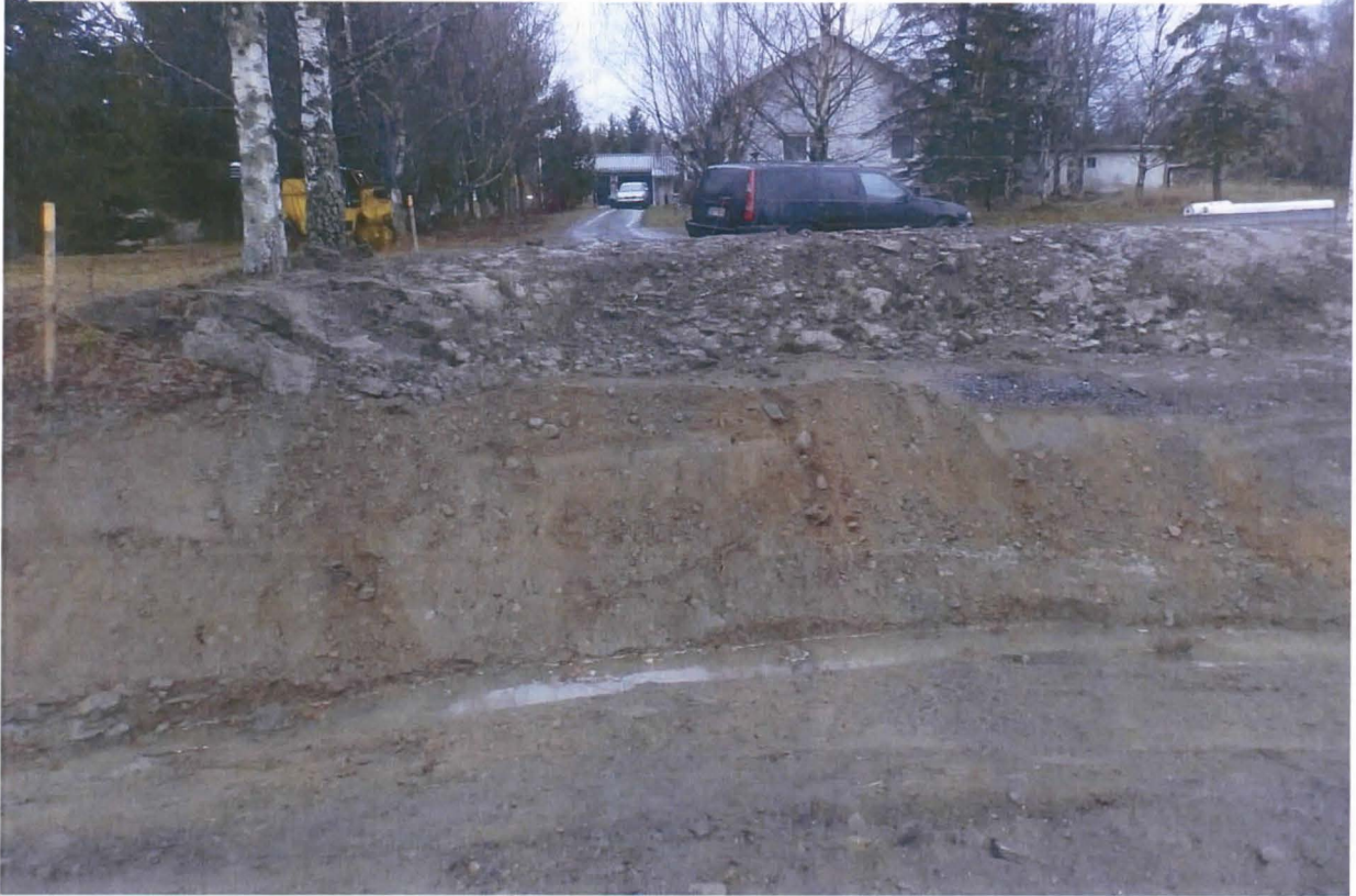
Kuva 5. Vanha tieliittymä katkaistuna ja avo-ojaksi muutettuna. Tien alle ajettu hiekkaa, jonka alla on luontainen savi. Kuvaussuunta itään. Kuva: Ulla Moilanen/Pirkanmaan maakuntamuseo (KYY130: 2)
