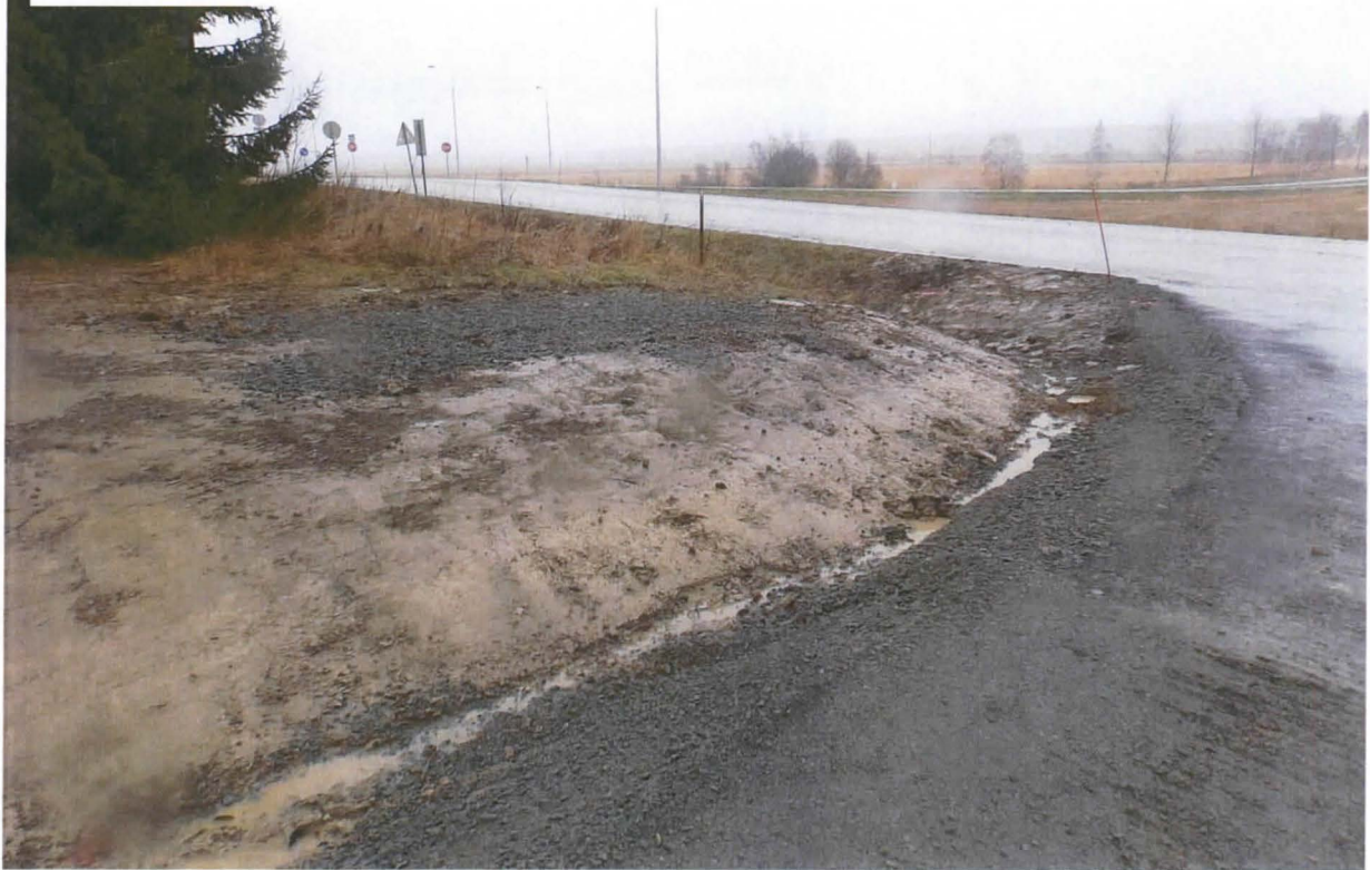
Kuva 7. Uuden tieliittymän pohjoispuolelle tasattua kaivannosta peräisin olevaa savea, sekä tien viereen kaivettu oja. Kuvaussuunta koilliseen. Kuva: Ulla Moilanen/Pirkanmaan maakuntamuseo (KYY130: 3)
