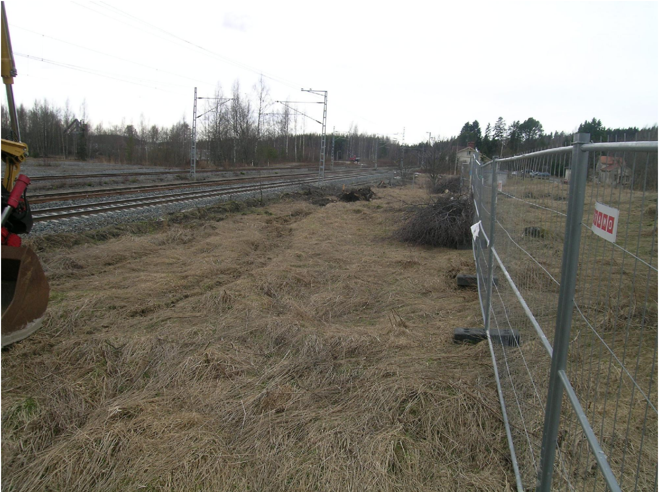
Kuva 1: Koillista tutkimusaluetta lounaaseen päin nähtynä. Koekuoppia kaivettiin alueelle, joka ulottui leveysuunnassa työmaa-aidan juurelta ratapenkkää reunustavan ojan reunaan asti. Taustalla erottuu Karkun asemarakennus (samalla linjalla työmaa-aidan kanssa). Kuvan oikealla puolella on kumpareella sijaitseva Sastamala Rautatiealue 2:n muinaisjäännösalue, joka jatkuu aidatulle laiturityömaa-alueelle kuvan keskivaiheilla näkyvän risukasan lounaispuolella. Kuvaaja: Sami Raninen. KYY 120: 1.
