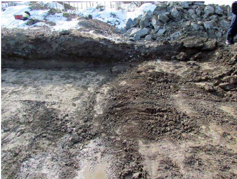
Kuva 13. Kuvan taka-alalla erottuu tielinjan länsipuolinen oja painaumanä. Kaivutasossa ojan kohdalla on tiilen ja kivensekainen ruskeaksi värjäytynyt maannos. kuvattu pohjoisesta. (Lempäälä Rikala 2013:5)
