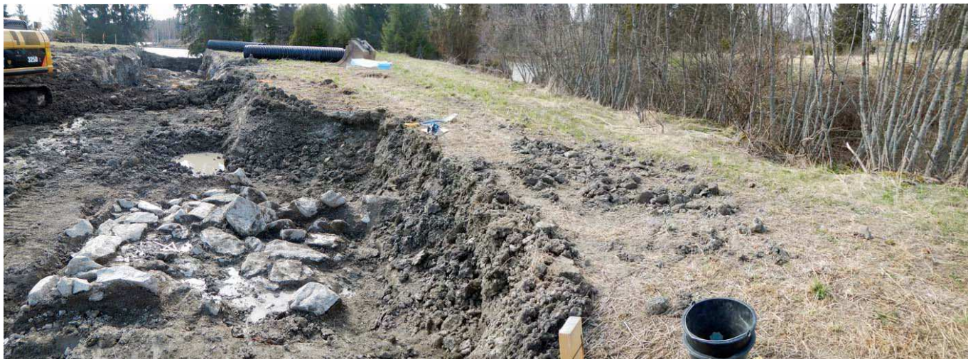
Kuva 14. Rakenteen A sijainti pusikoituneen kanavauoman eteläpuolella. Kuvattu idästä. (Lempäälä Rikala 2013: 10)
