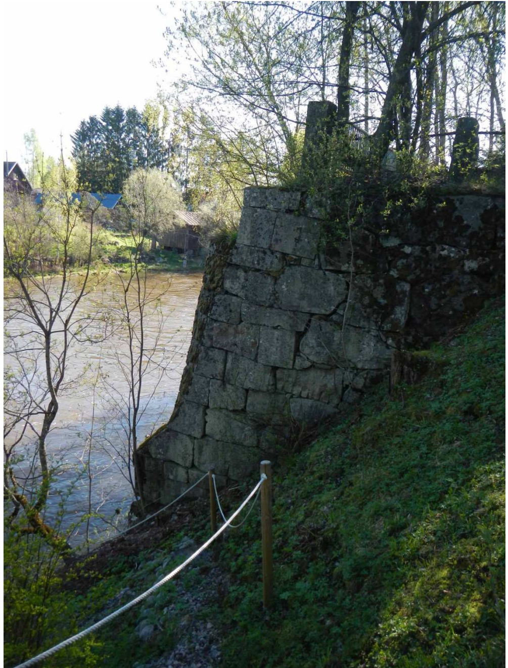
Kuva 14. Rakenne 24, 1850-60-luvulla rakennetun sillan siltaporras. Lempäälä, Kuokkalan Hakkarin Herralan osayleiskaavan laajennusalueen arkeologinen inventointi 2013:4.
