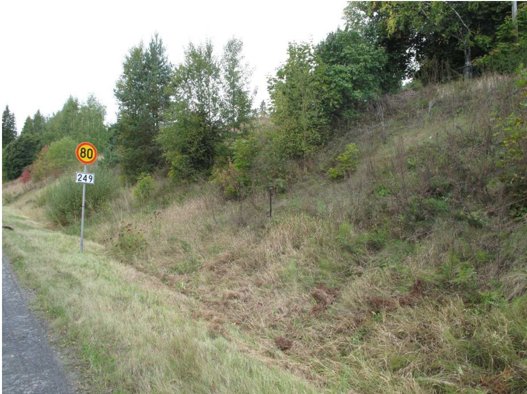
Kuva 6. Nuorempaa tieleikkausta Liuhalantien länsipuolella. Lapio osoittaa koepiston paikkaa. Idästä. (Sastamala Liuhalantie, maakaapelointityön arkeologinen valvonta 2013: 4)
