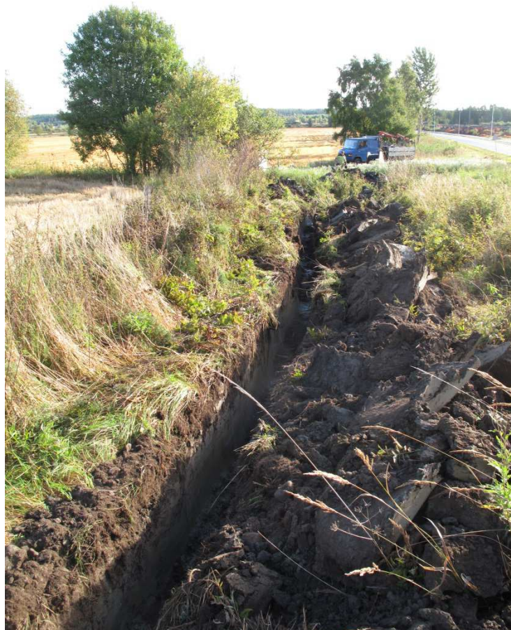
Kuva 3. Tutkittavan kaivannon itäosaa. Lännestä. (Sastamala Liuhalantie, maakaapelointityön arkeologinen valvonta 2013: 1)
