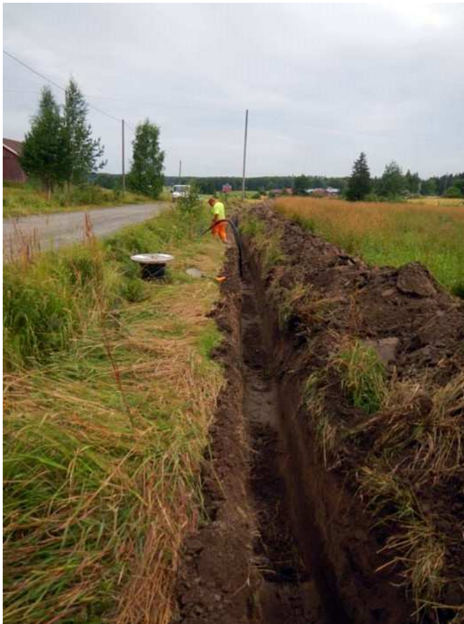
Kuva 10. Kaapelikaivantoa Järviän kylätontin luoteispuolisella pellolla. (Kuva: Sastamala, Vatajan ja Järviän (Isojärvi) historiallisten kylätonttien alueiden maakaapelointityön arkeologinen valvonta 2013: 7)
