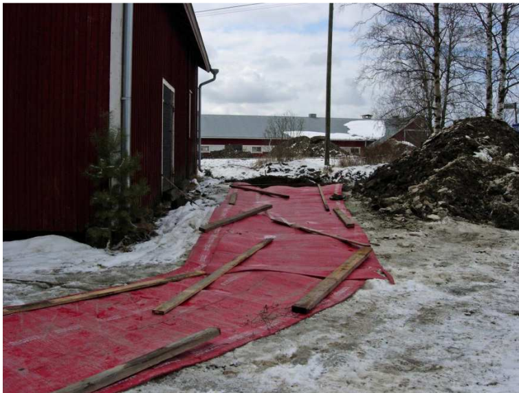
Kuva 4. Routamatto asennettuna Vatajan kylätontilla, Rekun vanhan päärakennuksen luoteispuolelle. (Kuva: Sastamala, Vatajan ja Järviän (Isojärvi) historiallisten kylätonttien alueiden maakaapelointityön arkeologinen valvonta 2013: 1)
