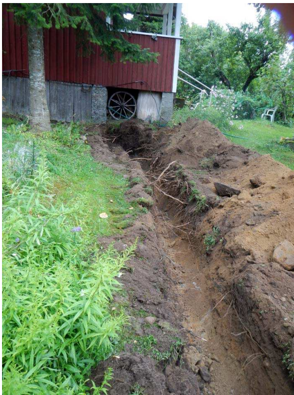
Kuva 12. Järviän kylätontin pohjoisimmalle, yksittäiselle talolle johtavan kaapelikaivannon pihamaalla kulkevaa osuutta. Pihalla oleva rakennuksen perustus jää kuvassa vasemmalla olevan pensaikon alle. (Kuva: Sastamala, Vatajan ja Järviän (Isojärvi) historiallisten kylätonttien alueiden maakaapelointityön arkeologinen valvonta 2013: 9)
