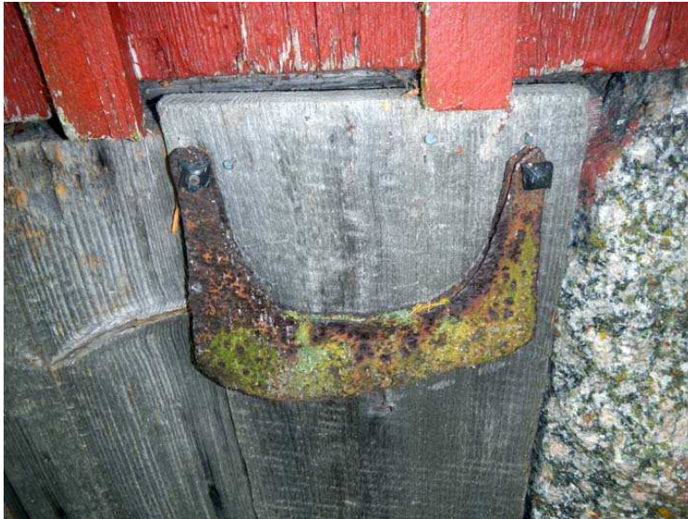
Kuva 13. Rautainen lapinkärki ruuvattuna talon seinään osoitteessa Vatajantie 141. (Kuva: Sastamala, Vatajan ja Järviän (Isojärvi) historiallisten kylätonttien alueiden maakaapelointityön arkeologinen valvonta 2013: 10)
