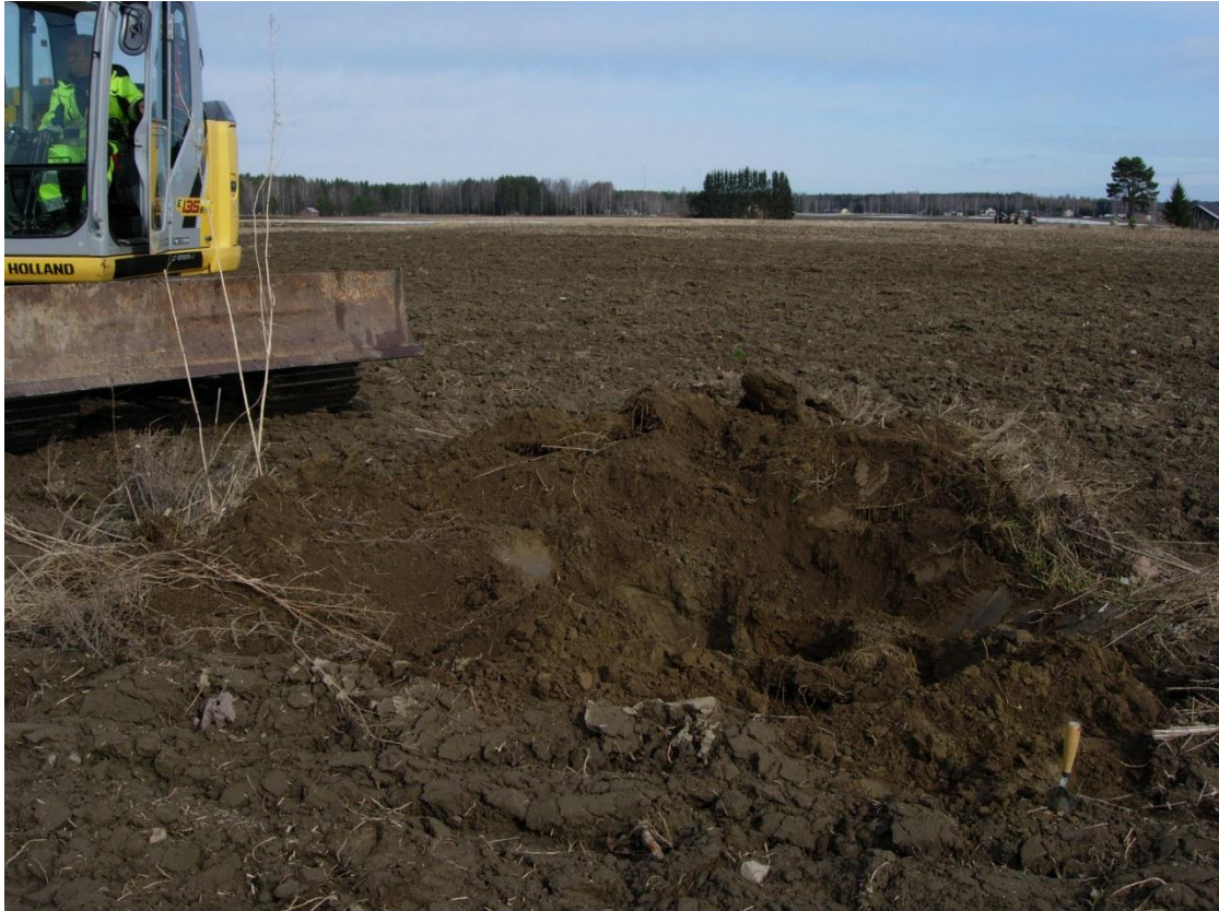
Kuva 5. Maannos pylvään 2 kohdalla oli hienoa hiesua aina 60 cm syvyyteen saakka. (Pälkäne Rauniokirkko ja Tiililä, sähköpylväiden poistamisen arkeologinen valvonta 2013:5)
