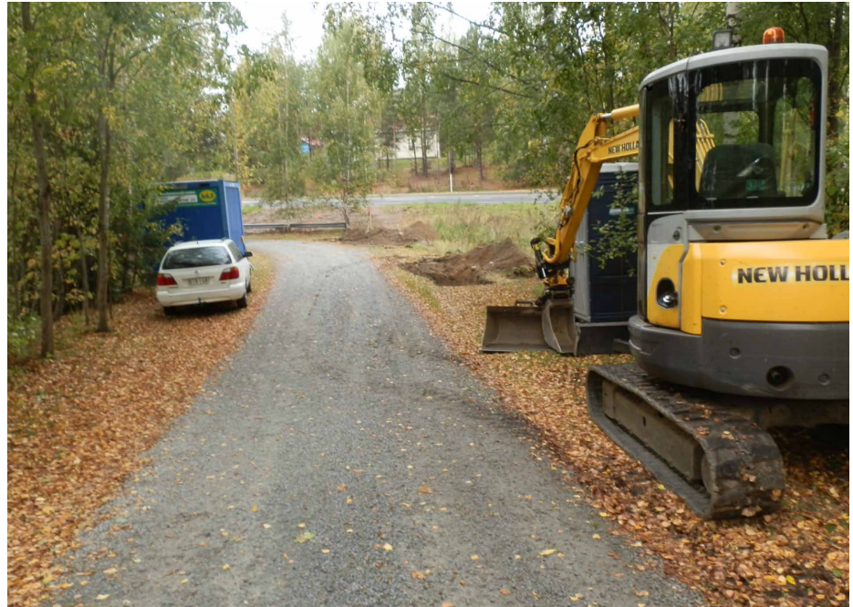
Kuva 5. A Koekaivausalue 3. Koekuoppia kaivetaan koneellisesti Sarsankujan luoteispäässä. Kuva Jouko Pukkila 2013.
