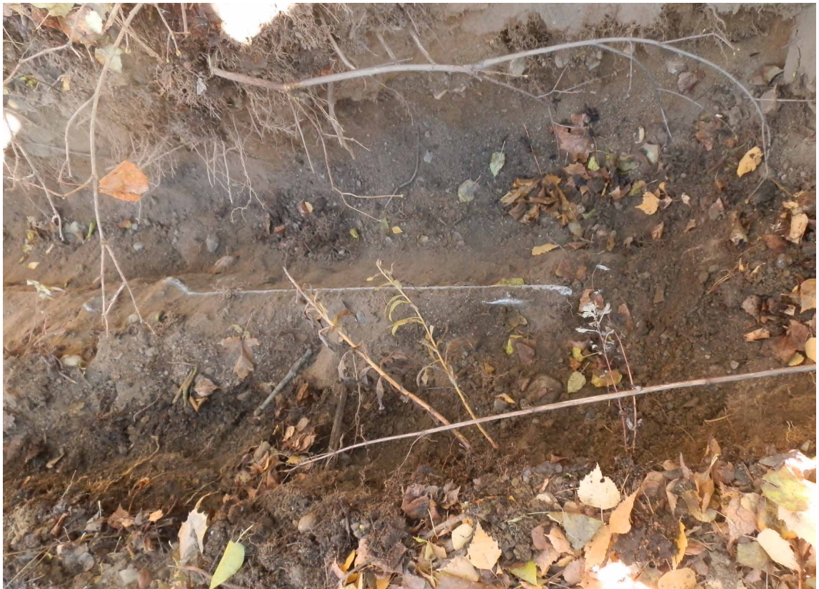
Kuva 3: Betoninen avokouru. Kuva: Jouko Pukkila 2013.
