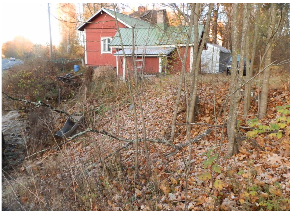
Kuva 13: Kaivannon keskivaiheilla oli maa-aineksen oton tuloksena syntyneitä kuoppia, joita on täytetty maalla ja mm. rakennusjätteellä. Kuva: Jouko Pukkila 2013.
