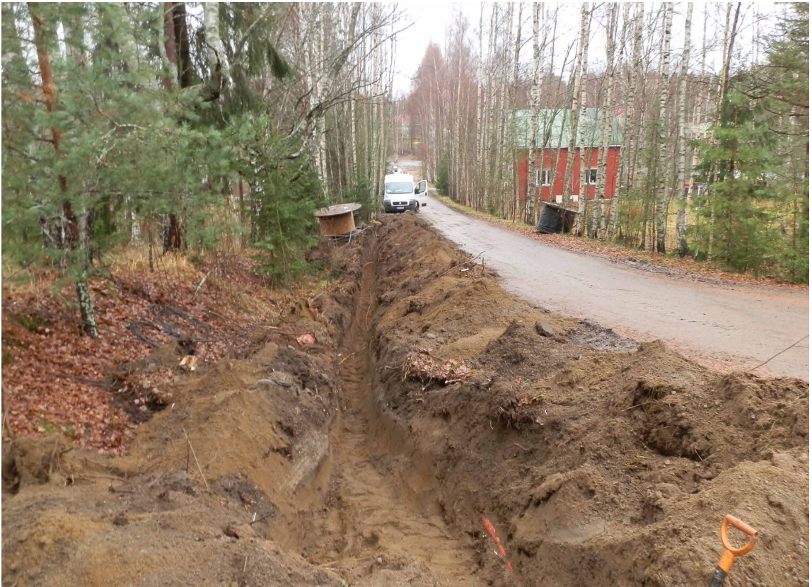
Kuva 19: Sarsankujan kaakkoispäässä valvottu osuus kaapelikaivannosta. Kuva: Jouko Pukkila 2013.
